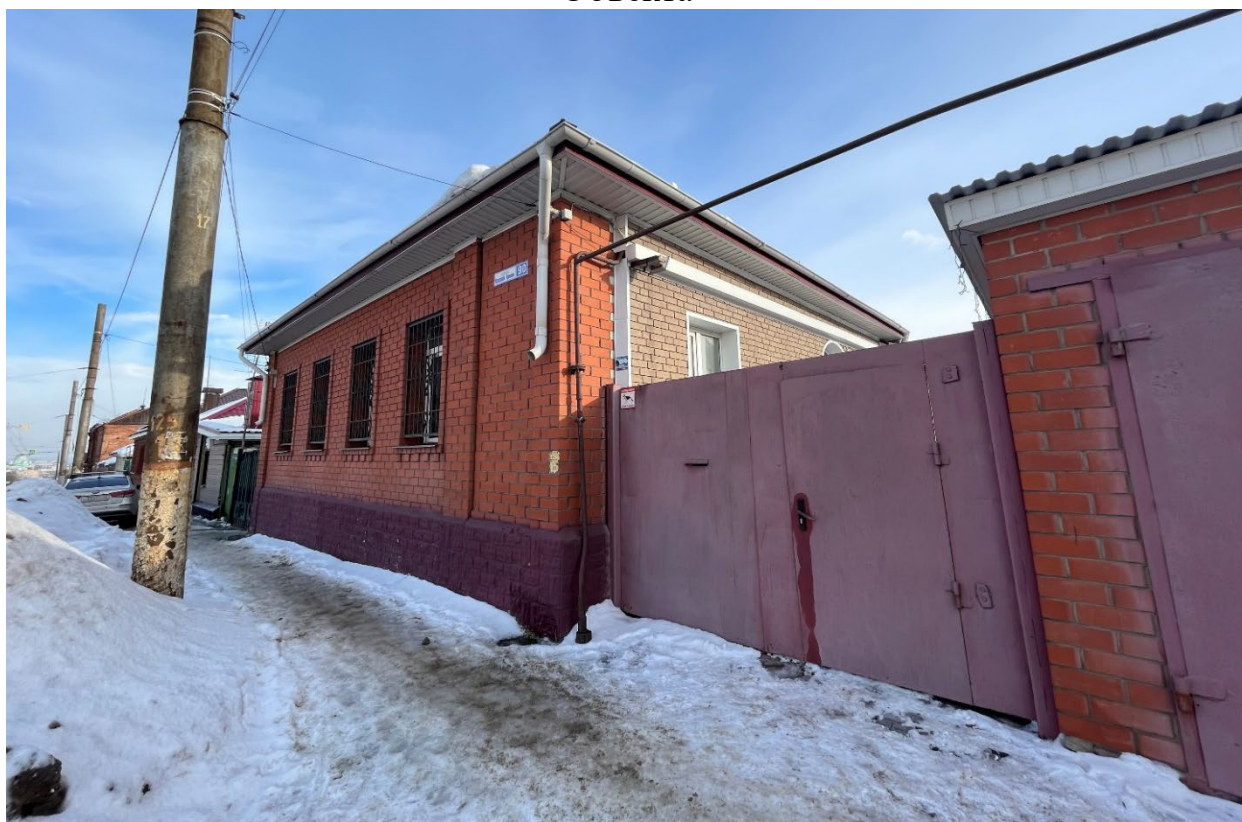
Т.ф. 8. Вид с северо-запада со стороны ул. Красной Армии на главный и боковой фасады Объекта
