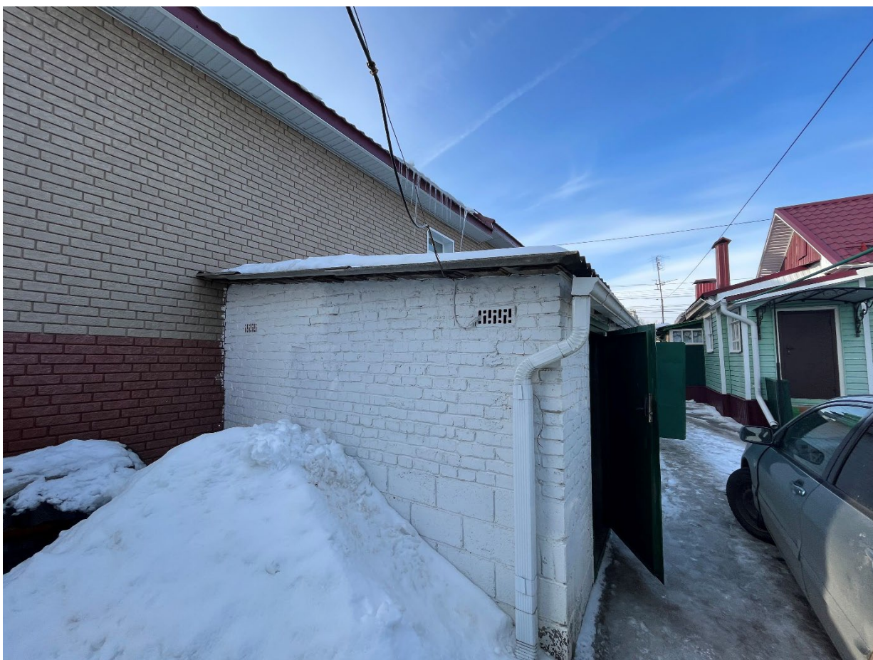
Т.ф. 12. Вид с юго-востока на северо-восточный фасад Объекта
