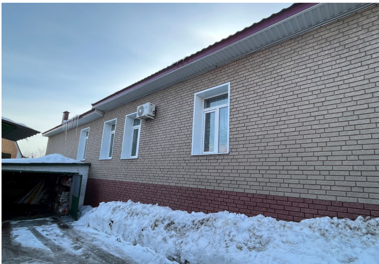
Т.ф. 16. Вид с севера на боковой северо-восточный фасад Объекта
