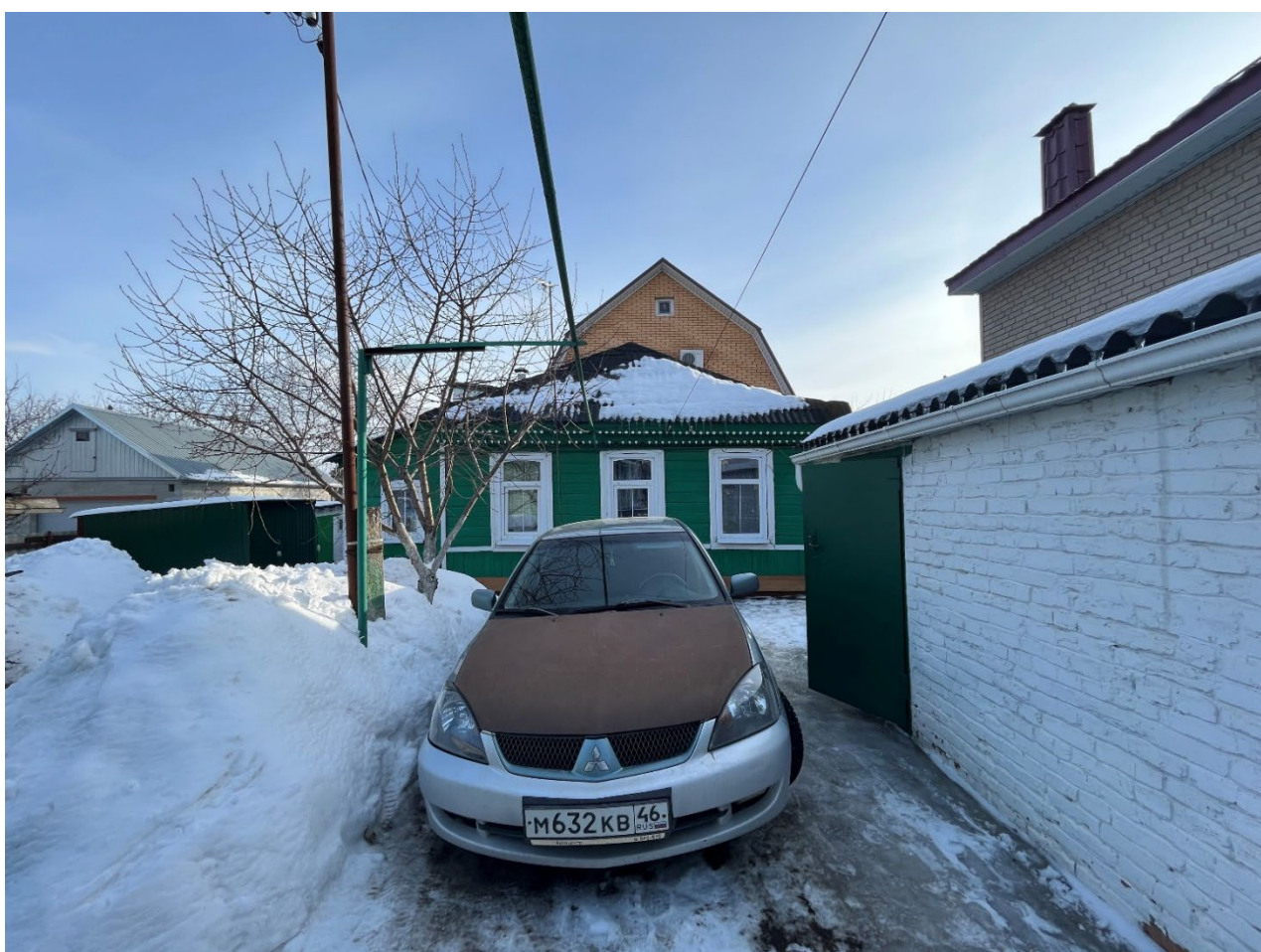
Т.ф. 14. Вид с северо-запада со стороны ул. Красной Армии во двор Объекта
