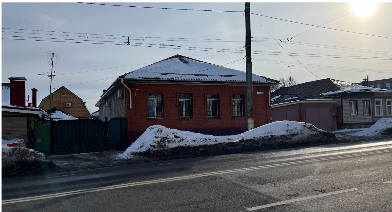
Т.ф. 5. Вид с севера со стороны ул. Красной Армии на главный фасад Объекта
