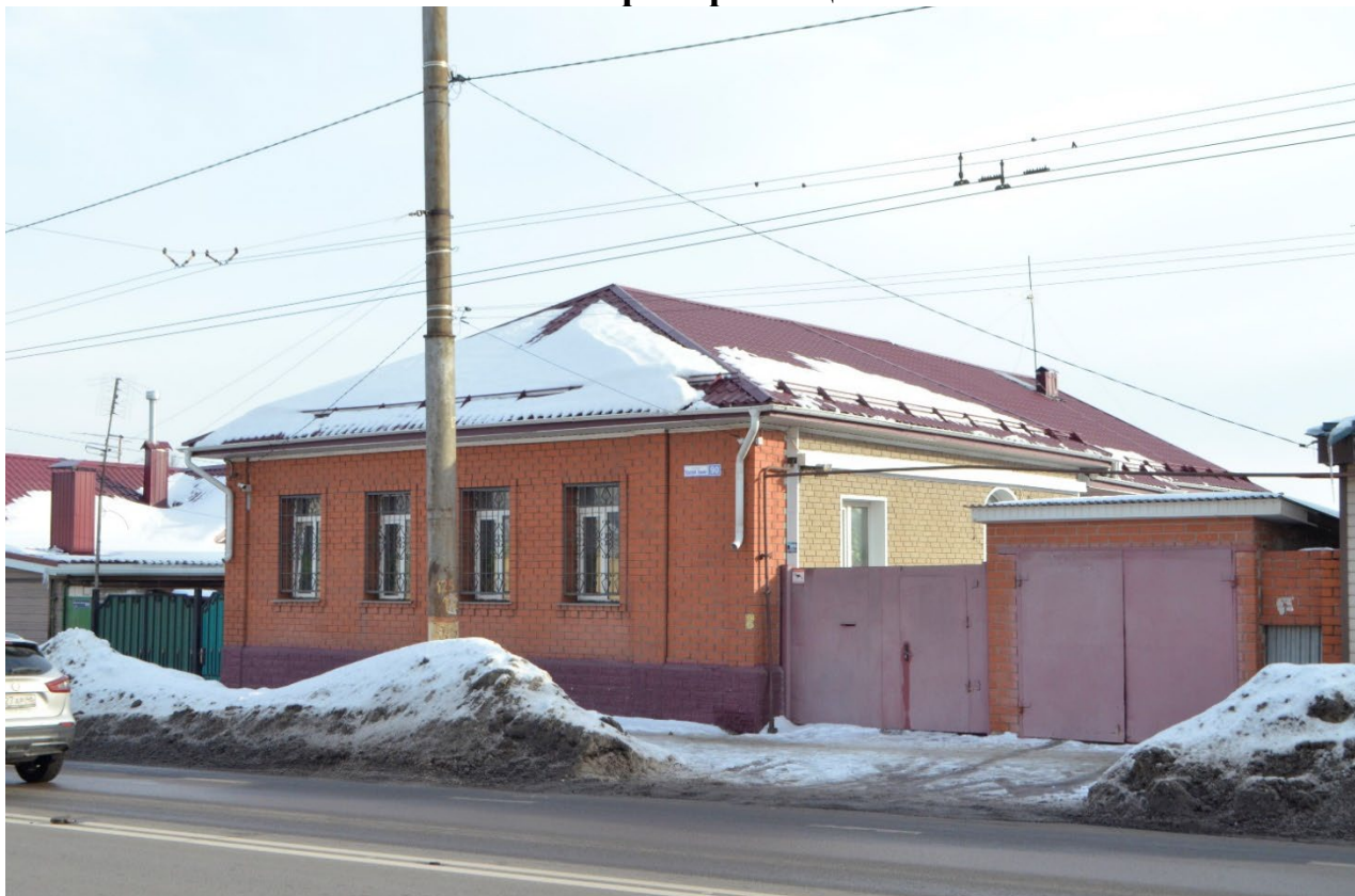
Т.ф. 1. Вид с северо-запада со стороны ул. Красной Армии на главный фасад Объекта
