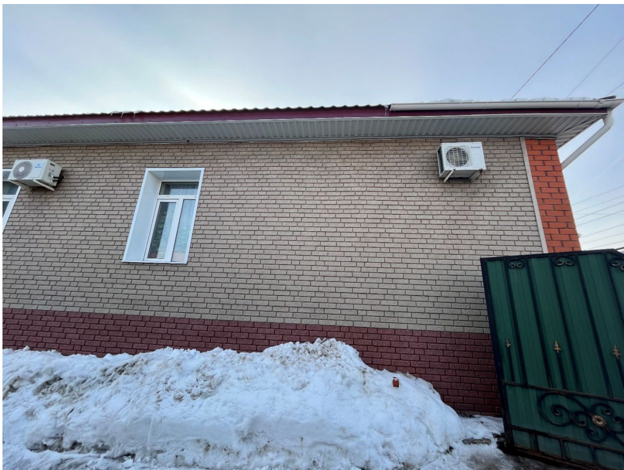
Т.ф. 15. Вид с северо-востока на боковой фасад Объекта
