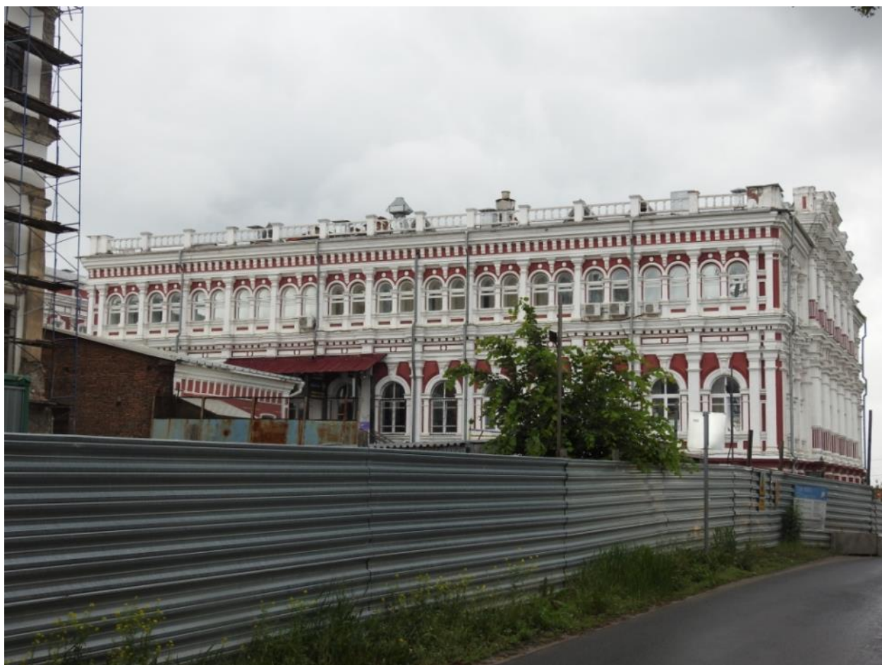
Общий вид юго-западного фасада
