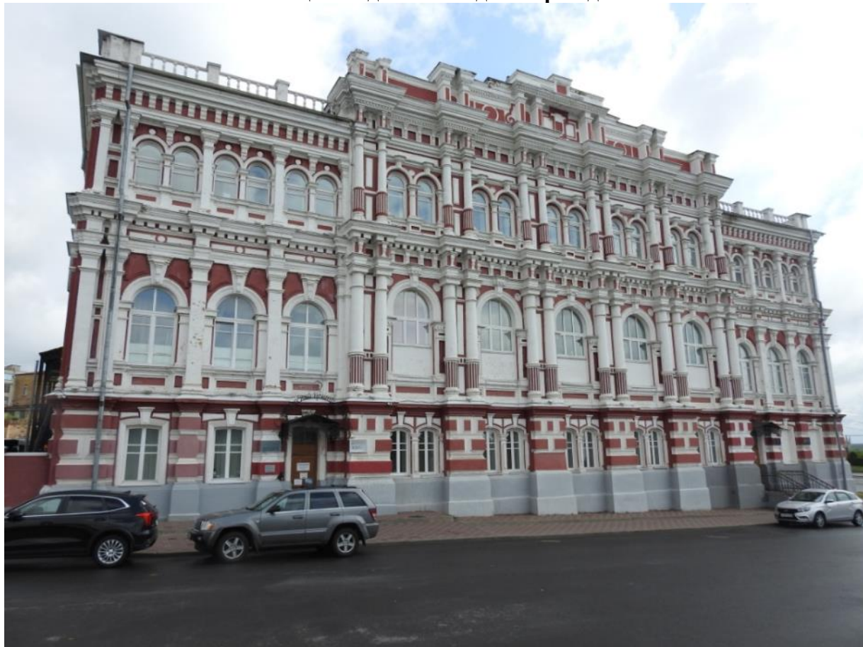
Общий вид юго-западного фасада
