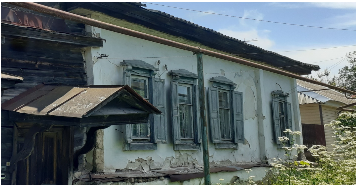
Фотография № 9. Вид с северо-запада на Объект.
