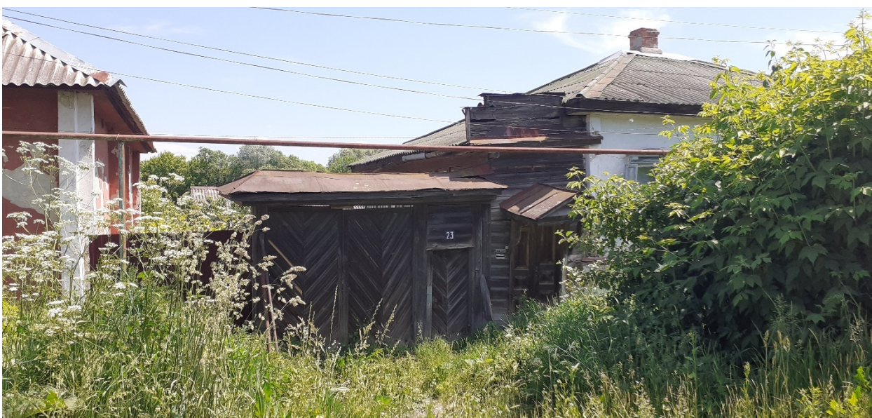
Фотография № 6. Вид с северо-запада на Объект.
