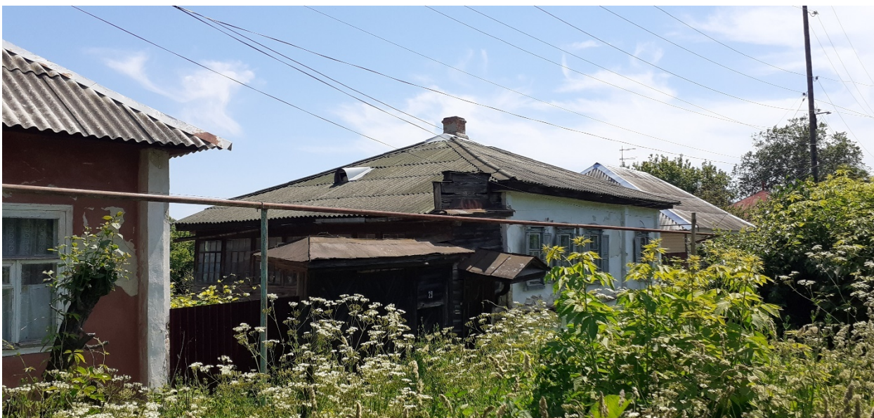
Фотография № 10. Вид с северо-запада на Объект.
