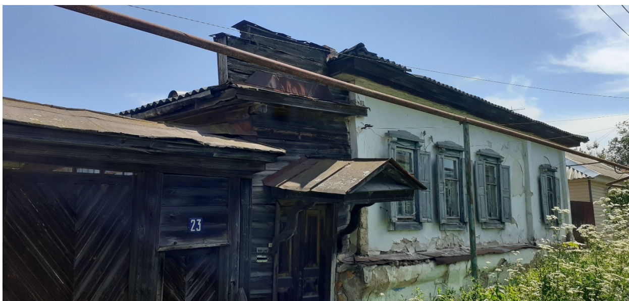
Фотография № 8. Вид с северо-запада на Объект.
