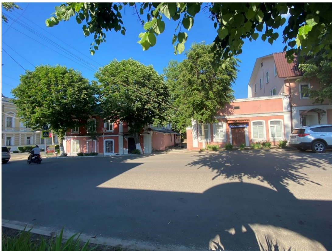
Фотография № 2. Вид с юго-запада на Объект.
