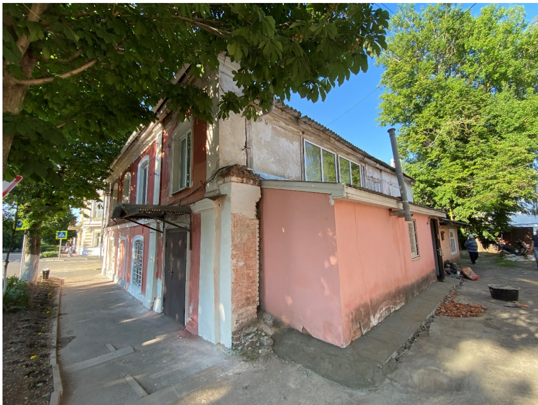
Фотография № 3. Вид с юго-запада на Объект.
