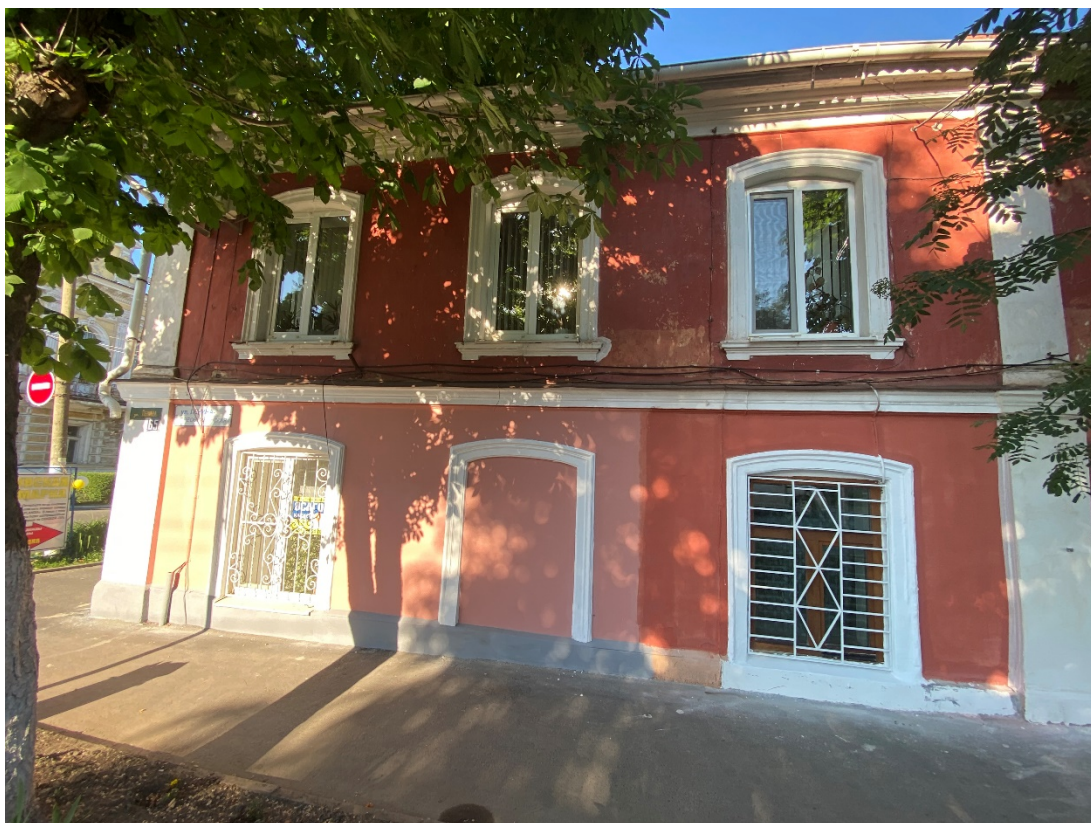
Фотография № 13. Вид с запада на Объект. Западный фасад. Фрагмент.
