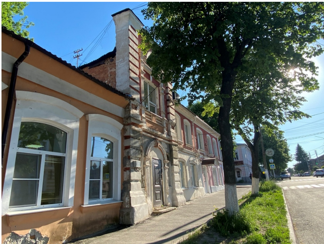
Фотография № 11. Вид с востока на Объект. Северный фасад.
