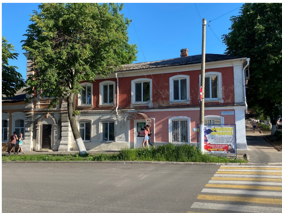
Фотография № 10. Вид с севера на Объект. Северный фасад.
