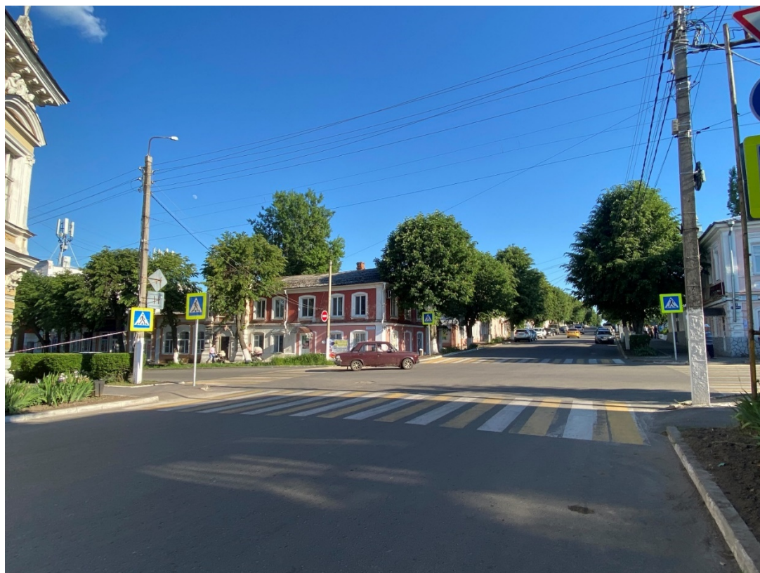
Фотография № 9. Вид с севера на Объект.
