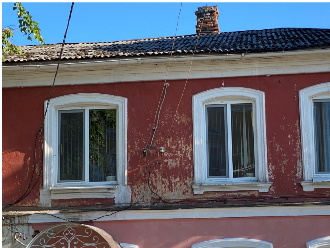
Фотография № 14. Вид с севера на Объект. Северный фасад. Фрагмент.
