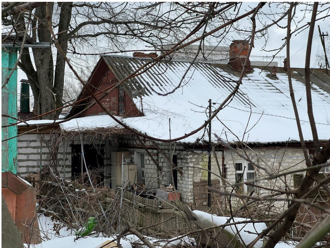
Фотография № 5. Вид с северо-востока на Объект.
