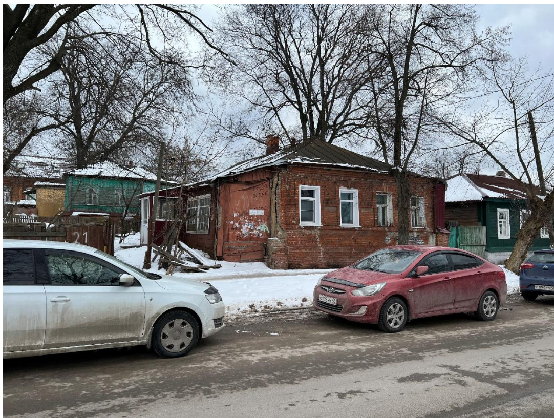
Фотография № 2. Вид с северо-запада на Объект.
