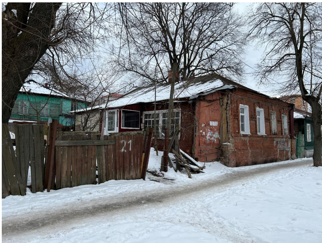
Фотография № 3. Вид с северо-запада на Объект.
