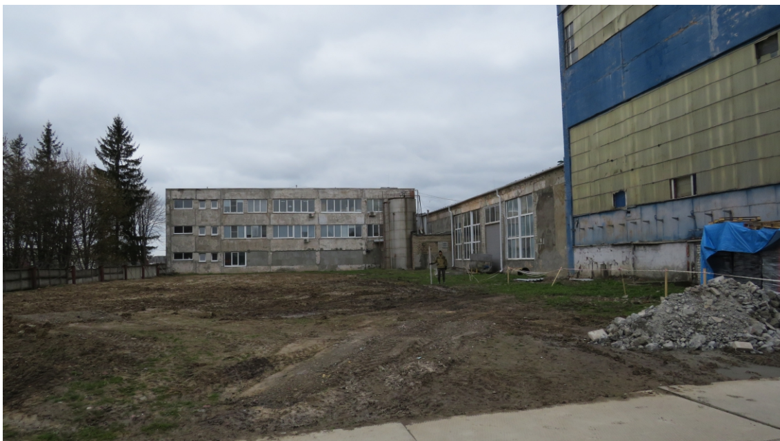
Рис.14. Курская область, г. Железногорск, ул. Рокоссовского, дом 45. Земельный участок с кадастровым номером 46:30:000028:195 в рамках капитального строительства. Точка фотофиксации 6. Вид с юго-востока.
