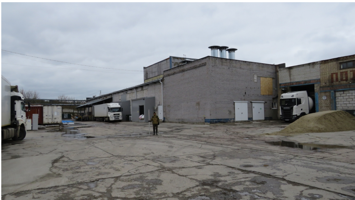
Рис.12. Курская область, г. Железногорск, ул. Рокоссовского, дом 45. Земельный участок с кадастровым номером 46:30:000028:195 в рамках капитального строительства. Точка фотофиксации 4. Вид с севера.
