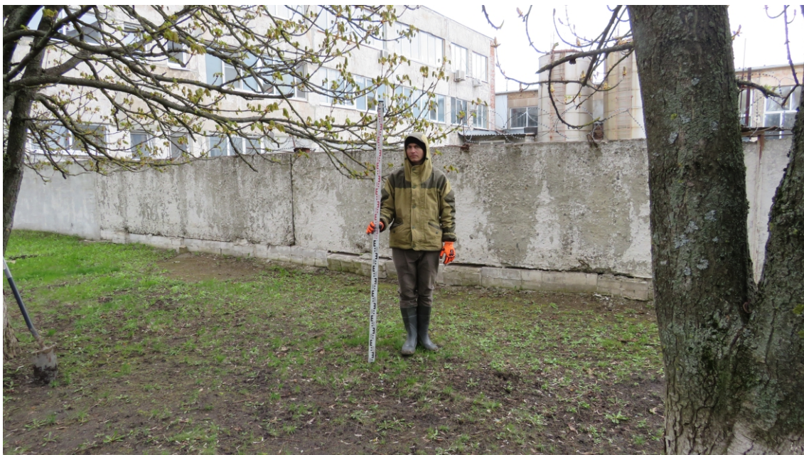
Рис.22. Курская область, г. Железногорск, ул. Рокоссовского, дом 45. Земельный участок с кадастровым номером 46:30:000028:195 в рамках капитального строительства. Местонахождение шурфа-1. Вид с юга.
