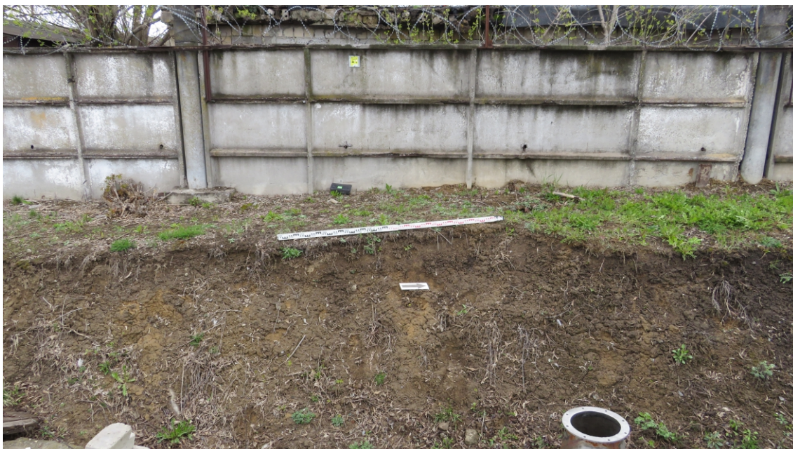
Рис.20. Курская область, г. Железнодорожск, ул. Рокоссовского, дом 45. Земельный участок с кадастровым номером 46:30:000028:195 в рамках капитального строительства. Место закладки зачистки-1. Вид с востока.
