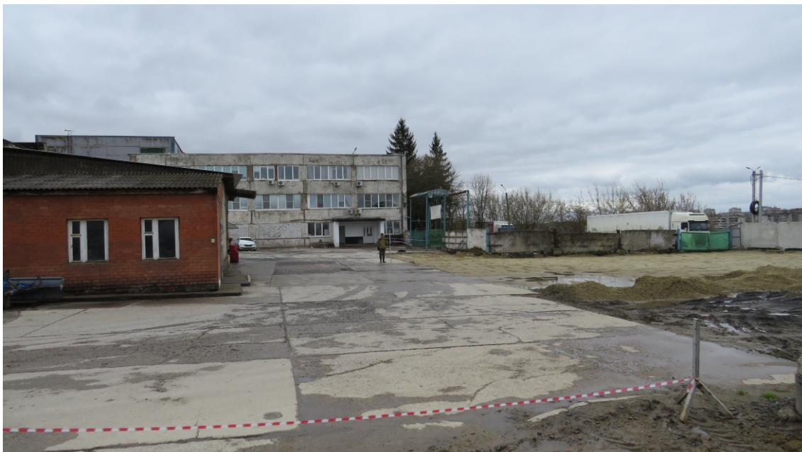
Рис.9. Курская область, г. Железногорск, ул. Рокоссовского, дом 45. Земельный участок с кадастровым номером 46:30:000028:195 в рамках капитального строительства. Точка фотофиксации 1. Вид с северо-запада.
