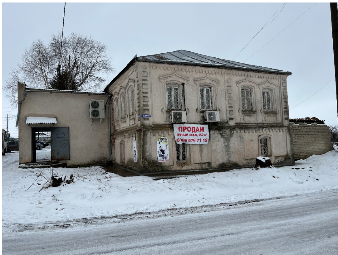
Фотография № 5. Вид с востока на Объект.
