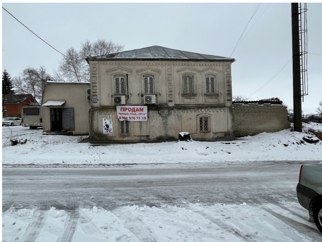
Фотография № 4. Вид с востока на Объект.
