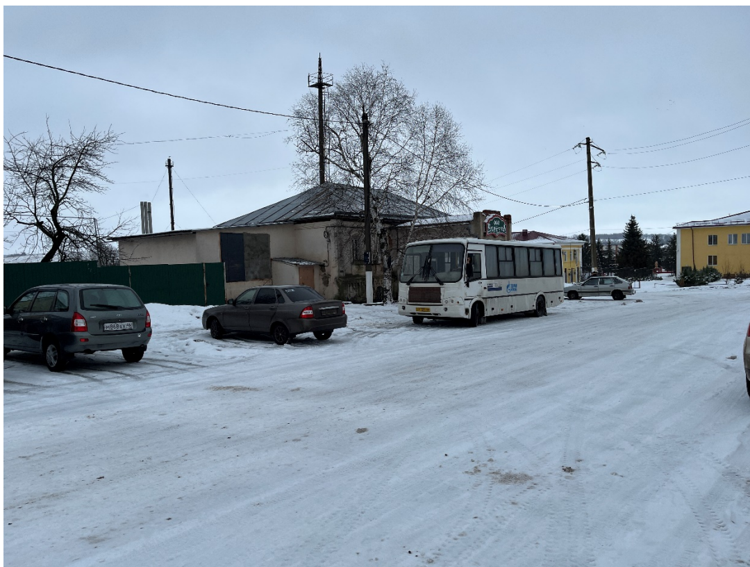
Фотография № 9. Вид с юго-запада на Объект.
