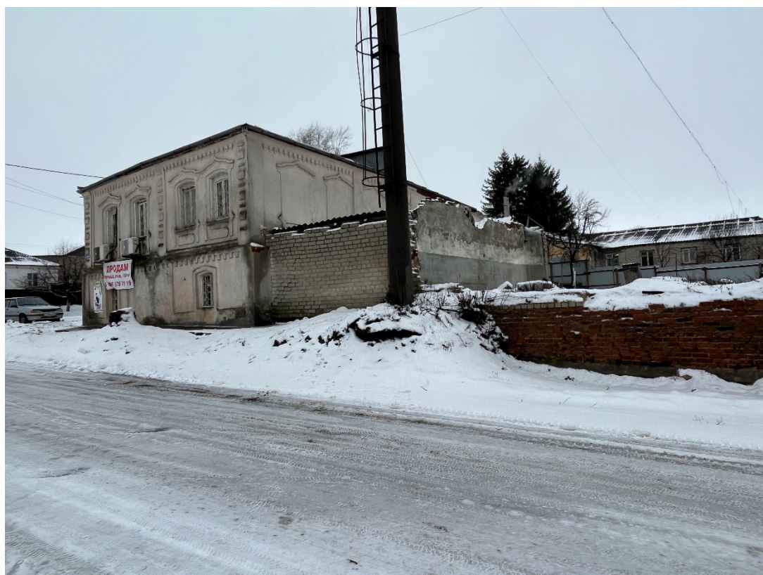
Фотография № 2. Вид с северо-востока на Объект.
