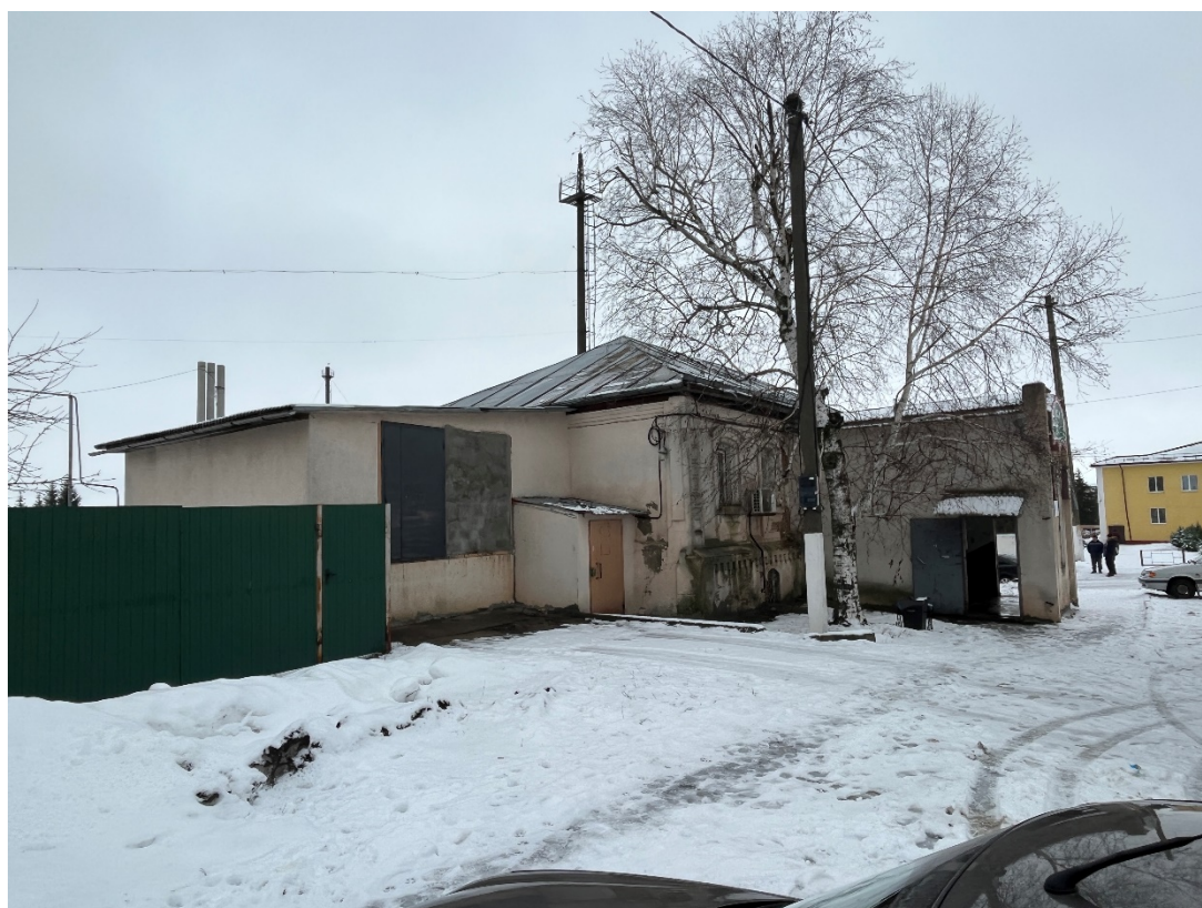
Фотография № 8. Вид с юго-запада на Объект.
