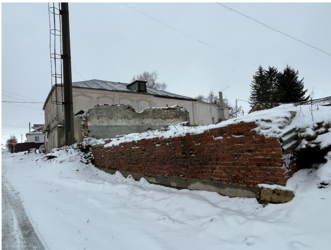
Фотография № 1. Вид с северо-востока на Объект.
