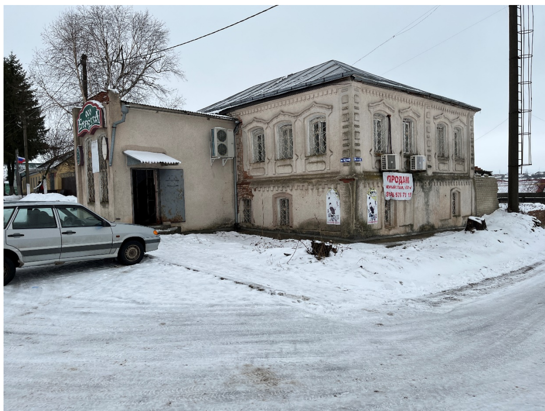
Фотография № 6. Вид с юго-востока на Объект.
