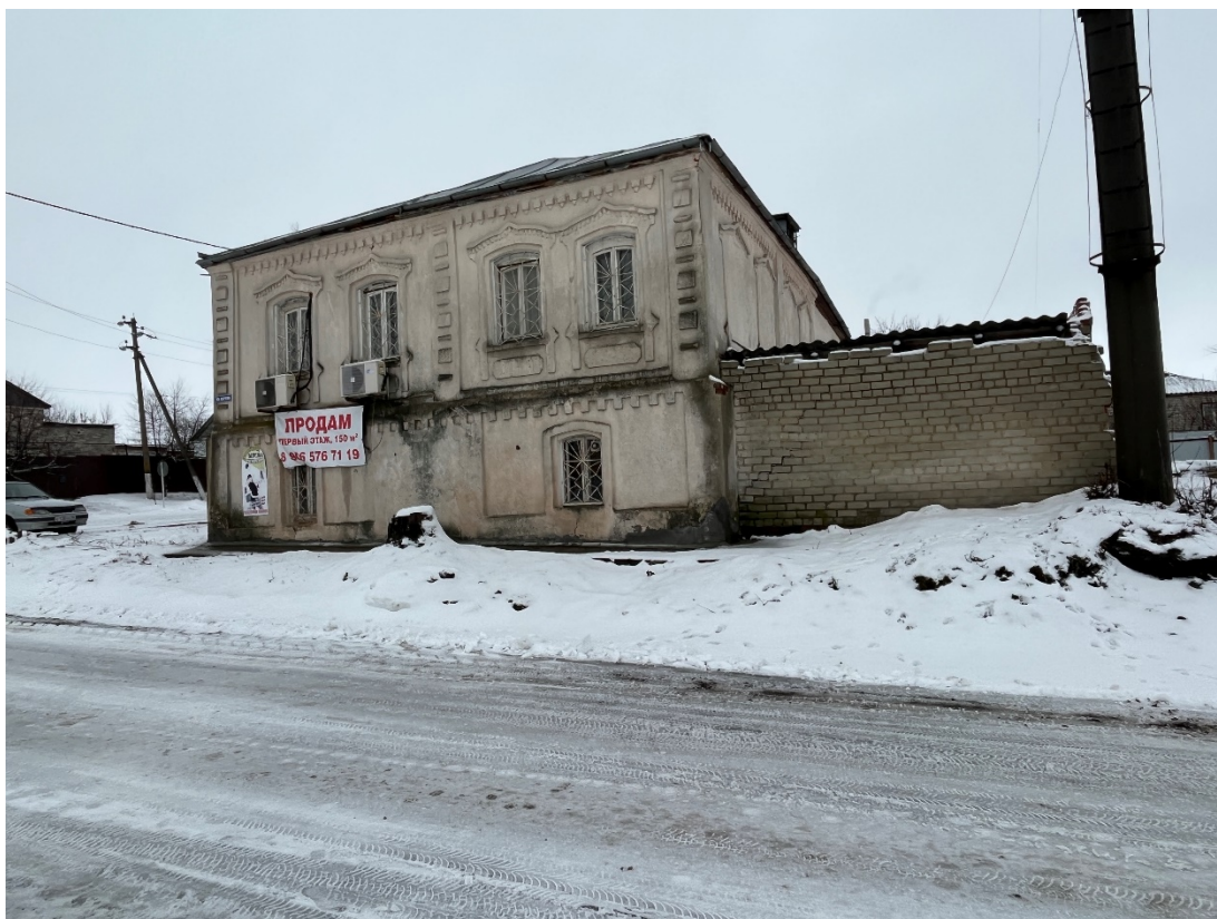
Фотография № 3. Вид с северо-востока на Объект.
