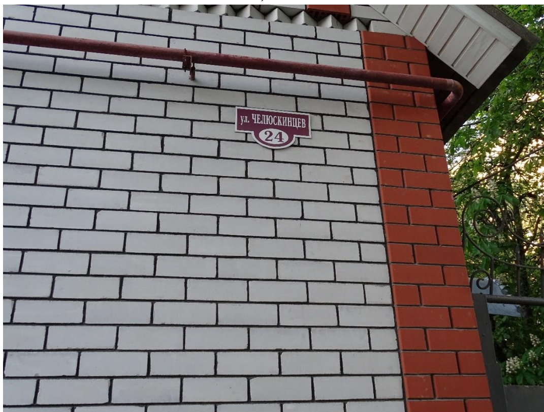
Фото 1.1 Номерной знак на фасаде Объекта.
