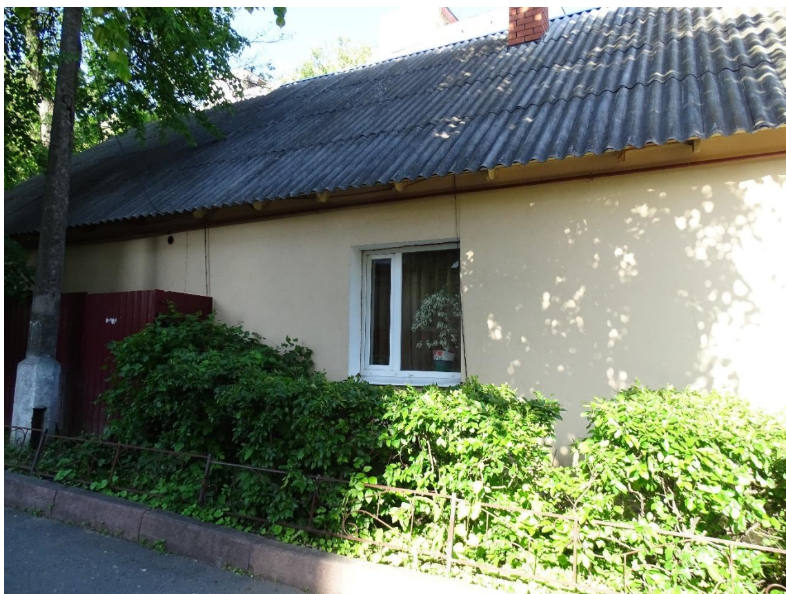
Фото 4. Западная стена Объекта
