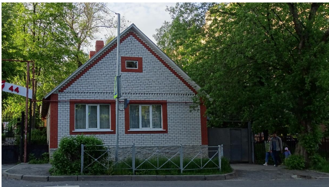
Фото 1. Общий вид Объекта.
