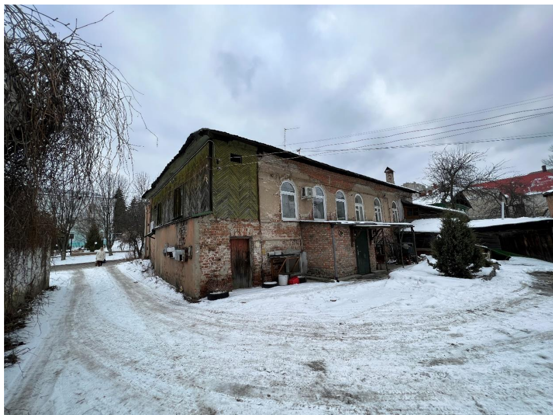
Фотография № 10. Вид с юго-востока на Объект.
