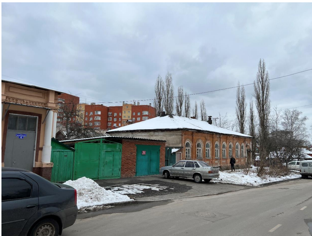
Фотография № 3. Вид с северо-запада на Объект.
