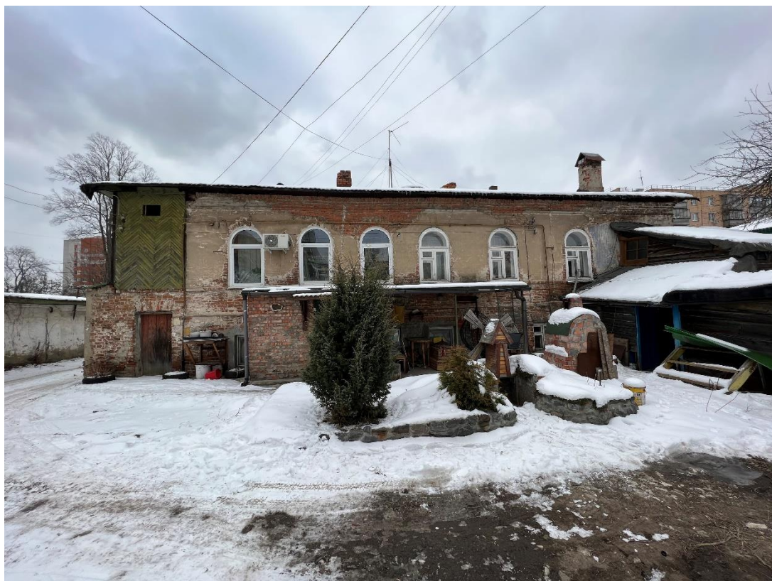
Фотография № 11. Вид с северо-востока на Объект.
