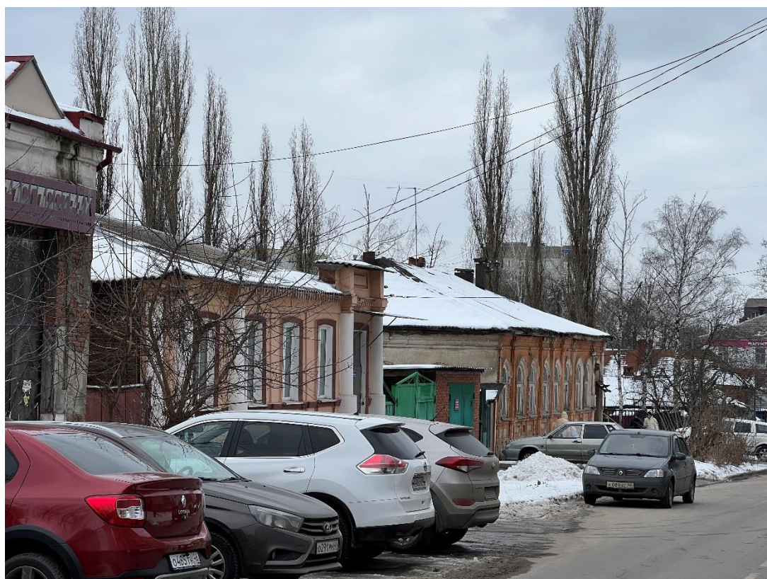
Фотография № 2. Вид с северо-запада на Объект.
