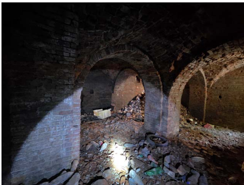
9. Вид с запада на восточную часть подвала.
