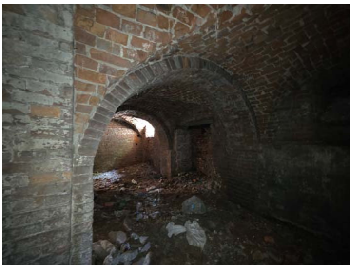
19. Вид на юго-восточную часть подвала.
