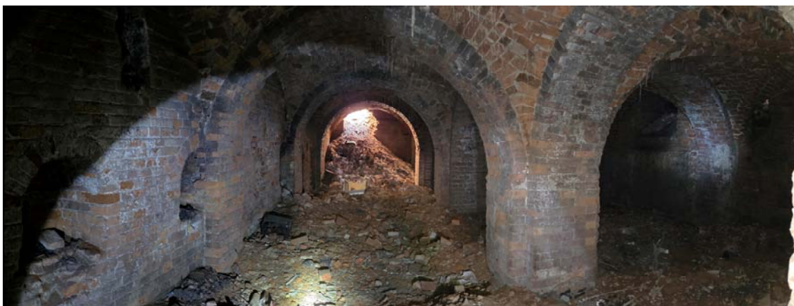
5. Вид с севера из центральной части подвала.
