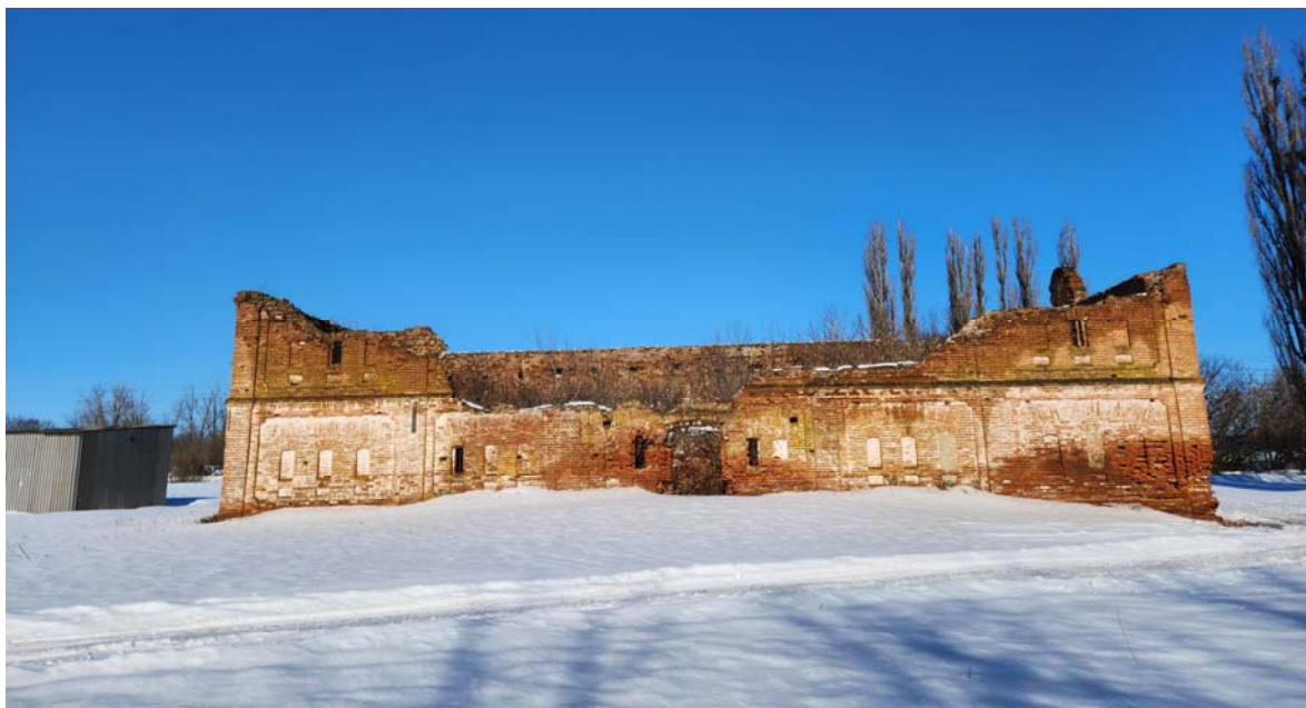
18.19. Вид с юго-запада и запада.
