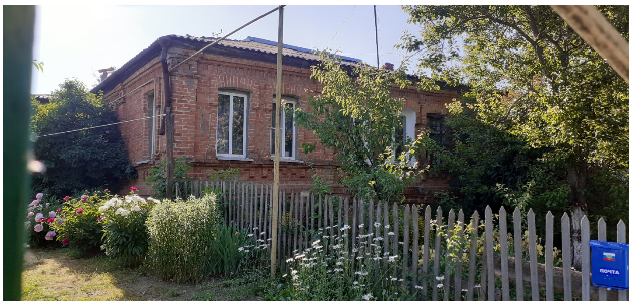
Фотография № 4. Вид с юго-востока на Объект.
