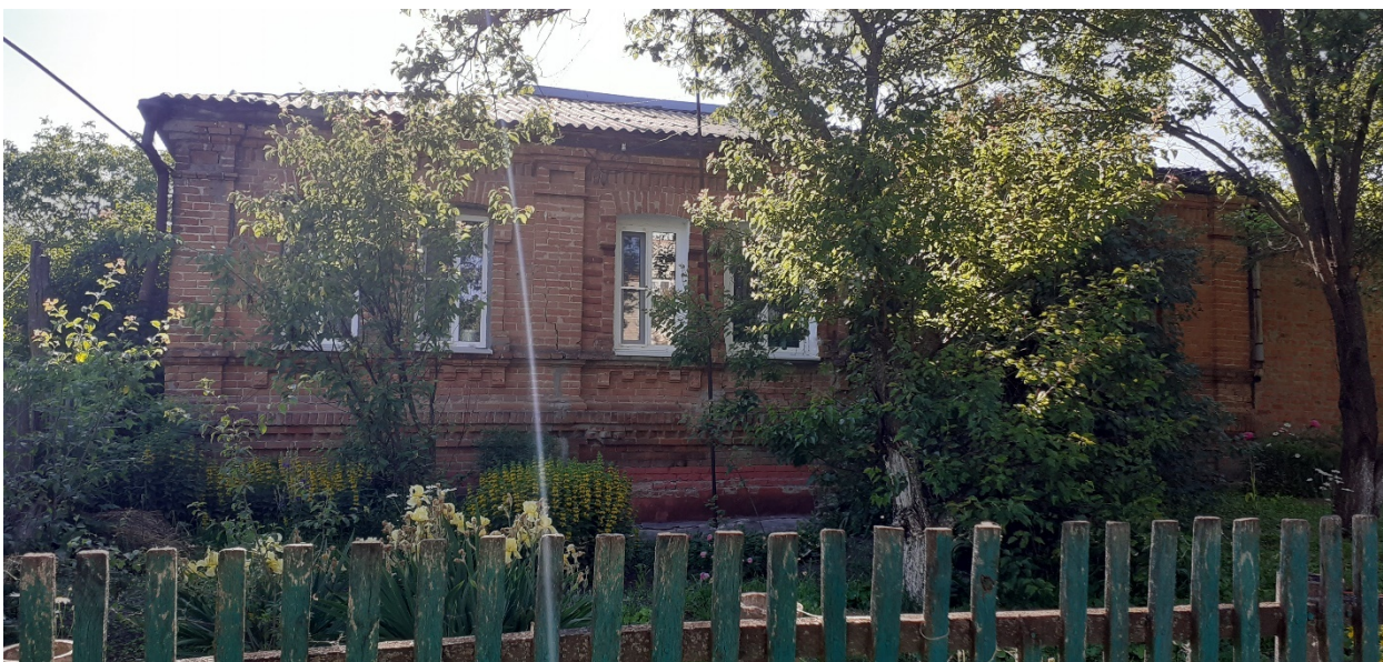
Фотография № 6. Вид с востока на Объект.
