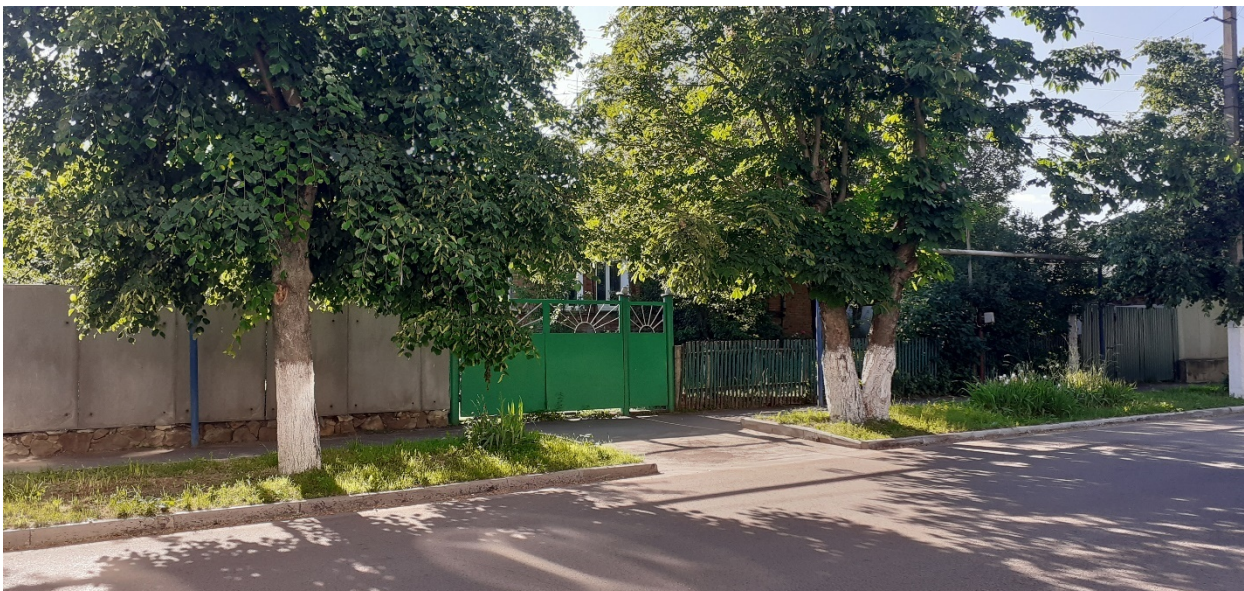
Фотография № 1. Вид с юго-востока на Объект.
