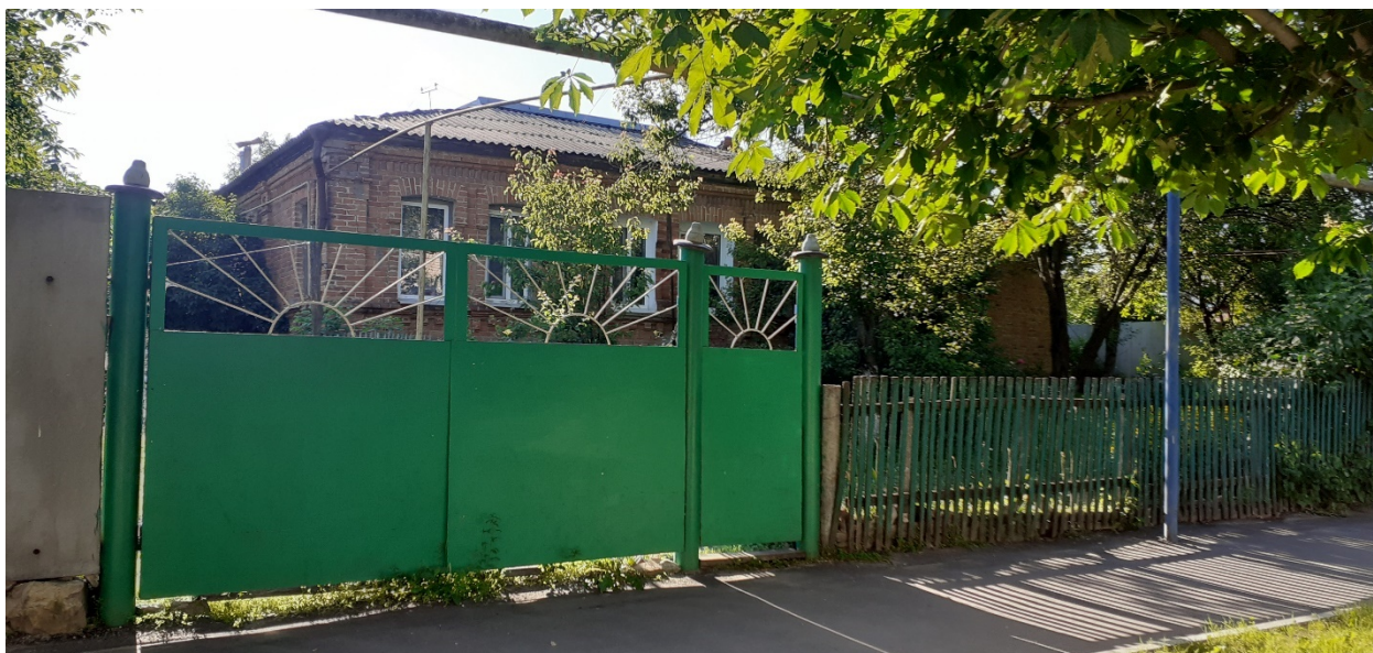
Фотография № 3. Вид с юго-востока на Объект.
