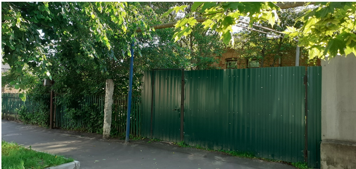
Фотография № 9. Вид с северо-востока на Объект.
