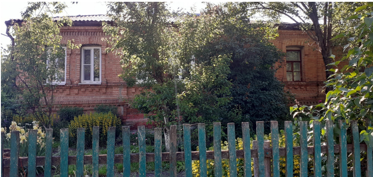
Фотография № 5. Вид с востока на Объект.
