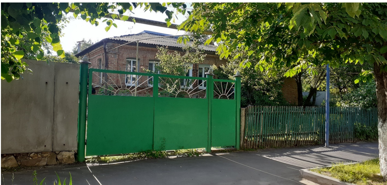
Фотография № 2. Вид с юго-востока на Объект.
