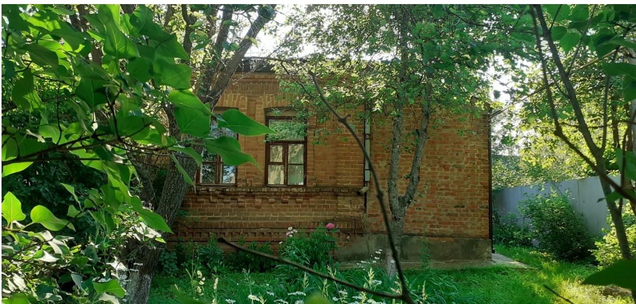
Фотография № 8. Вид с востока на Объект.
