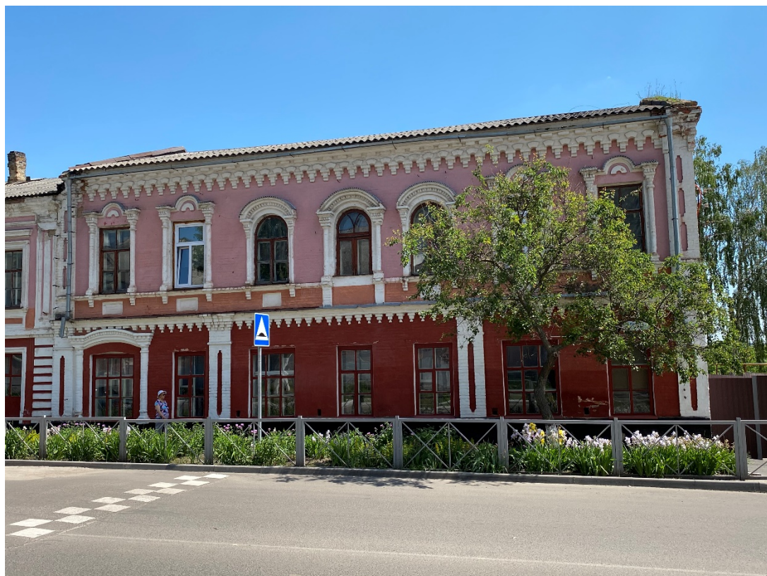
Фотография № 6. Вид с запада на Объект.
