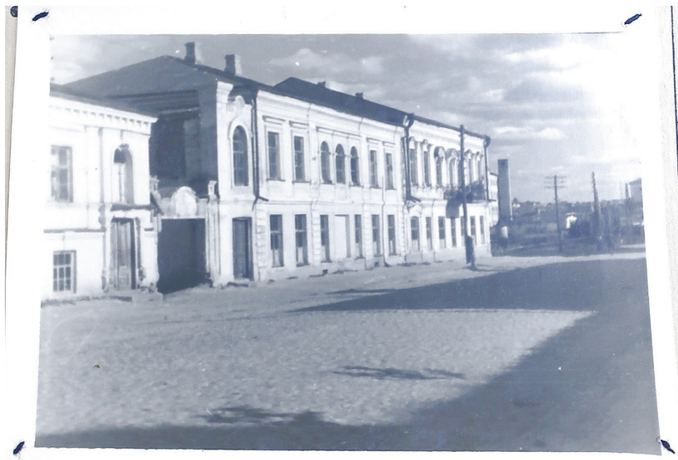
18. Фотография Объекта из технического паспорта. Фотография основного строения домовладения № 39 по улице К. Маркса в городе Рыльске, Курской области. Снимок произведен с фасадной стороны 10 июня 1954 г.
