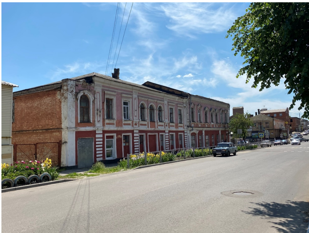
Фотография № 9. Вид с северо-запада на Объект.
