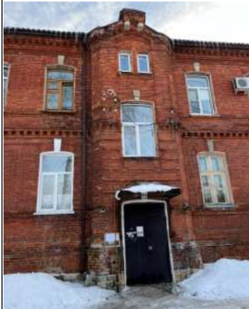
Западный фасад (фрагмент)
