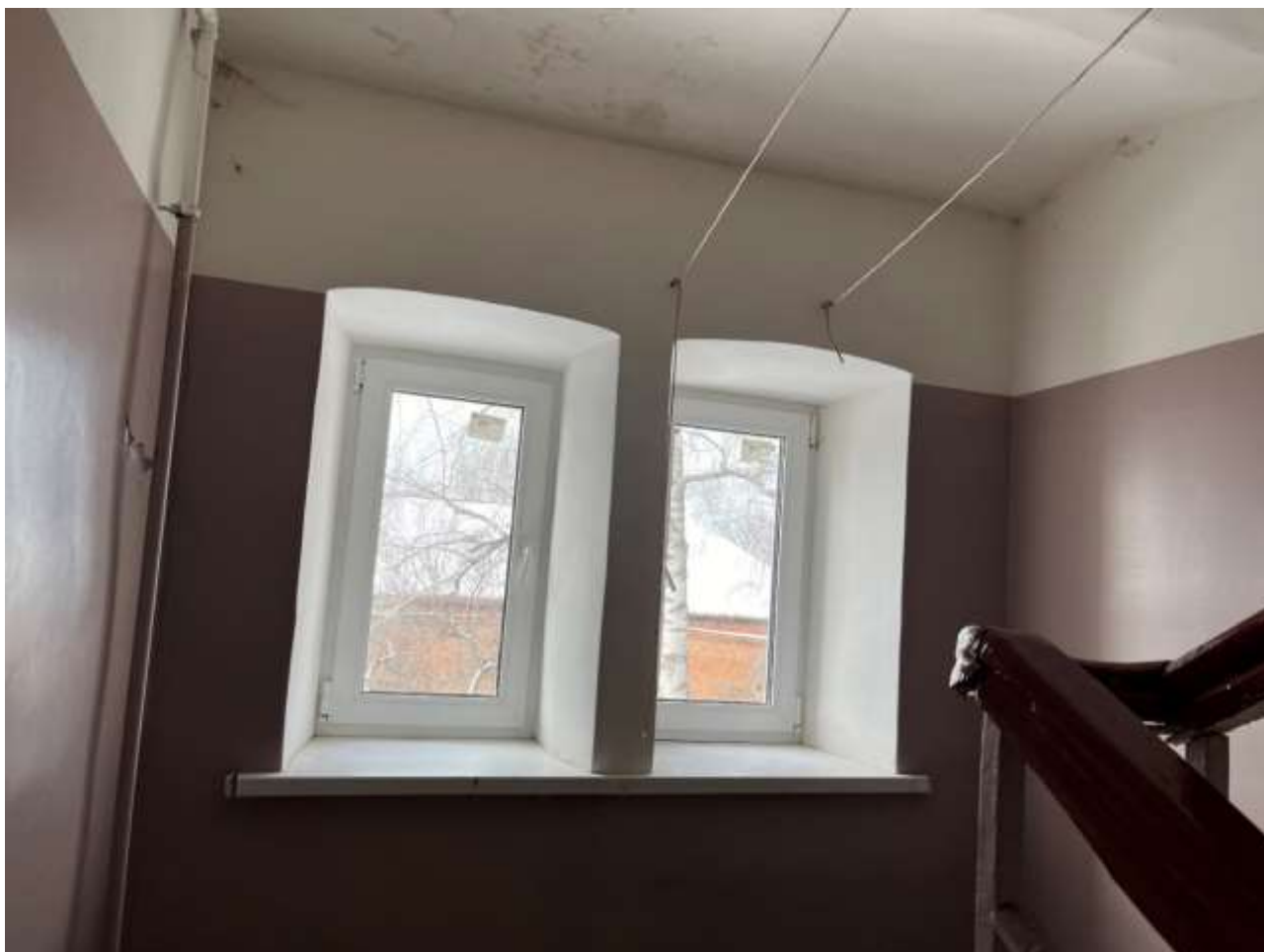
Т.ф. 17. Вид внутреннего помещения Объекта
