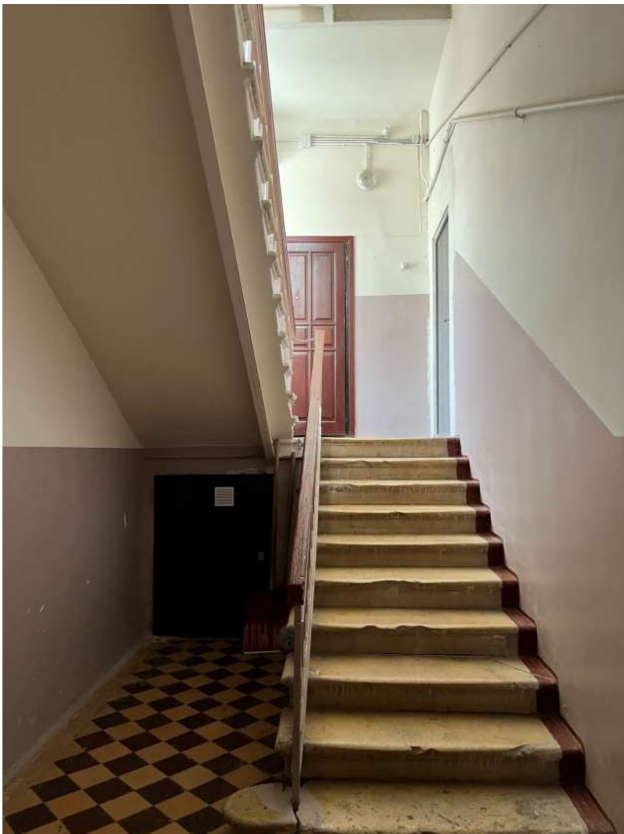
Т.ф. 11. Вид внутреннего помещения Объекта
