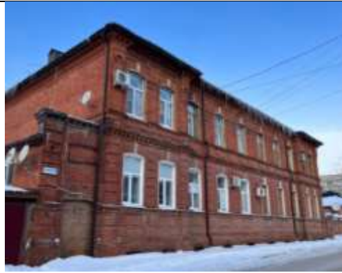
Восточный фасад. Вид с юго-востока
