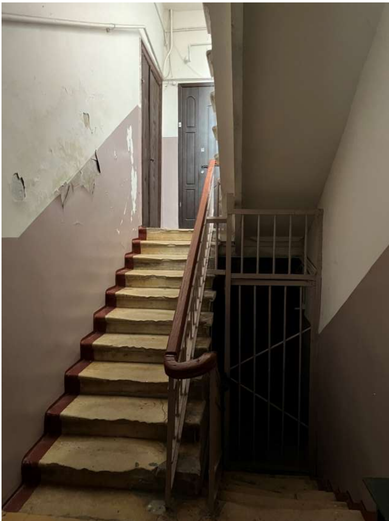
Т.ф. 14. Вид внутреннего помещения Объекта
