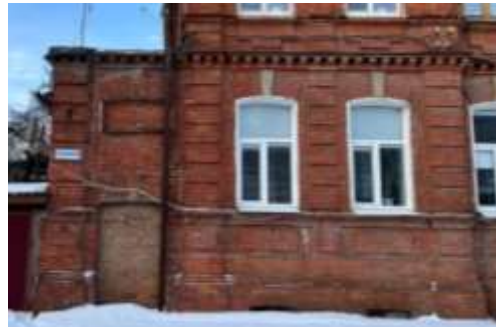
Восточный фасад (фрагмент)
