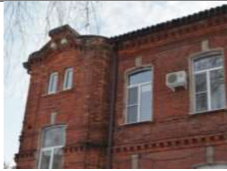
Западный фасад (фрагмент)
