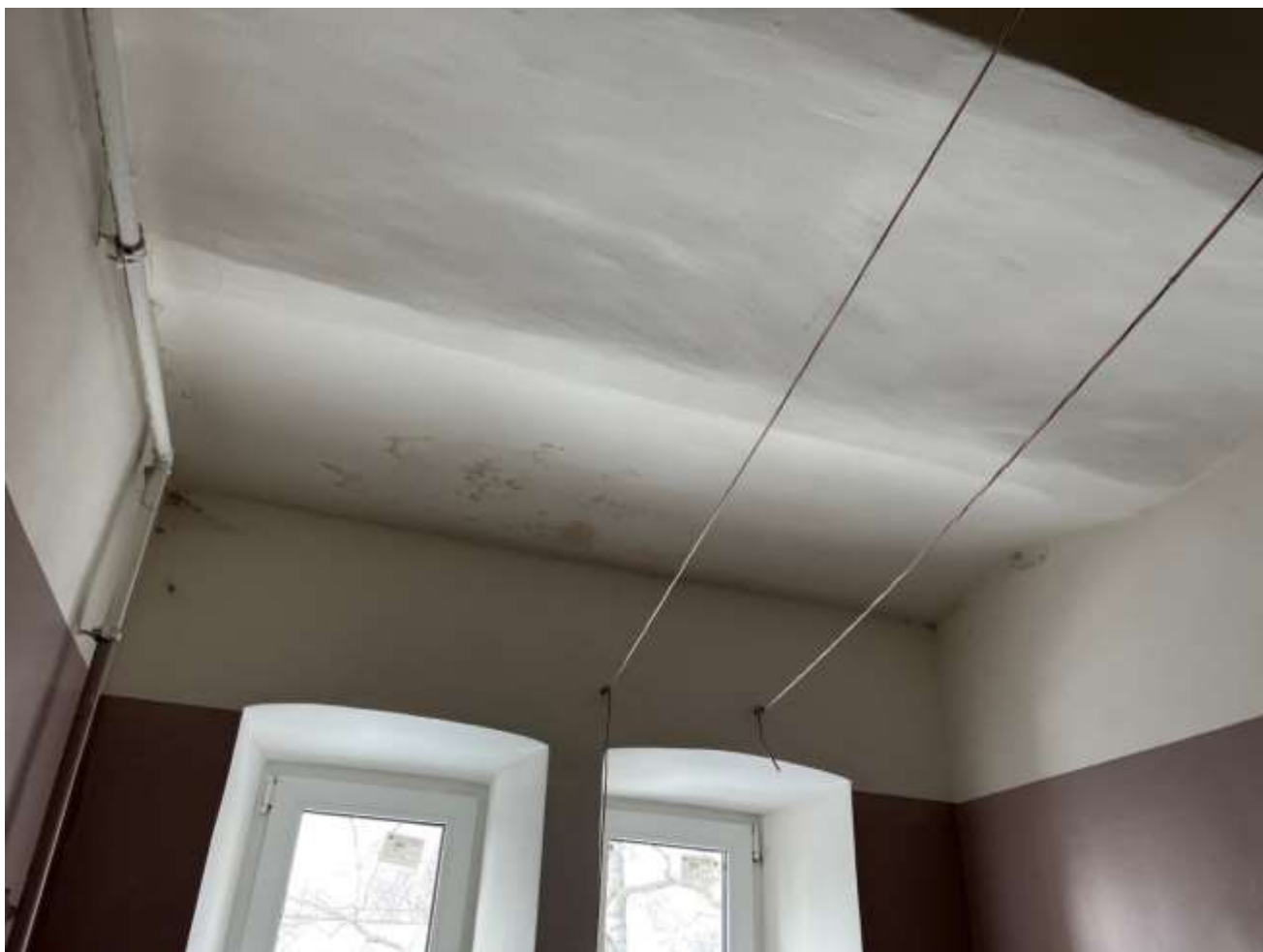
Т.ф. 18. Вид внутреннего помещения Объекта
