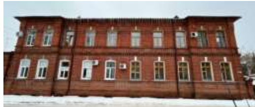
Восточный фасад (фрагмент)
