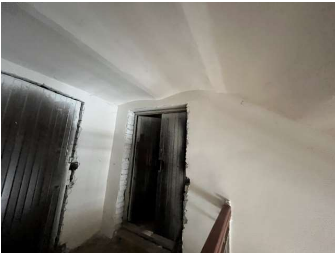
Т.ф. 19. Вид внутреннего помещения Объекта
