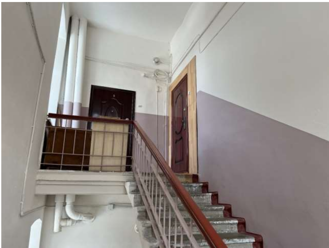
Т.ф. 12. Вид внутреннего помещения Объекта
