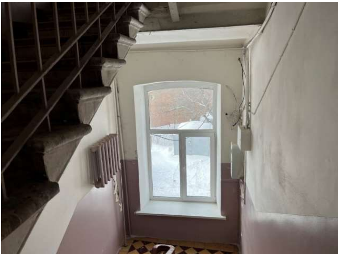
Т.ф. 20. Вид внутреннего помещения Объекта
