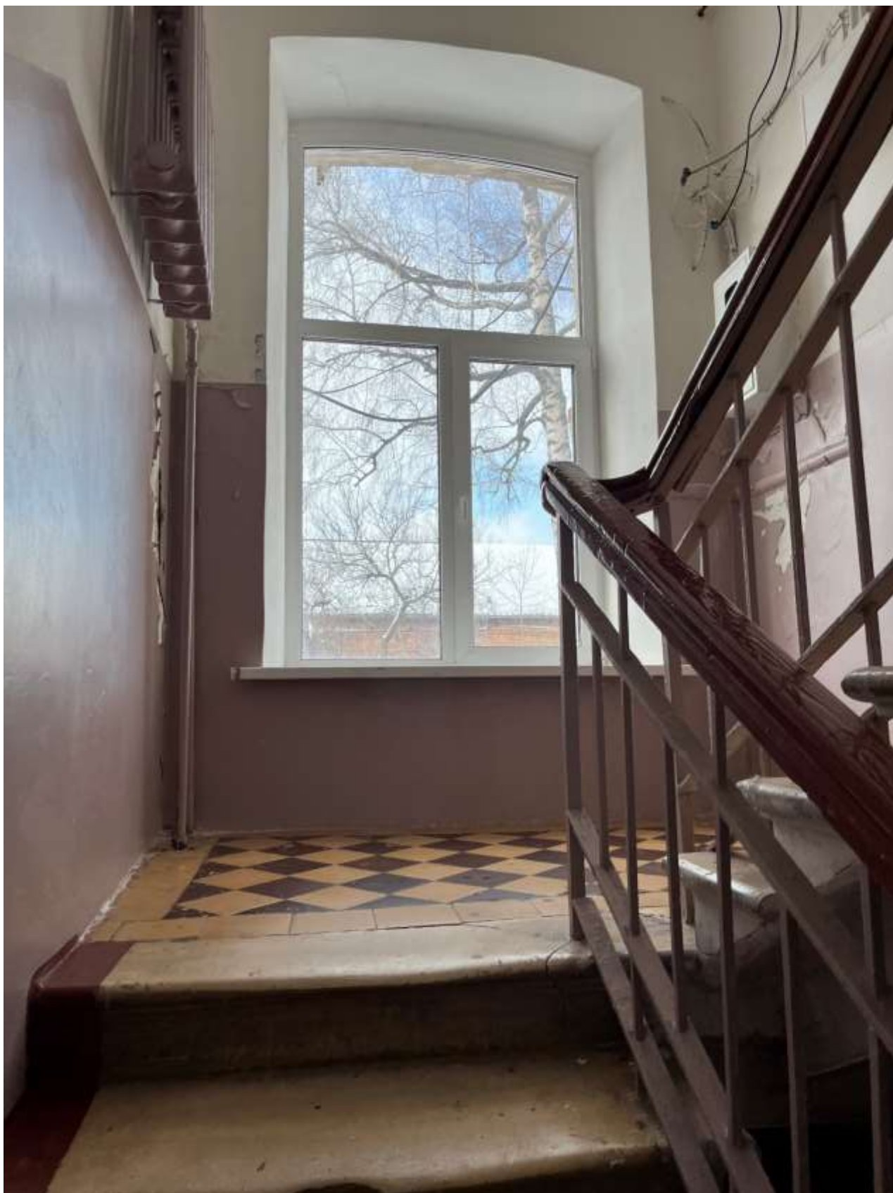
Т.ф. 15. Вид внутреннего помещения Объекта
