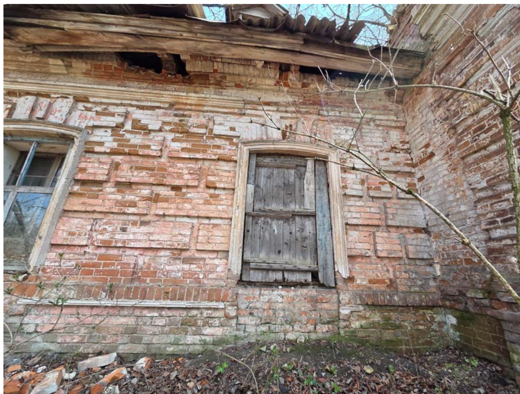
20. Вид с запада. Детали фасада. Примыкание северного корпуса к основному корпусу.
