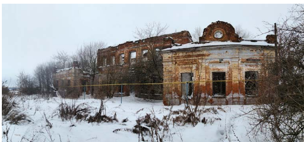
8. Главный дом. Вид с северо-востока.
