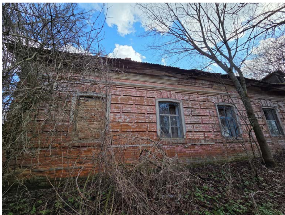
18. Вид с запада на северный корпус
