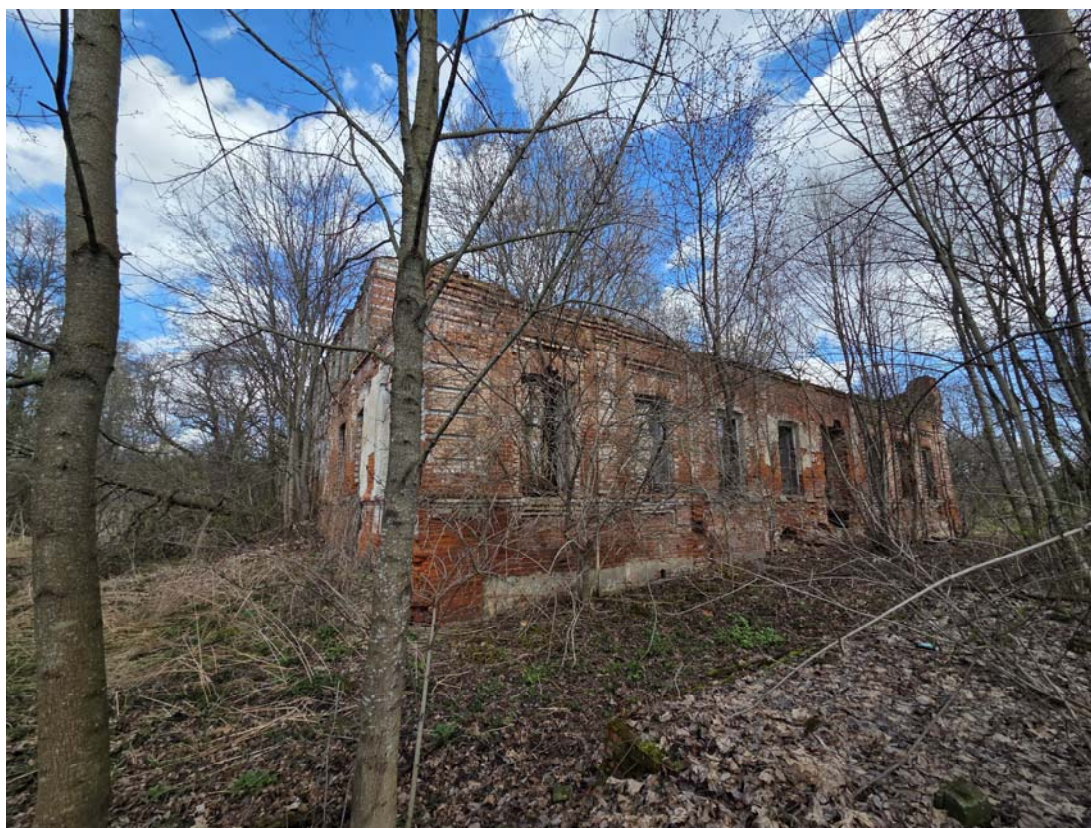
15. Главный дом. Вид с юго-запада на основной корпус.
