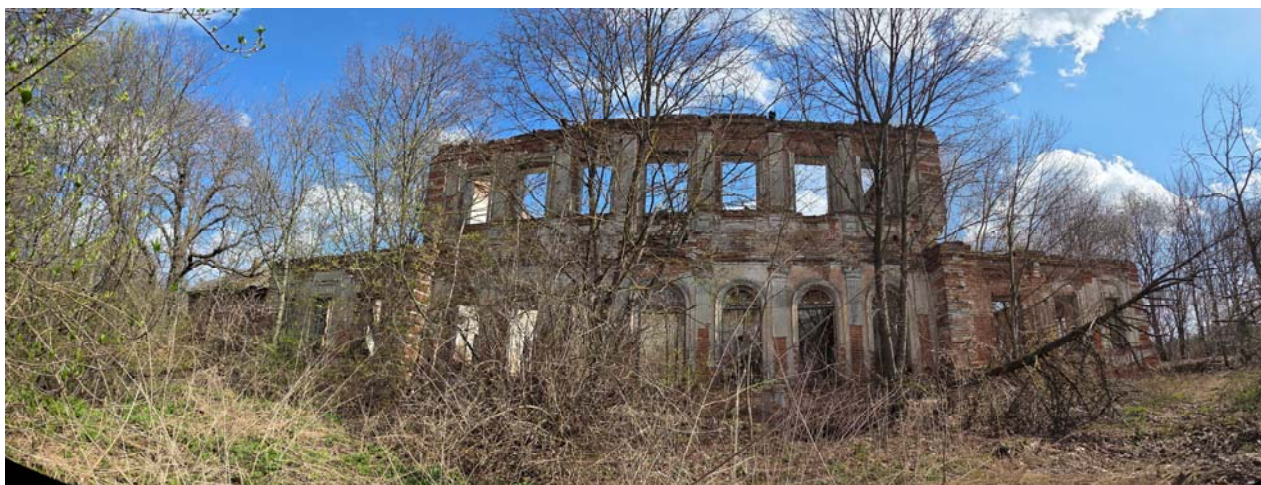
22. Вид с запада на центральную часть основного корпуса.
