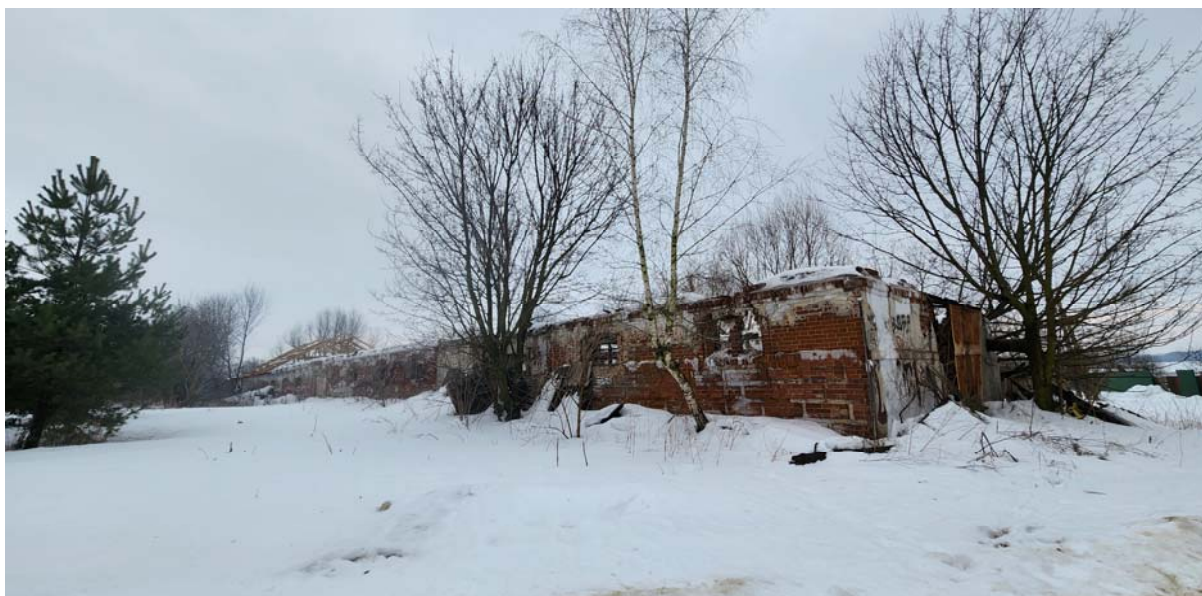
40. Конюшня. Вид с северо-запада.
