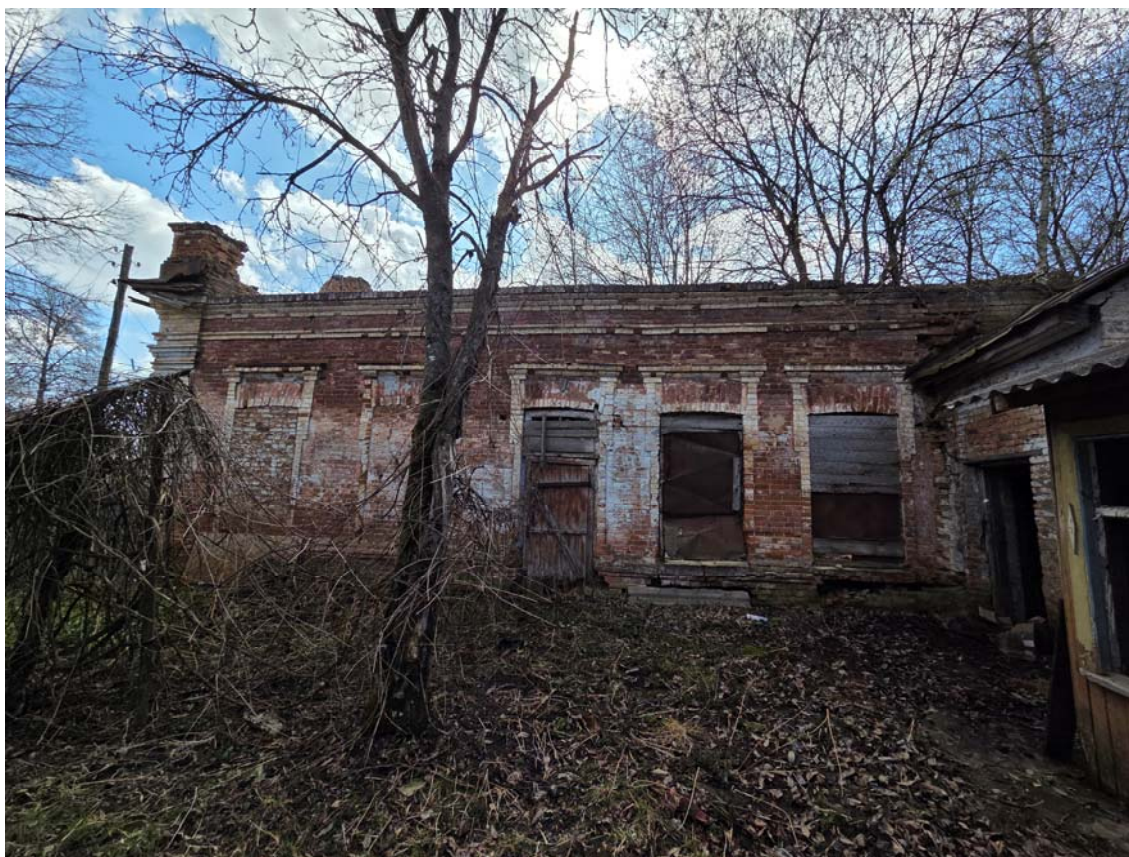
7. Вид с севера на основной корпус.
