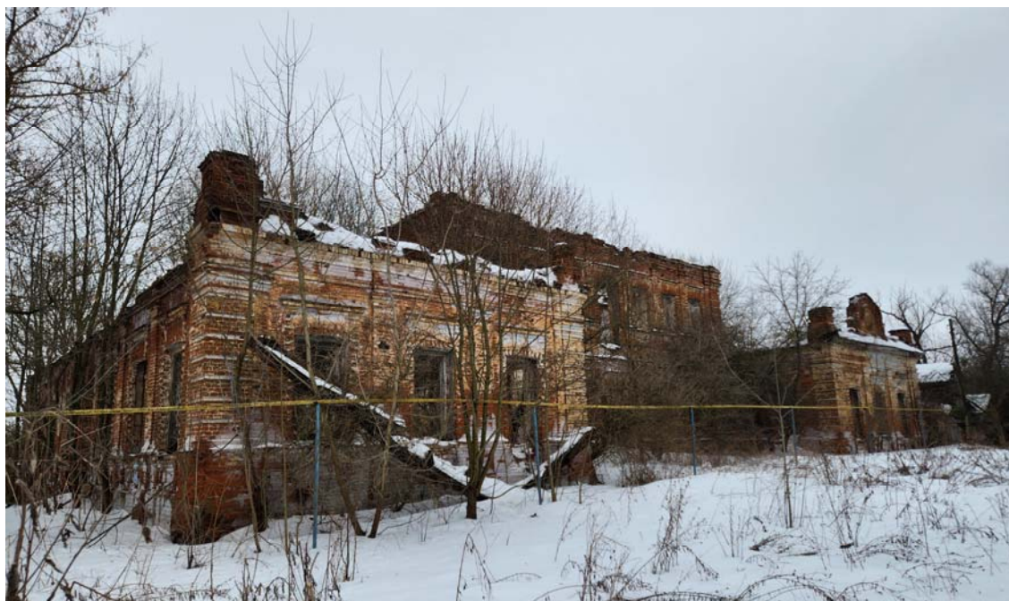
9. Главный дом. Вид с юго-востока.
