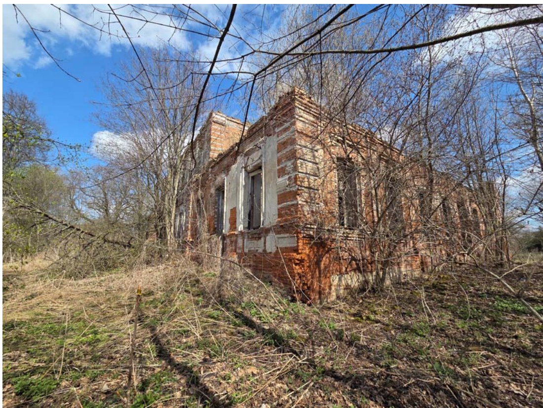
14. Главный дом. Вид с юго-запада на основной корпус.
