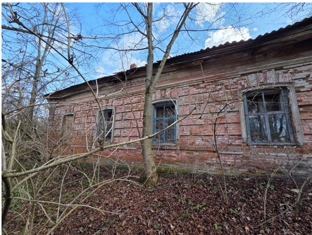
17. Вид с запада на северный корпус.
