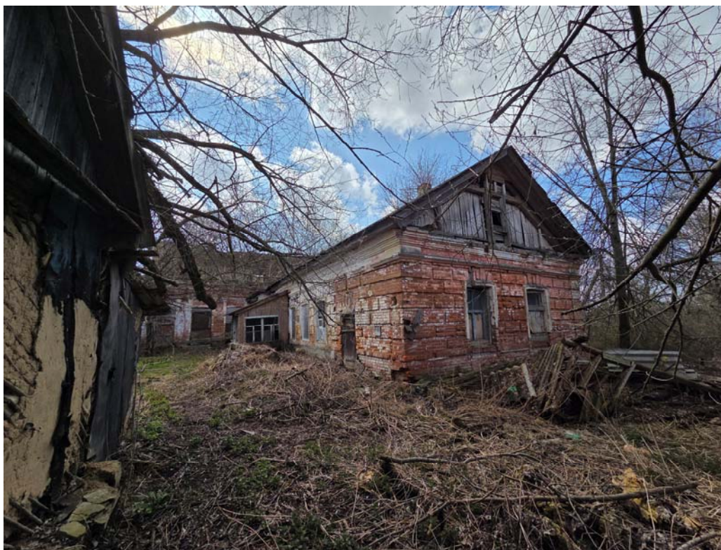
12. Вид с севера на северный корпус.
