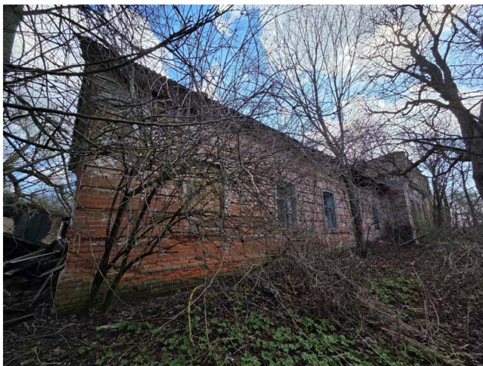
16. Вид с запада на северный корпус.
