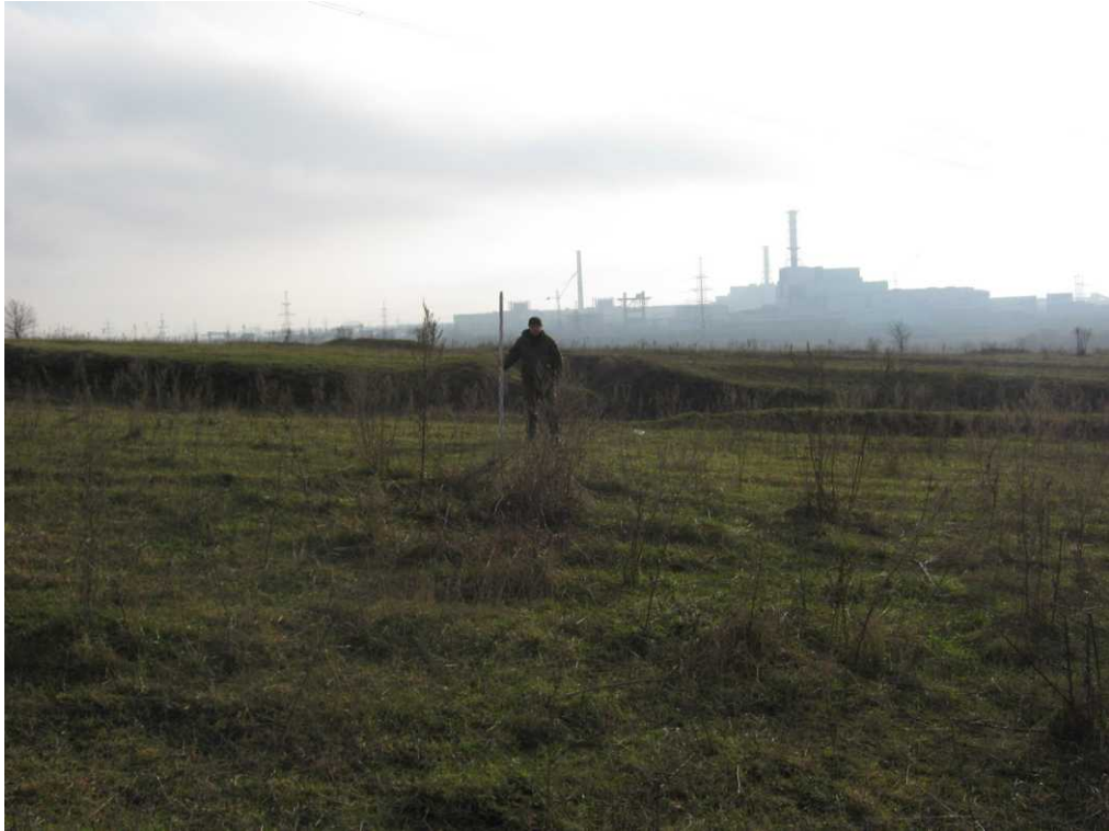
Илл. 12. КРО-2013. Общий вид участков обследования в зоне строительства КАЭС-2. Снимок №5. Участок III очереди. Вид с СЗ.
