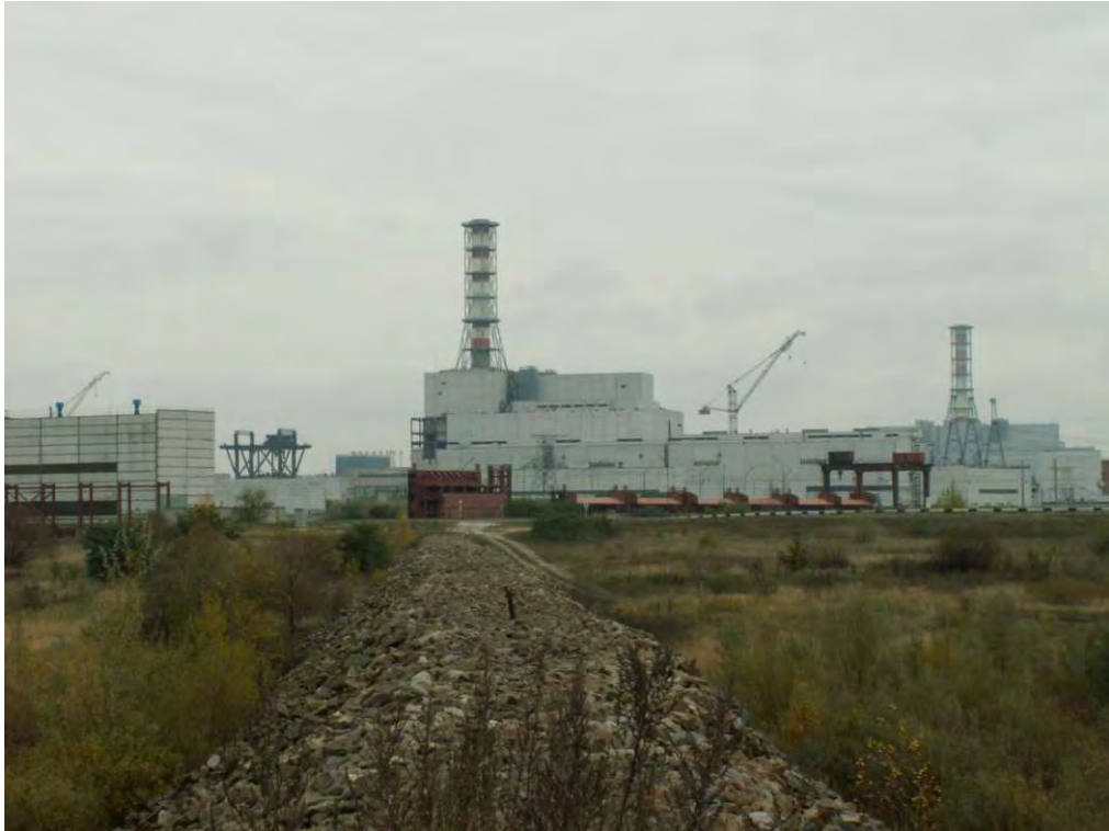
Илл. 40. КРО-2013. Общий вид участков обследования в зоне строительства КАЭС-2. Снимок №33. Участок II очереди. Вид с СЗ.
