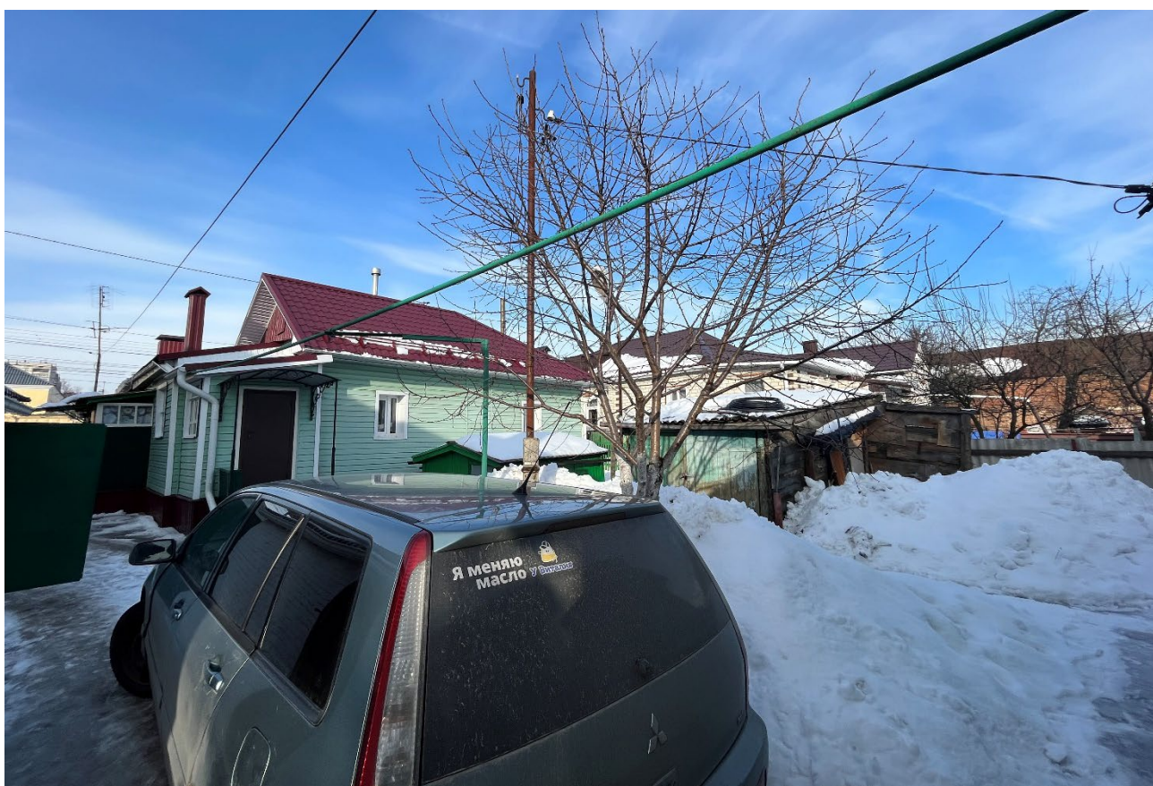
Т.ф. 8. Вид с юга на юго-восточный фасад Объекта
