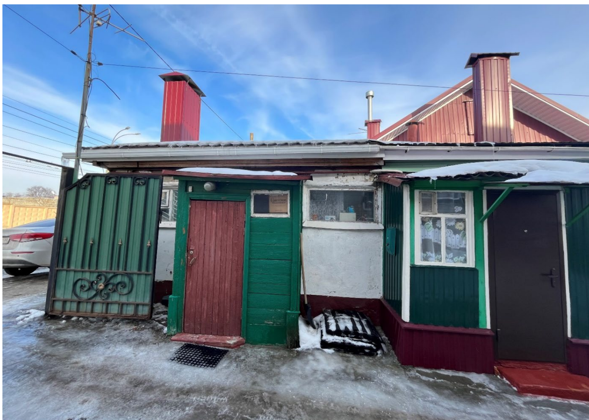
Т.ф. 12. Вид с юго-запада на пристройки к юго-западному фасаду Объекта
