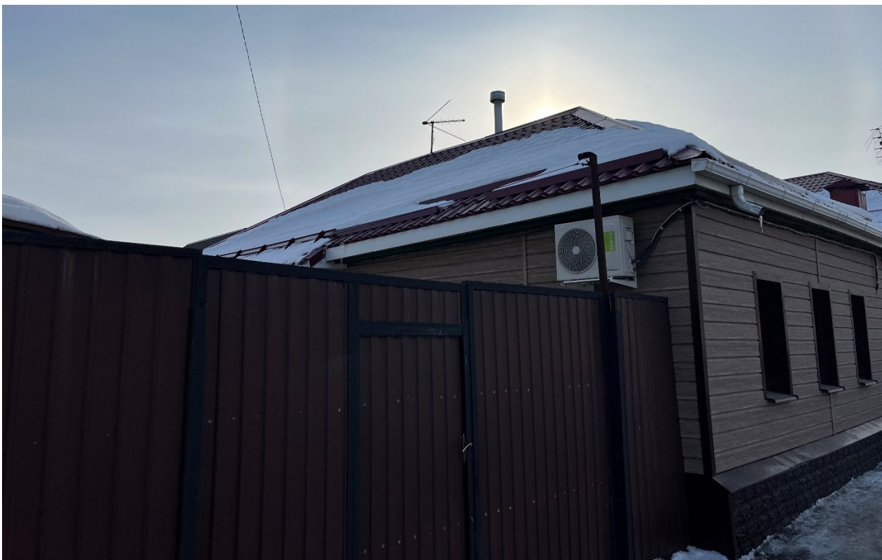
Т.ф. 16. Вид с севера со стороны ул. Красной Армии на боковой фасад Объекта
