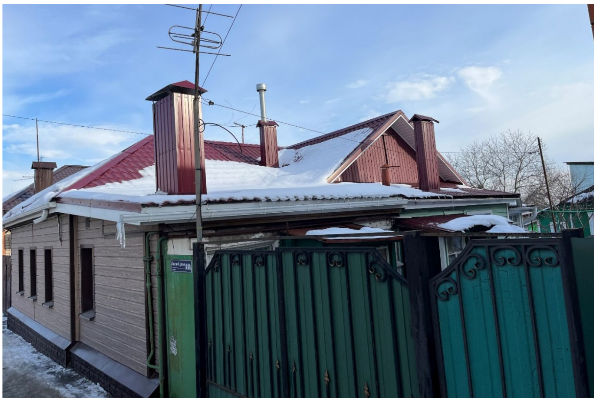
Т.ф. 13. Вид со стороны ул. Красной Армии на крышу и боковой фасад Объекта
