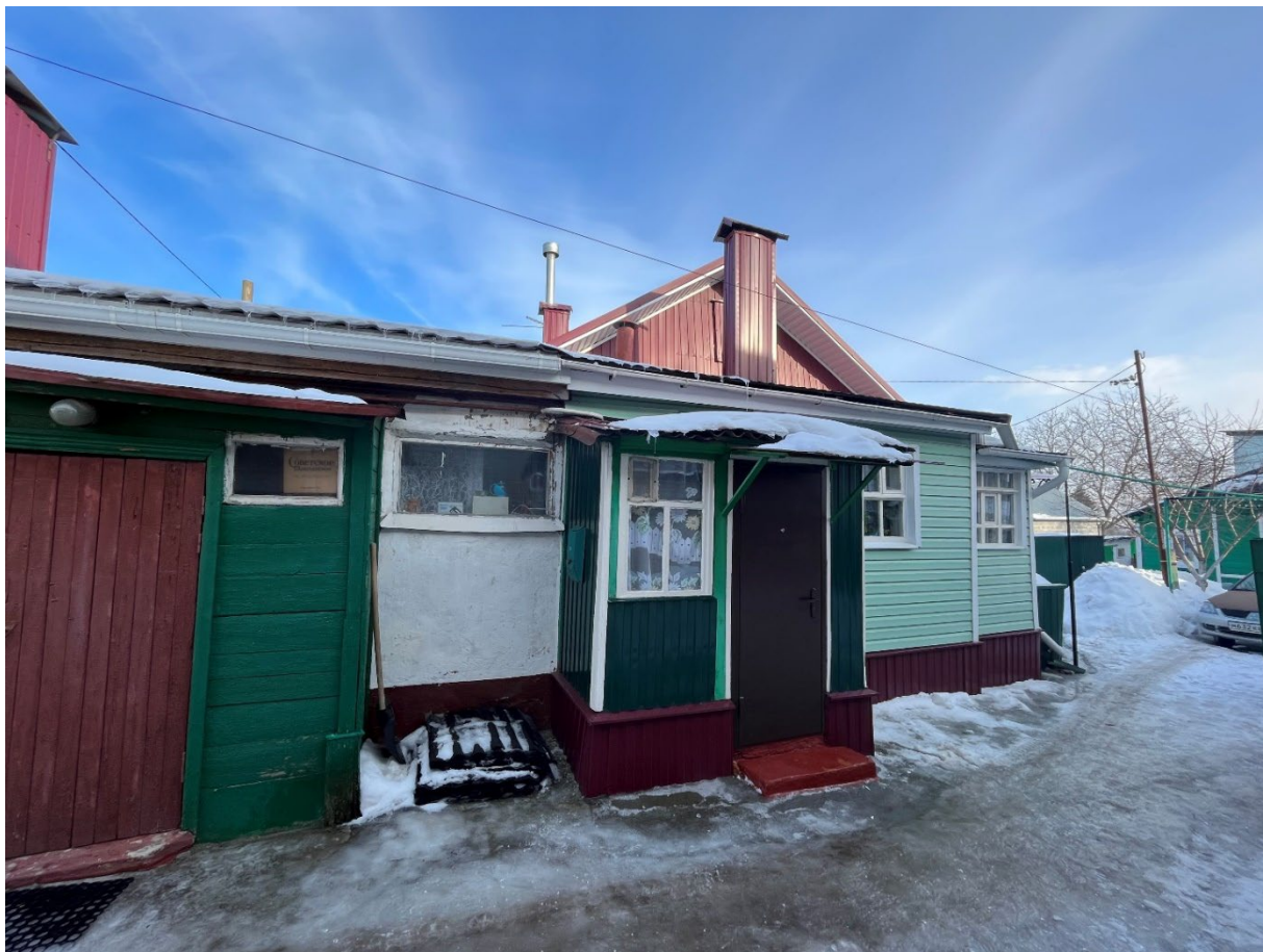
Т.ф. 11. Вид с запада на юго-западный фасад Объекта
