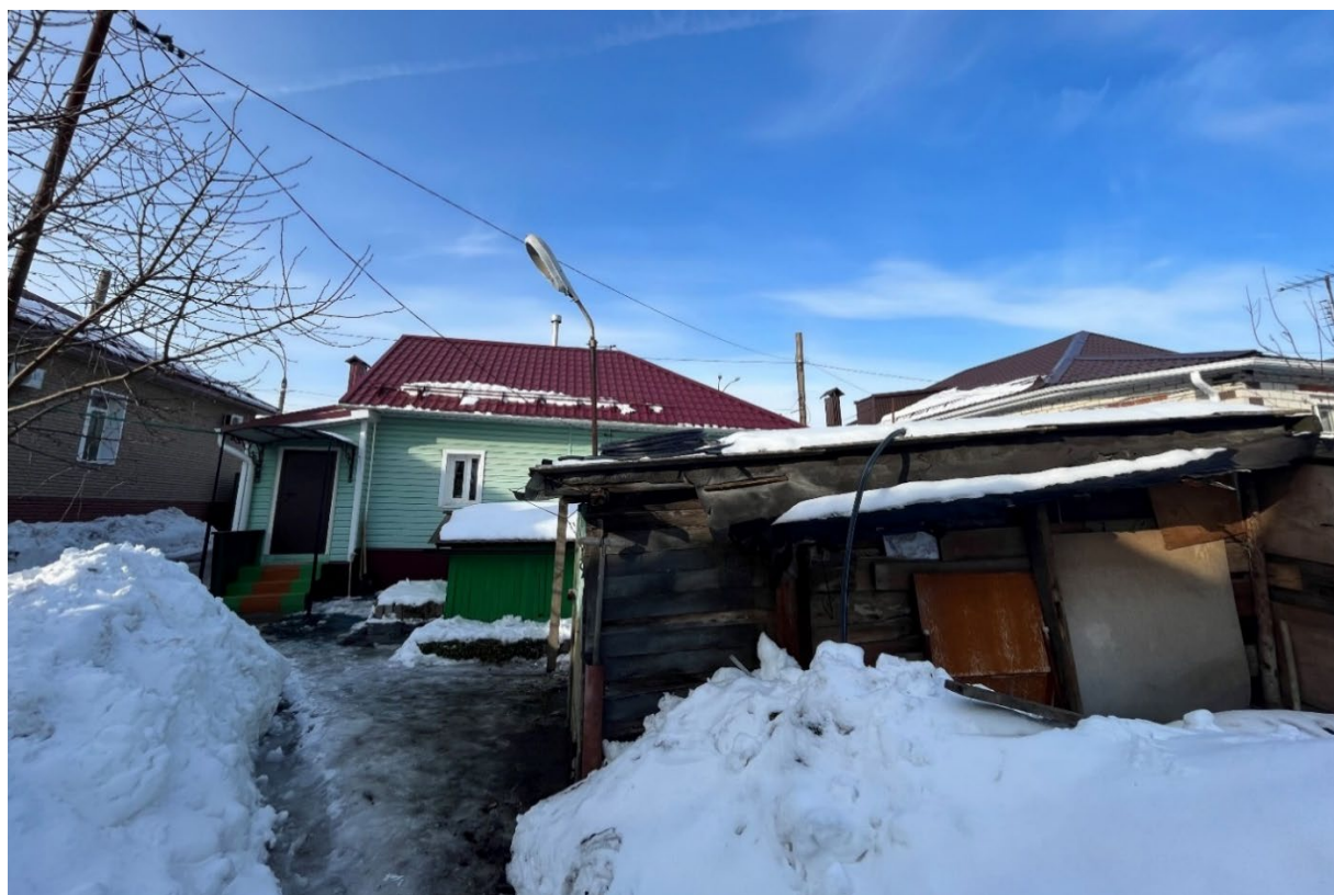
Т.ф. 6. Вид на юго-восточный дворовый фасад Объекта
