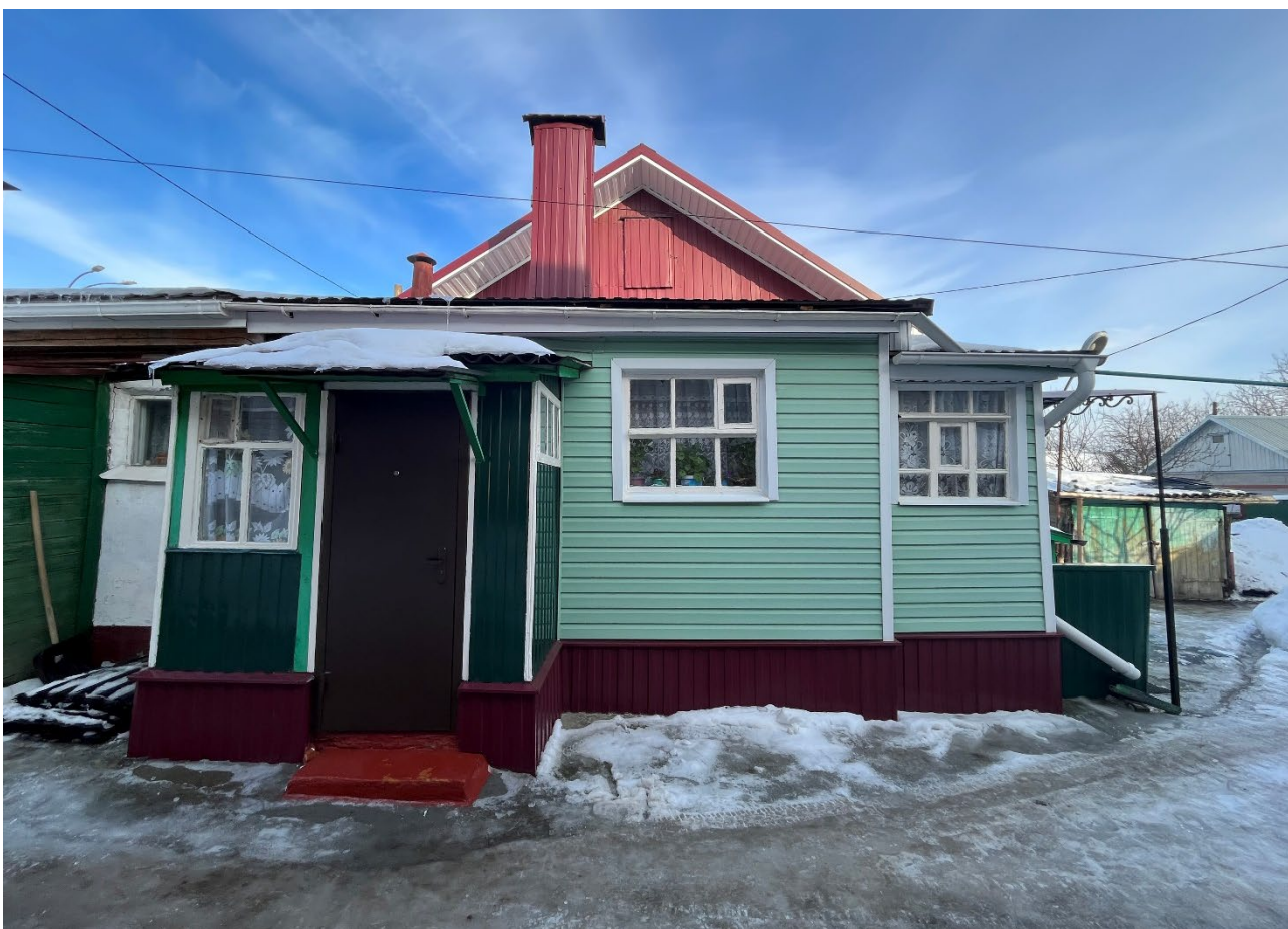
Т.ф. 10. Вид с юго-запада на пристройку к боковому фасаду Объекта
