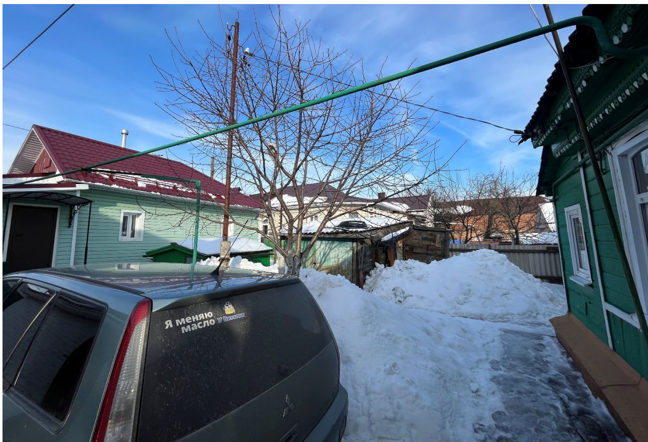
Т.ф. 7. Вид с юга на юго-восточный фасад Объекта
