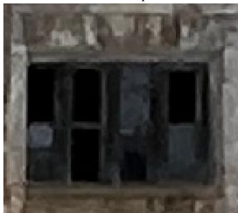
Заполнение оконных проемов боковых объемов. Западный и восточный фасады
