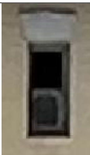
Заполнение оконных проемов боковых объемов. Западный и восточный фасад
