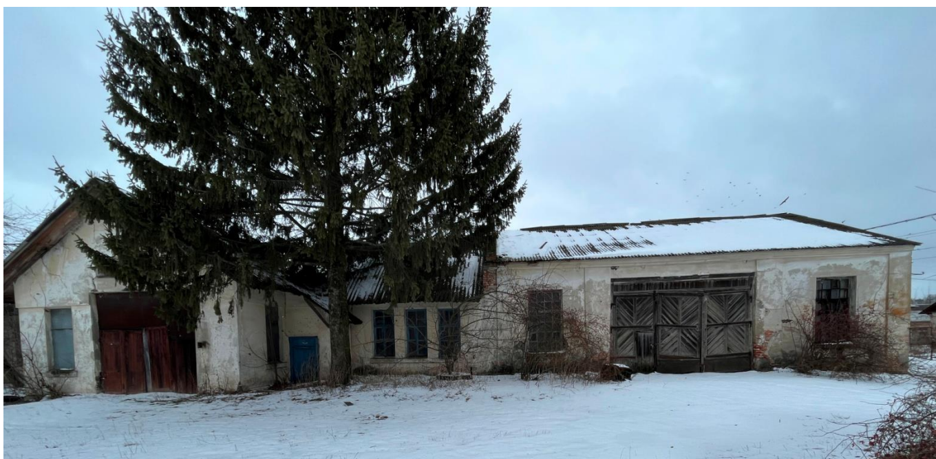
Т.ф. 16. Общий вид дворового фасада мастерских на территории опытно-селекционной станции в п. Селекционное.
