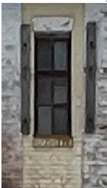
Заполнение оконных проемов центрального объема. Западный и восточный фасады
