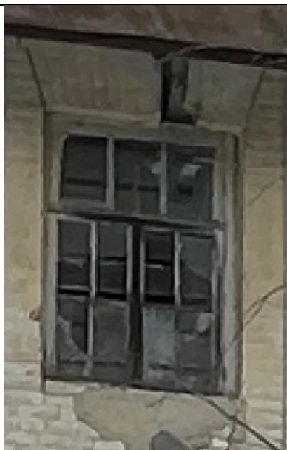
Заполнение оконных проемов боковых объемов. Северный и южный фасады
