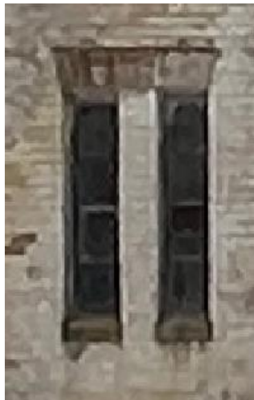
Заполнение оконных проемов боковых объемов. Все фасады
