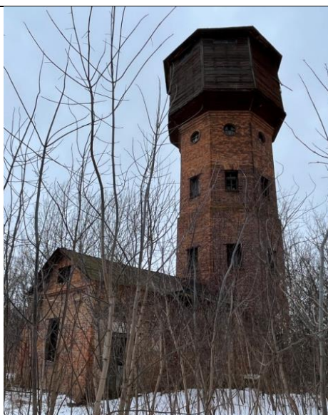
Вид на водонапорную башню
