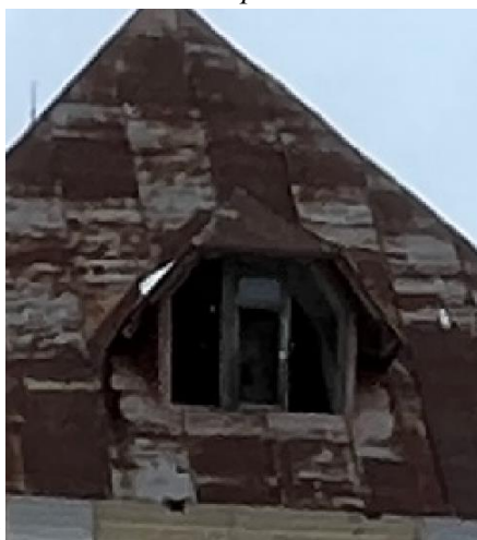
Заполнение оконных проемов слуховых окон боковых объемов. Северный и южный
