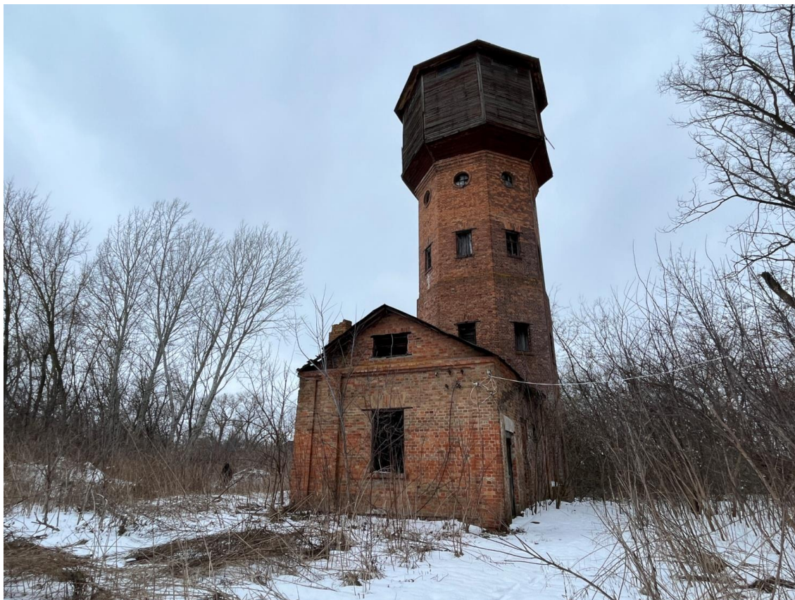
Т.ф. 22. Общий вид водонапорной башни на территории опытно-селекционной станции в п. Селекционное.
