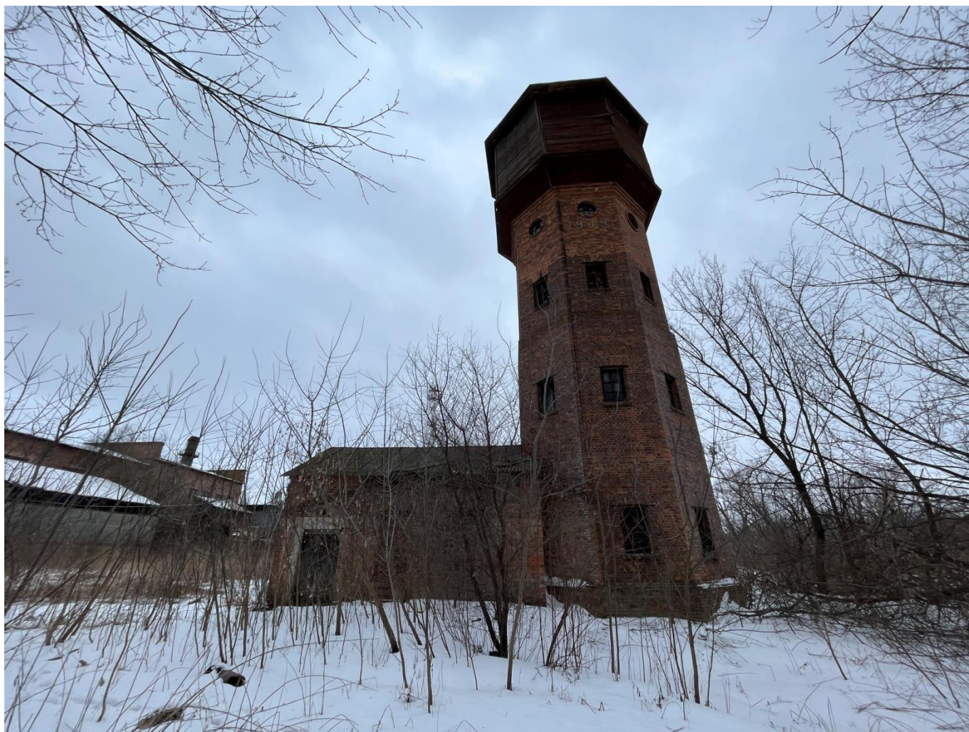
Т.ф. 24. Общий вид водонапорной башни на территории опытно-селекционной станции в п. Селекционное.
