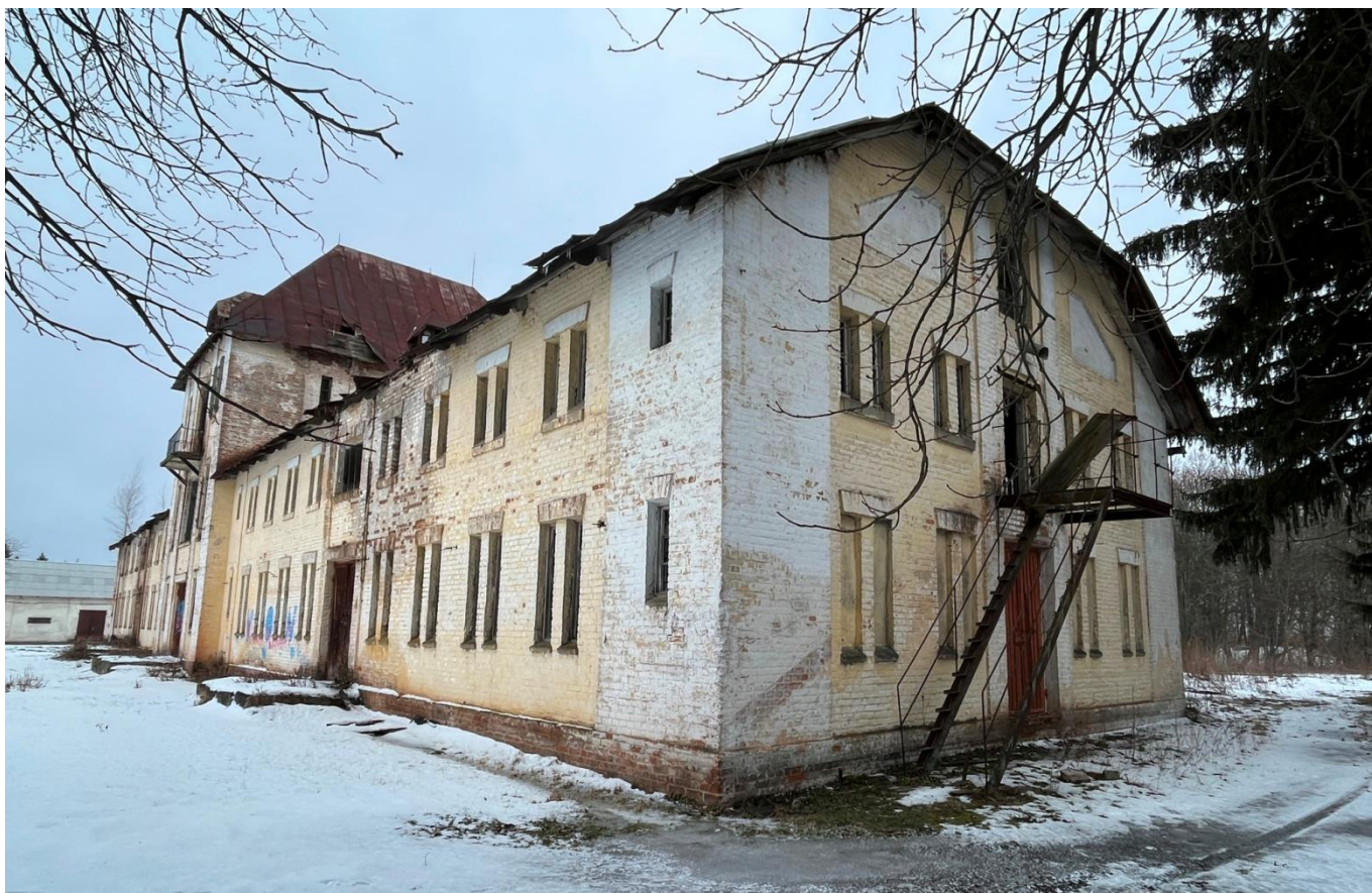
Т.ф. 7. Общий вид бокового фасада зернохранилища на территории опытно-селекционной станции в п. Селекционное.
