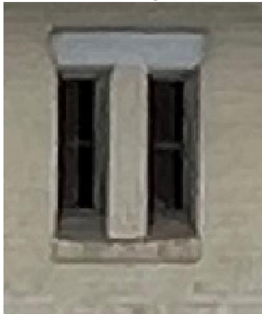
Заполнение оконных проемов боковых объемов. Все фасады
