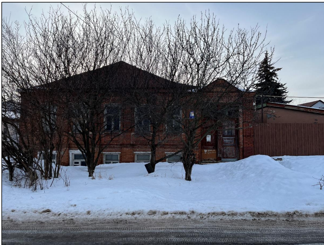
Т.ф.7. Общий вид на Объект с северо-востока
