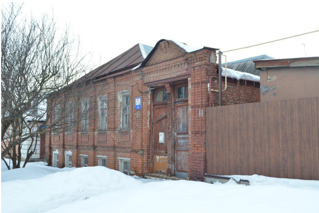
Фотография территории месторасположения Объекта – г. Курск, ул. Советская, 48 Вид с севера. Декабрь 2024 г.
