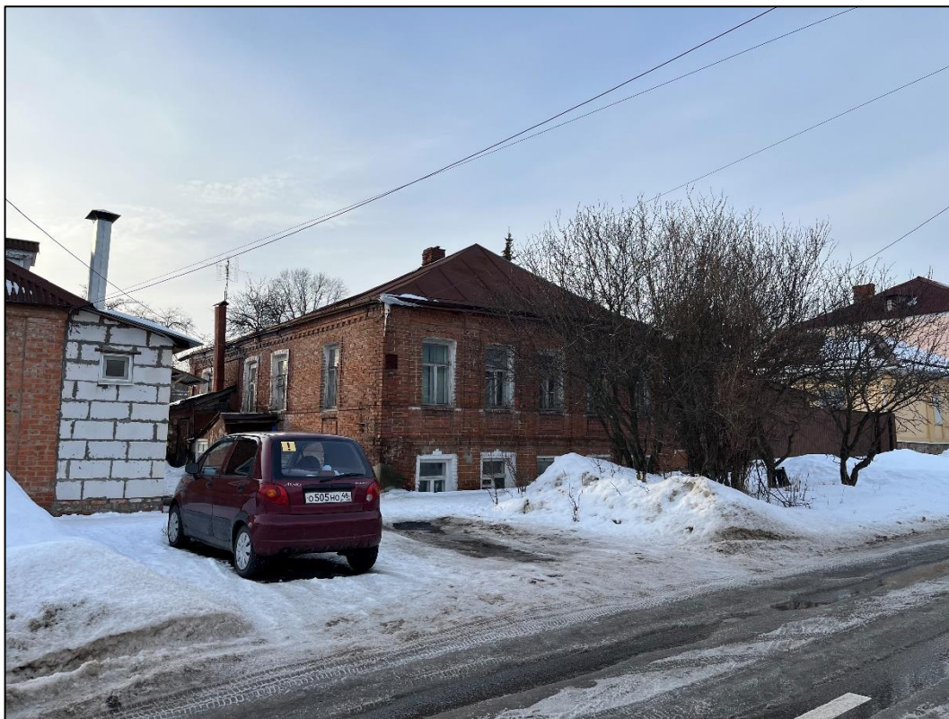
Т.ф.5. Общий вид на Объект с востока
