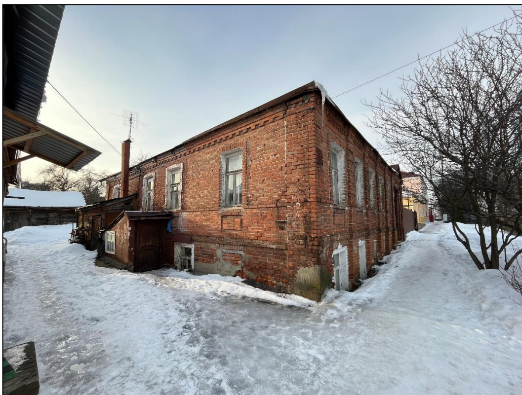
Т.ф.15. Общий вид на Объект с востока
