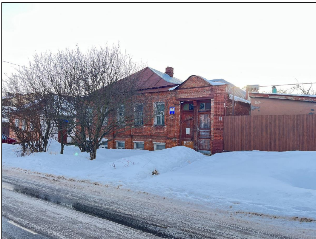
Т.ф.8. Общий вид на Объект с северо-востока
