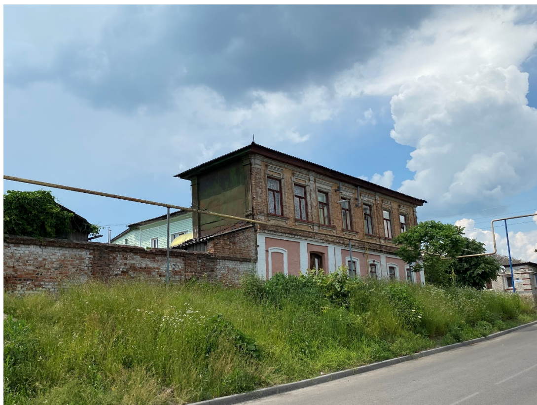
Фотография № 10. Вид с юго-востока на Объект.
