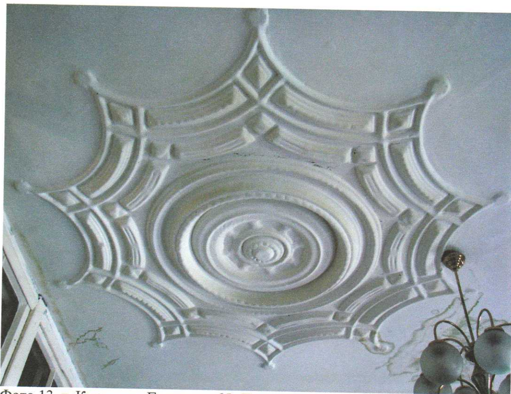
Фото 13. г. Курск, ул. Горького, 65. Лепная розетка на потолке второго этажа здания.
