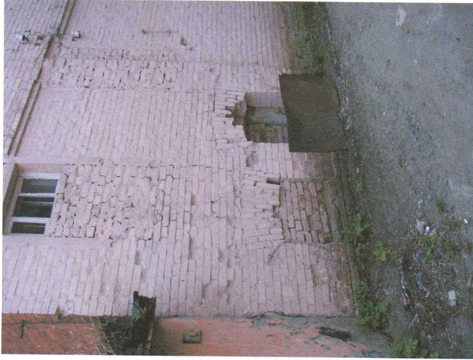
Фото 7. г. Курск, ул. Горького, 65. Северный фасад. Вид с СВ.
