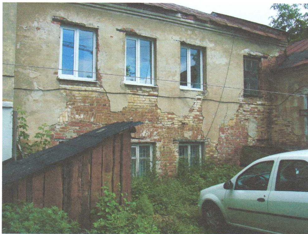
3. «Дом жилой», расположенный на земельном участке № 65 по ул. Горького, в г. Курске (строение А4) Фрагмент дворового фасада. Фотофиксация июнь 2012г.
