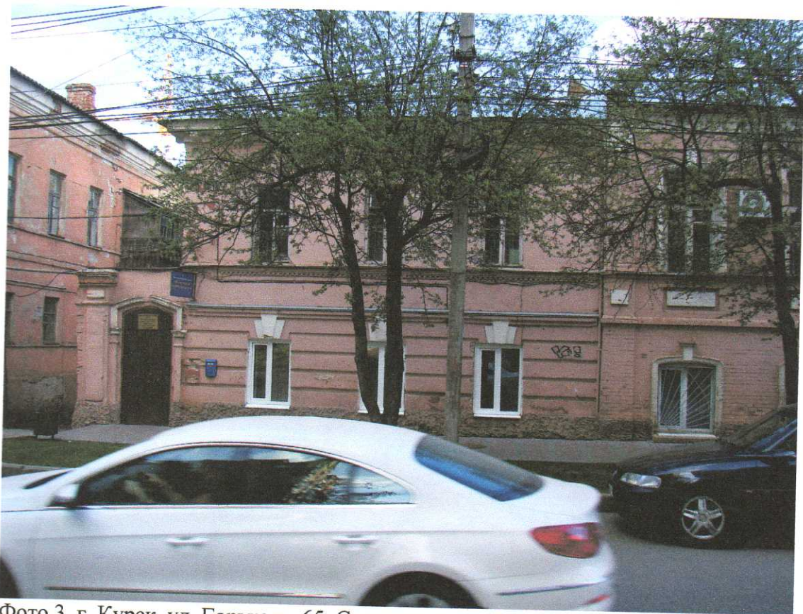
Фото 3. г. Курск, ул. Горького, 65. Северная часть западного фасада. Вид с З.
