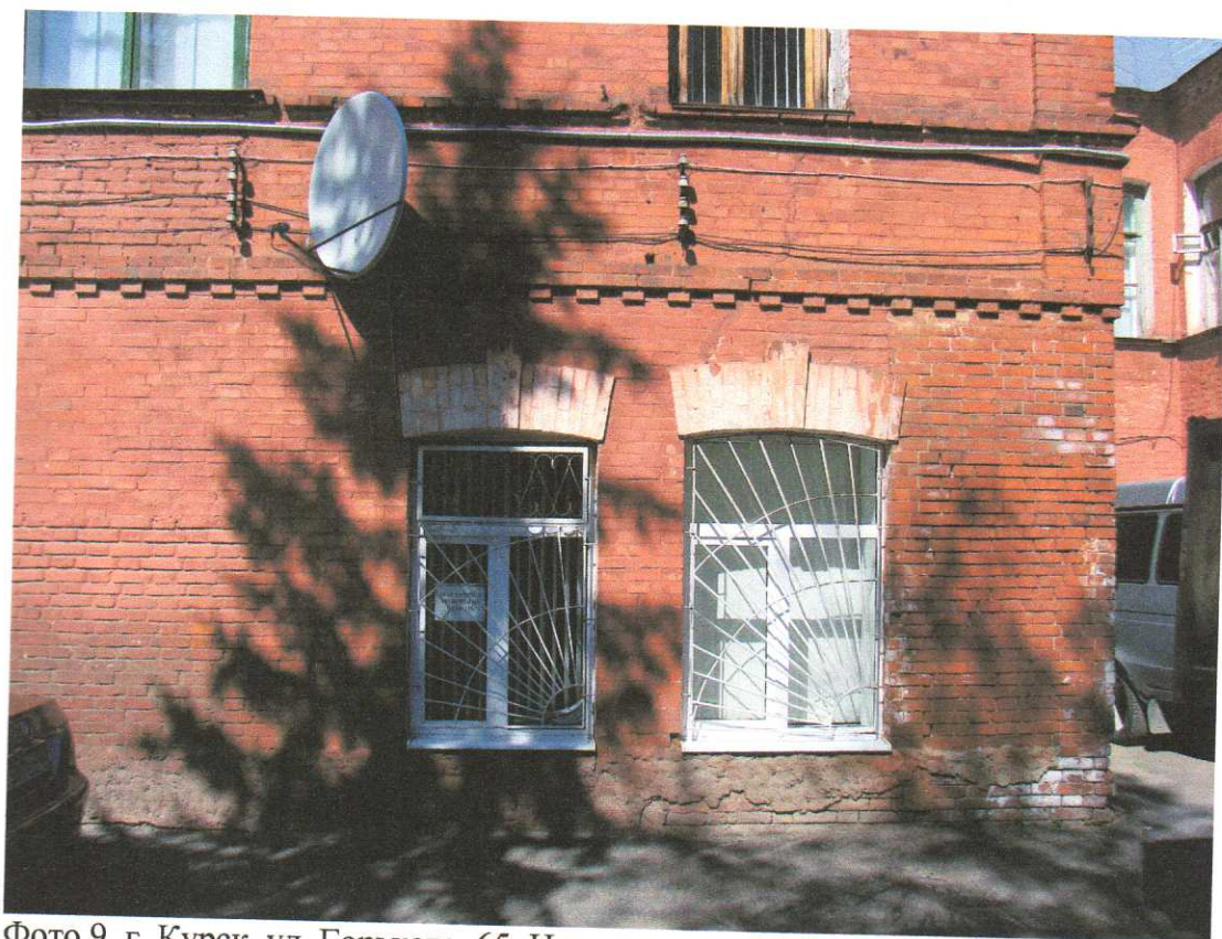
Фото 8. г. Курск, ул. Горького, 65. Верхняя часть восточного фасада южной части здания. Вид с В.
