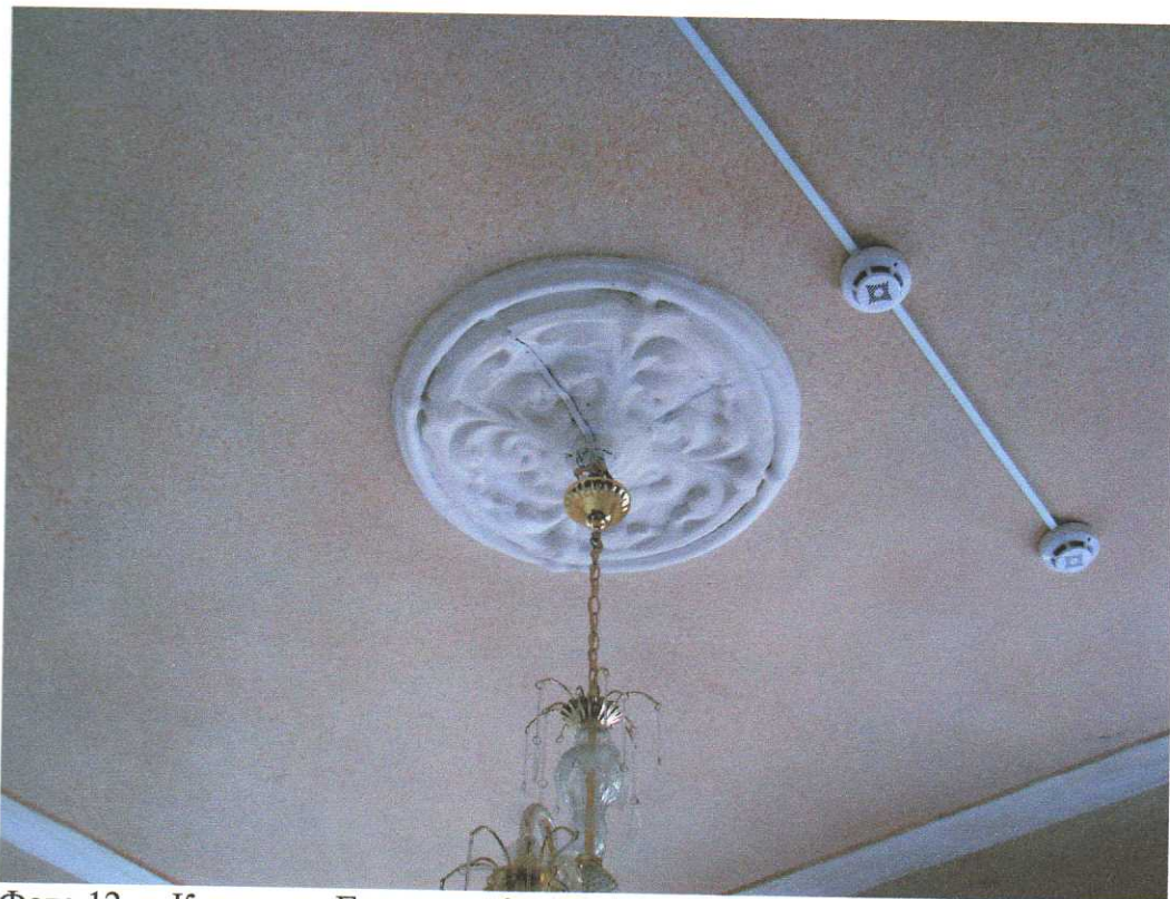
Фото 12. г. Курск, ул. Горького, 65. Лепная розетка на потолке второго этажа здания.
