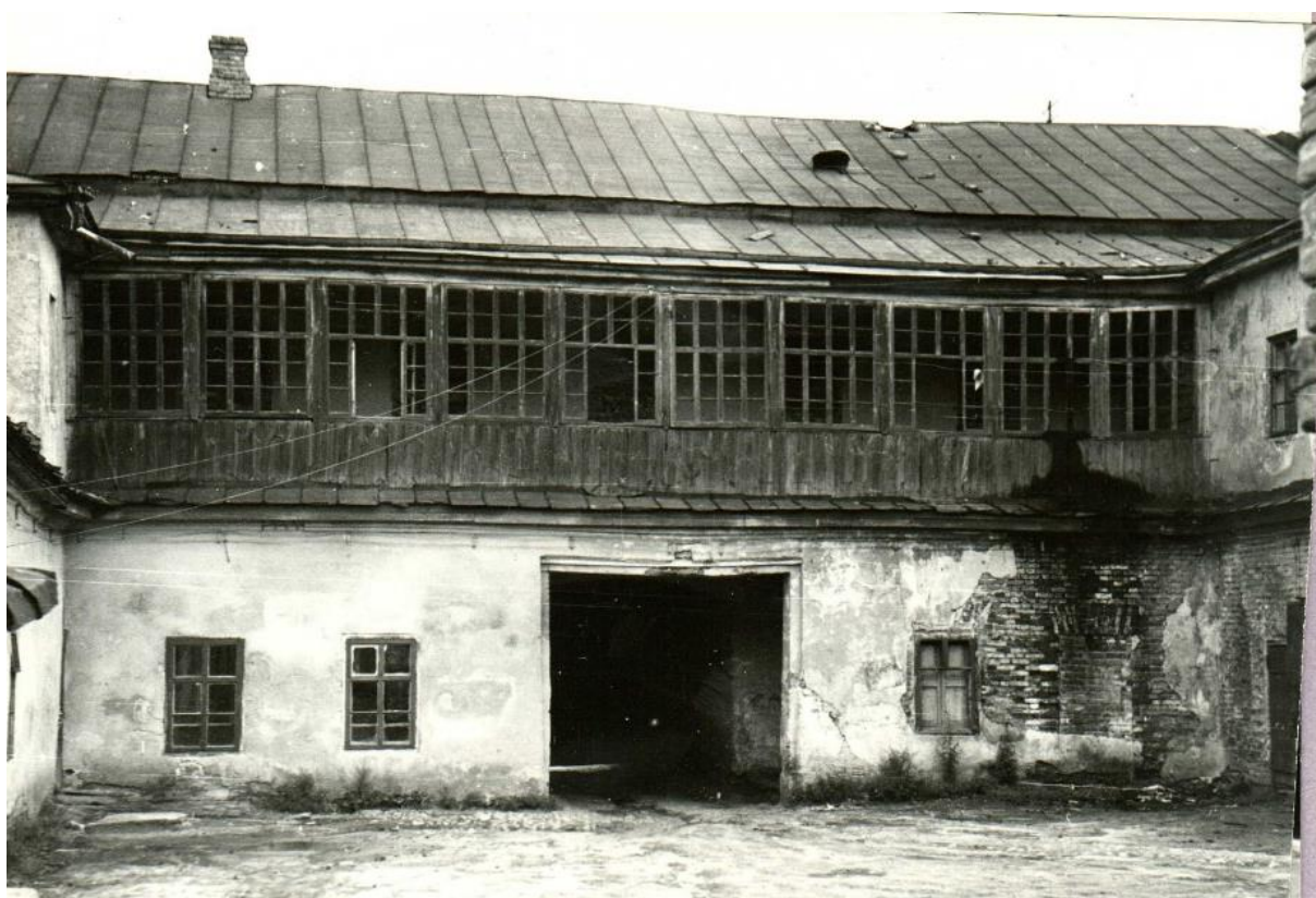
19. Здание Объекта вид со двора. Советская пл., 4-6. 1972 г.
