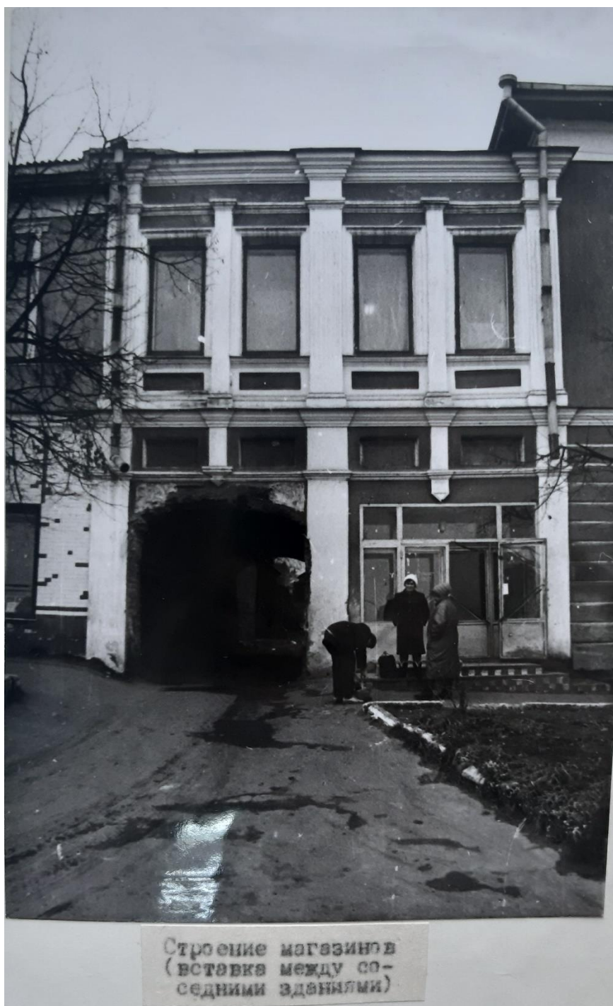
Строение магазинов (вставка между соседними зданиями), ул. Советская площадь (по правой стороне), конец XIX – начало XX в. Здание Объекта на фотографии в «Проекте охранных зон г. Рьльска Курской обл.» 1990 года.
