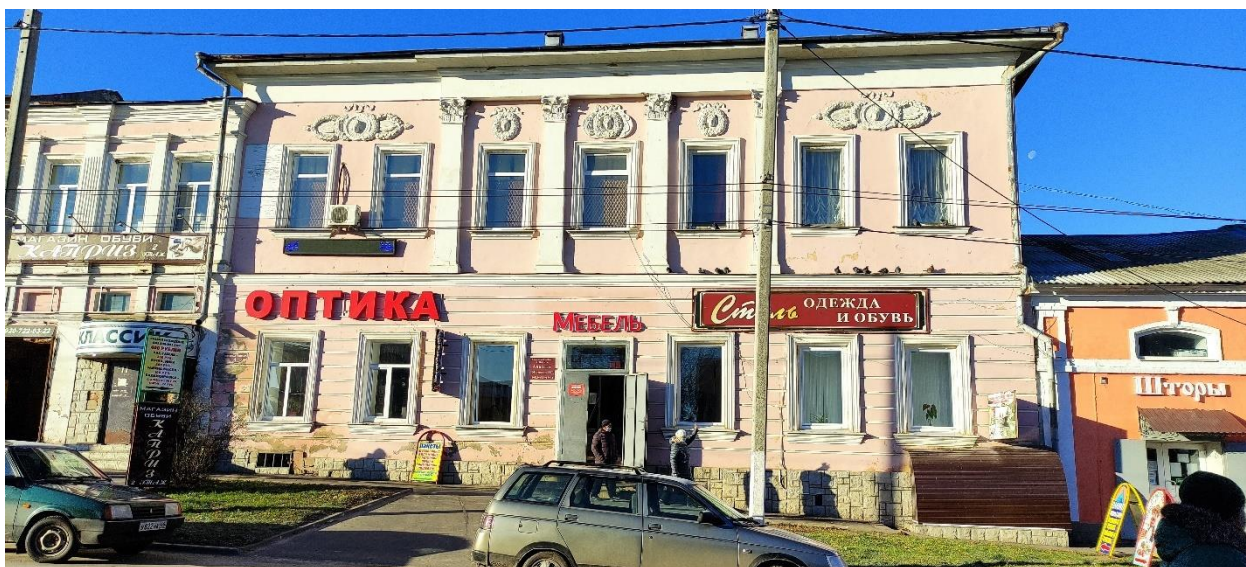
Фотография №2. Вид с запада на Объект.
