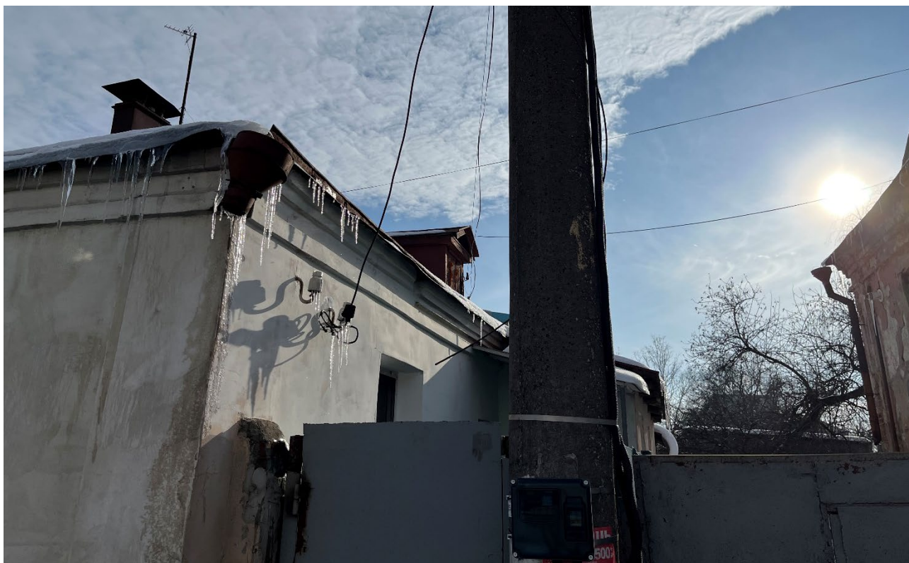
Т.ф. 5. Вид с севера на боковой фасад Объекта
