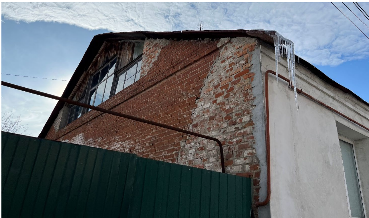
Т.ф. 3. Вид с севера со стороны ул. Красной Армии на боковой фасад Объекта
