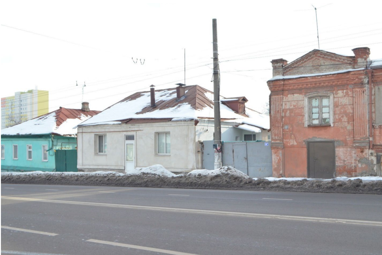
Т.ф. 8. Общий вид с северо-запада на главный фасад Объекта
