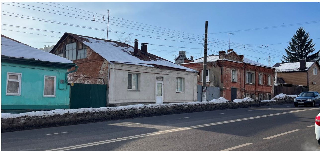
Т.ф. 1. Вид с севера со стороны ул. Красной Армии на главный фасад Объекта в контексте градостроительной среды
