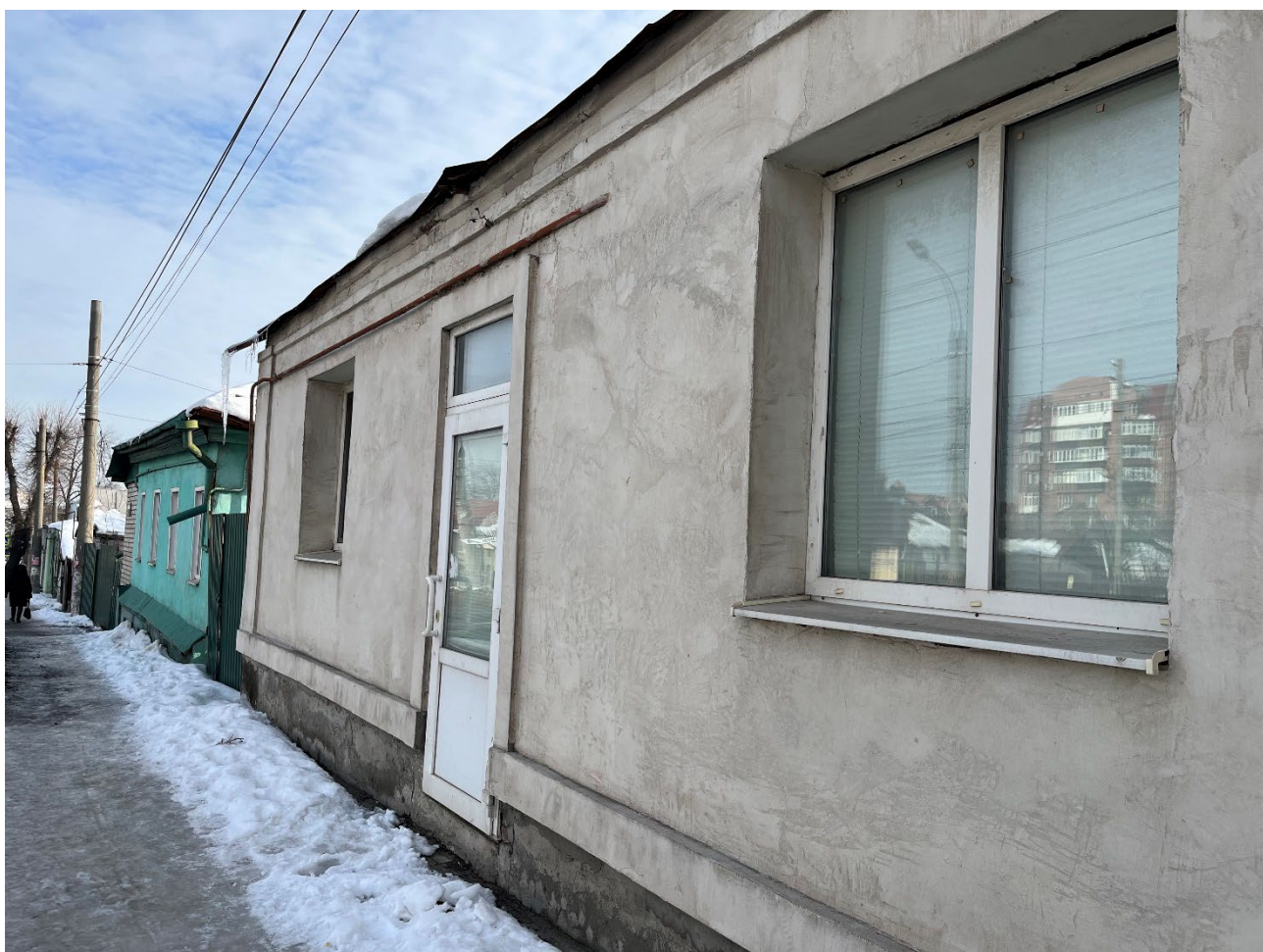
Т.ф. 4. Вид с запада со стороны ул. Красной Армии на главный фасад Объекта
