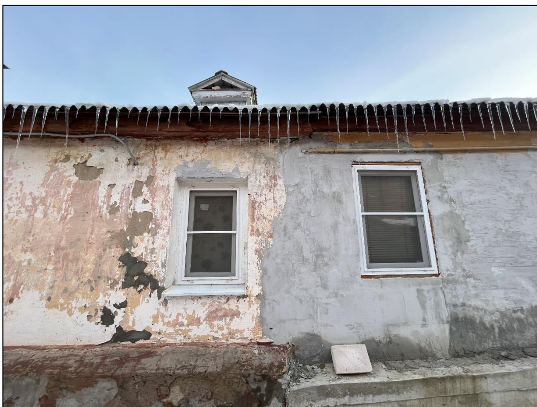
Т.ф.8. Вид на фрагмент Обьекта с северо-запада
