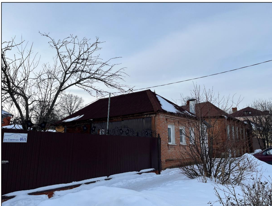
Т.ф.11. Общий вид на Объект с востока
