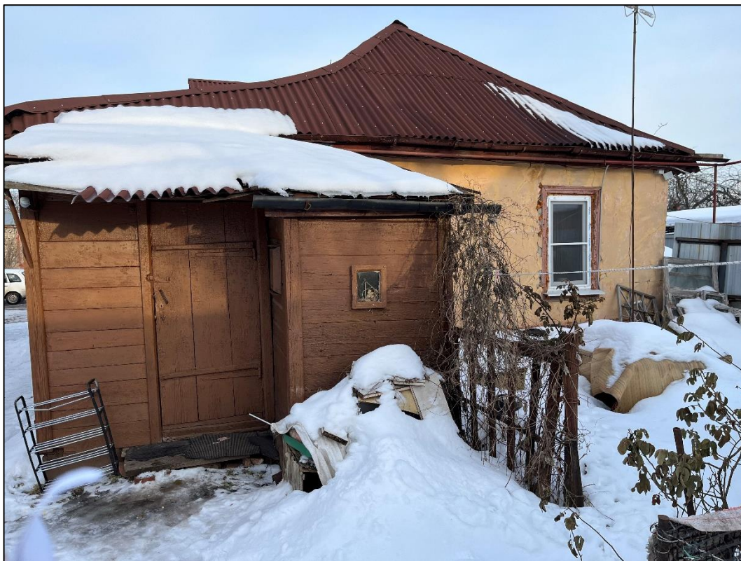
Т.ф.15. Общий вид на Объект с юго-запада
