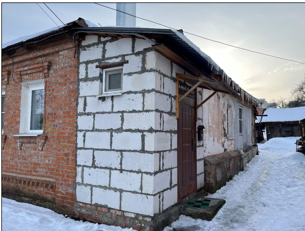
Т.ф.5. Общий вид на Объект с северо-востока
