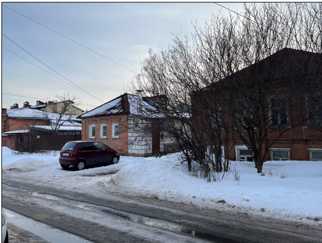
Т.ф.3. Общий вид на Объект с северо-востока
