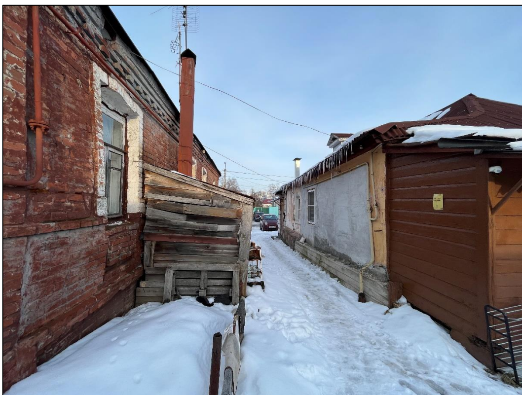
Т.ф.14. Вид на прилегающую территорию Объекта
