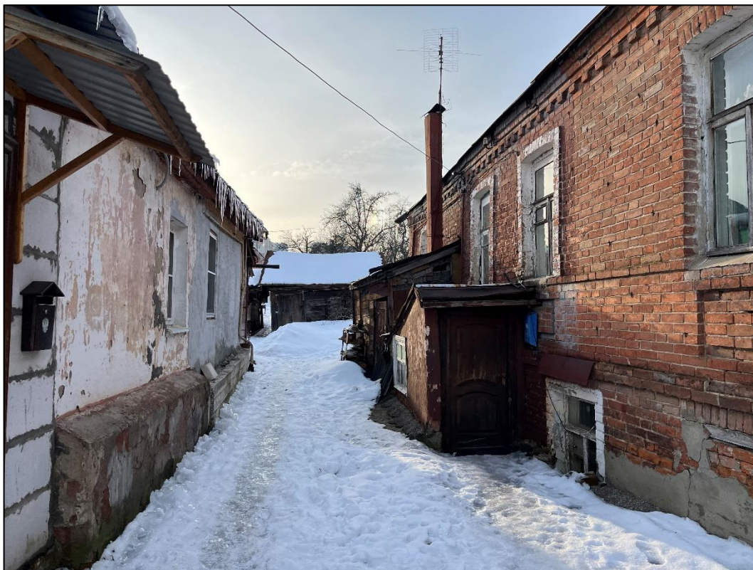
Т.ф.9. Вид на прилегающую территорию Объекта
