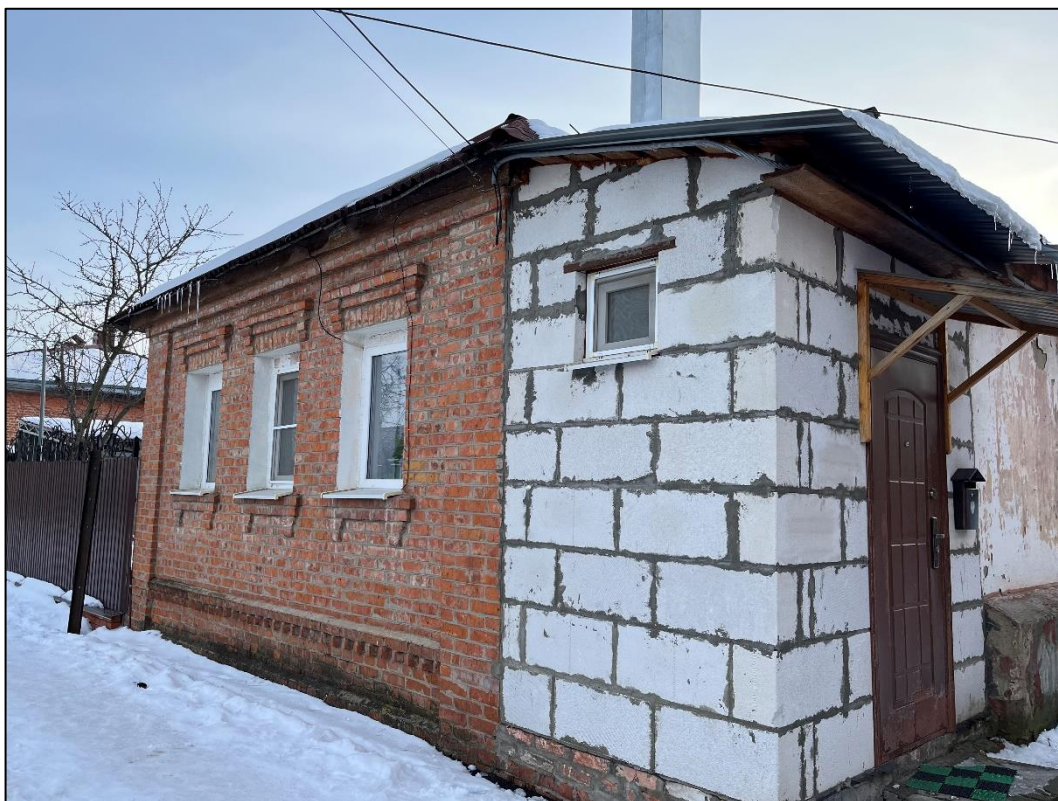
Т.ф.4. Общий вид на Объект с северо-востока
