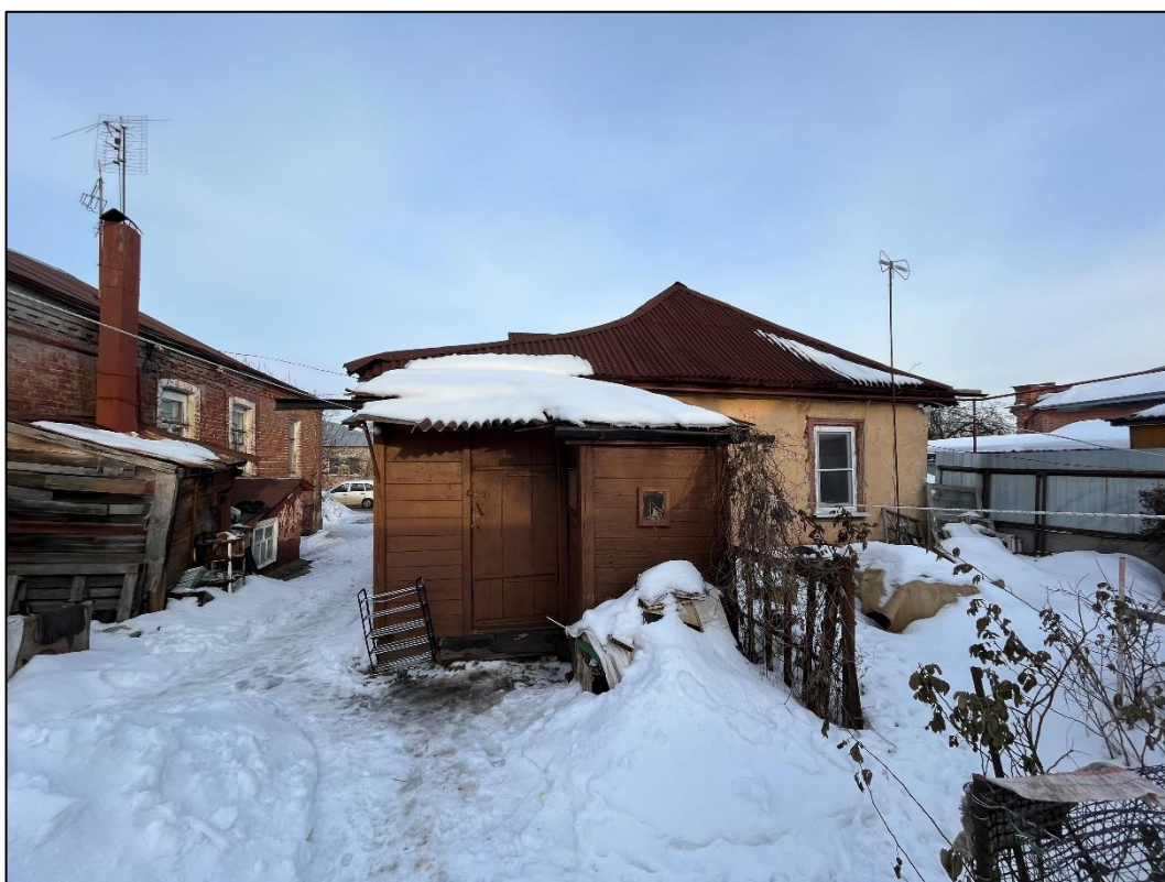
Т.ф.16. Общий вид на Объект с юго-запада
