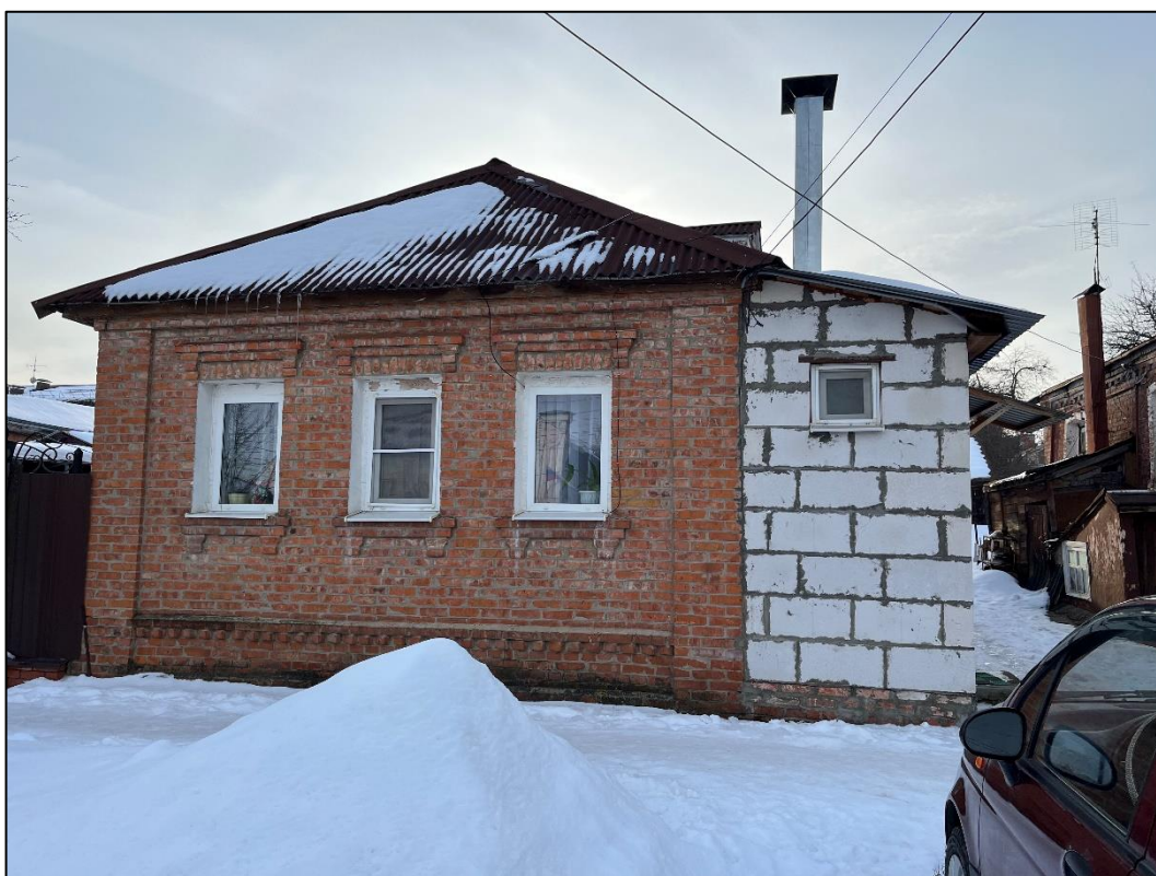
Т.ф.6. Общий вид на Объект с северо-востока
