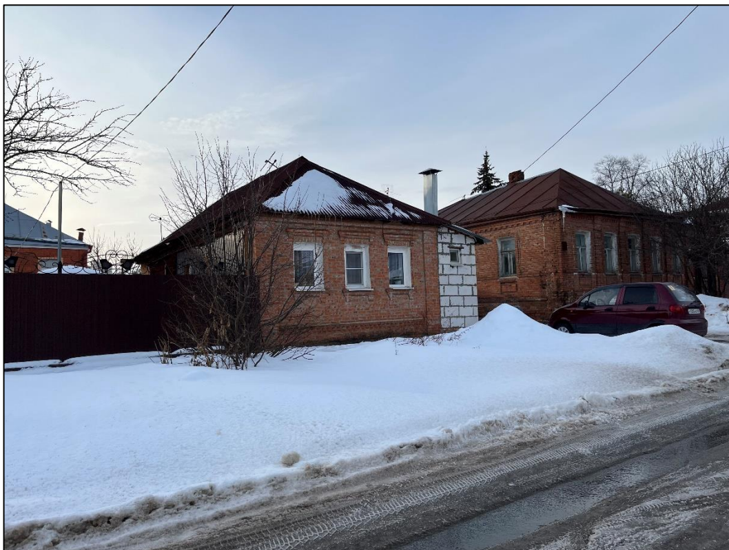
Т.ф.2. Общий вид на Объект с востока
