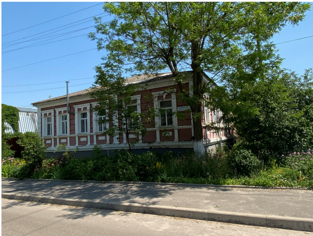
Фотография № 5. Вид с юго-запада на Объект.
