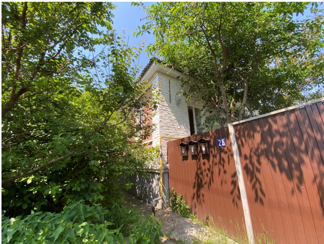
Фотография № 1. Вид с востока на Объект.
