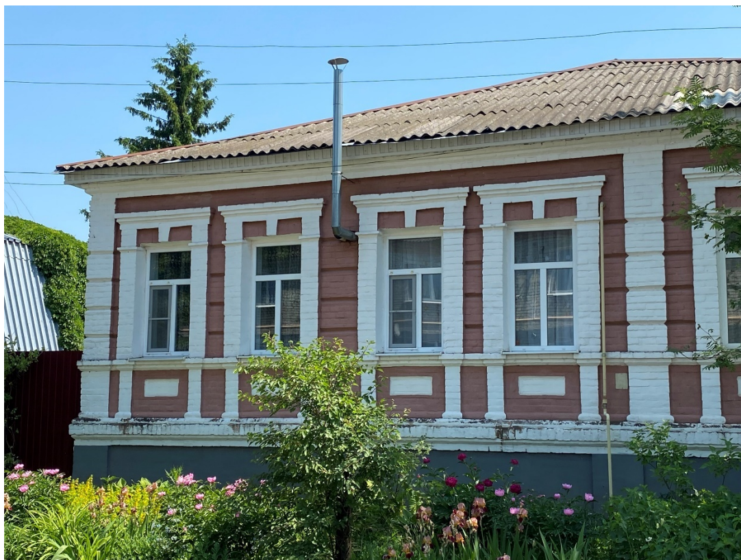
Фотография № 11. Вид с юго-запада на Объект.
