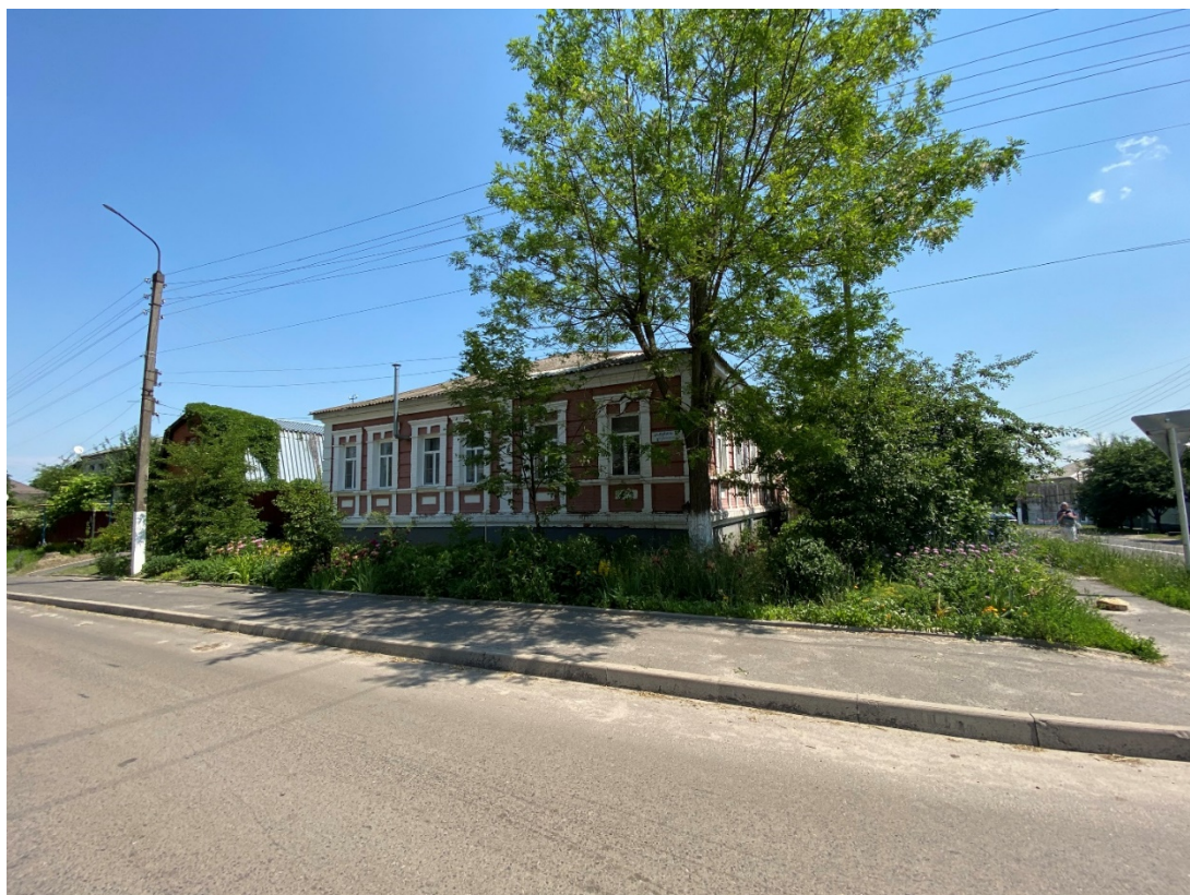
Фотография № 6. Вид с юго-запада на Объект.
