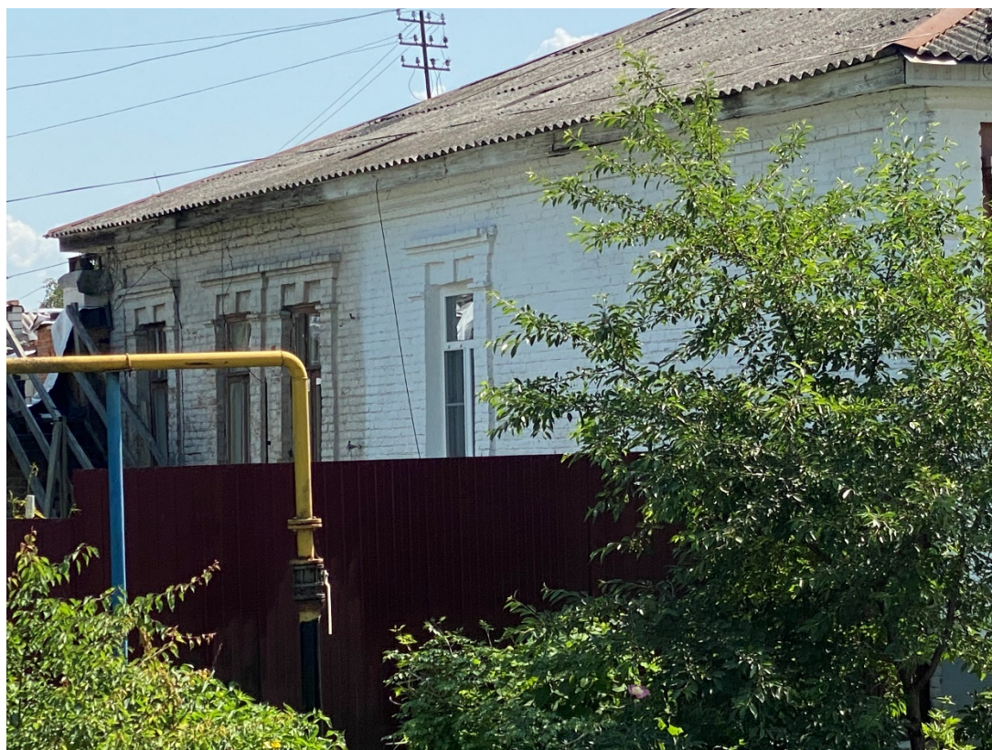
Фотография № 12. Вид с юго-запада на Объект.
