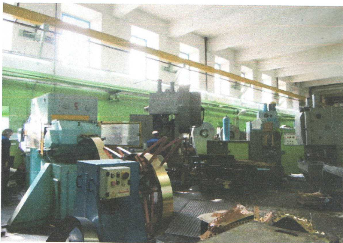
11. «Здание мужской классической гимназии, 1836-1842 гг.», Курская область, г. Курск, ул. Луначарского, 8, литер В, Вб. Интерьер. Состояние стен. Сентябрь 2015 г.
