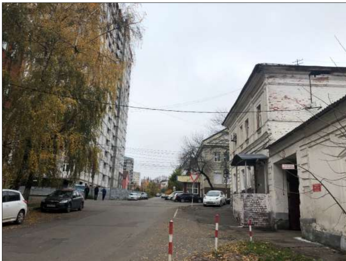
Вид с востока вдоль улицы Софьи Перовской на Объект. Южный фасад
