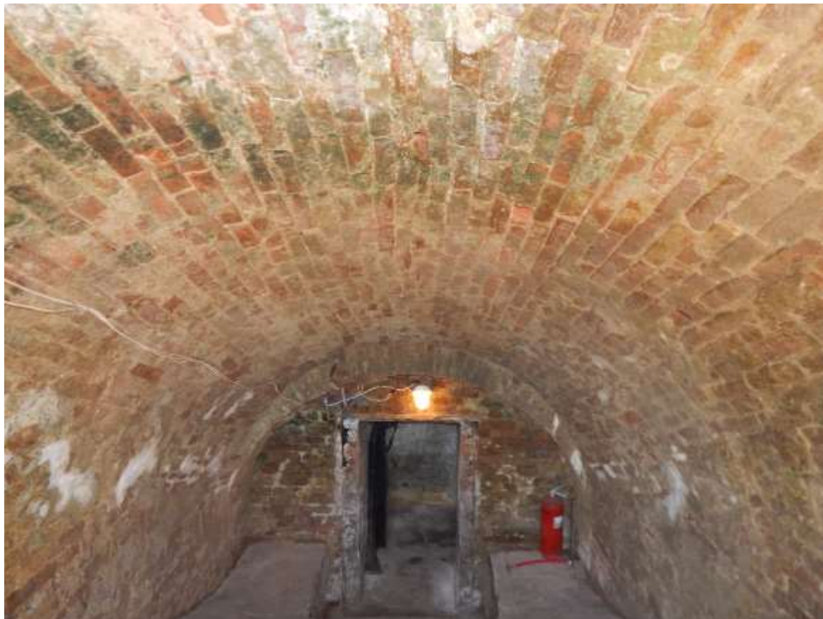
Вход в подвал. Май 2020 г.
