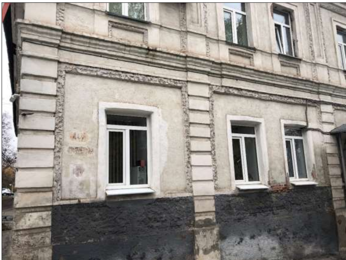
Вид с юго-запада по улице Гайдара на Объект. Южный фасад. Фрагмент
