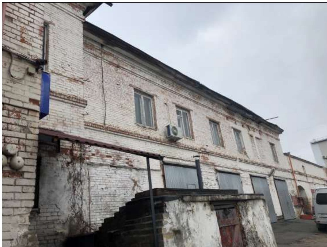
Вид с востока на Объект с дворовой территории. Фрагмент восточного фасада
