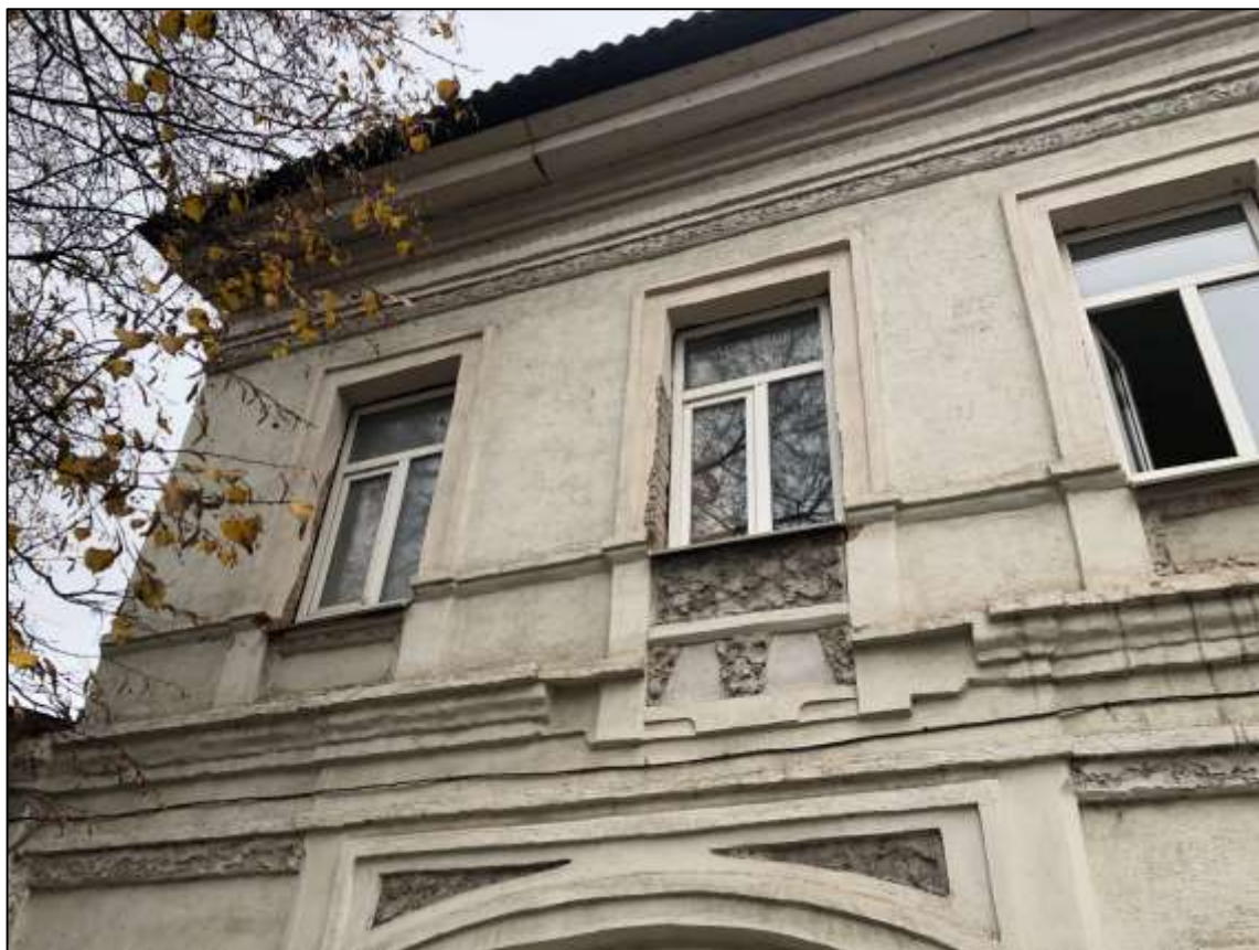
Вид с запада на Объект. Фрагмент западного фасада
