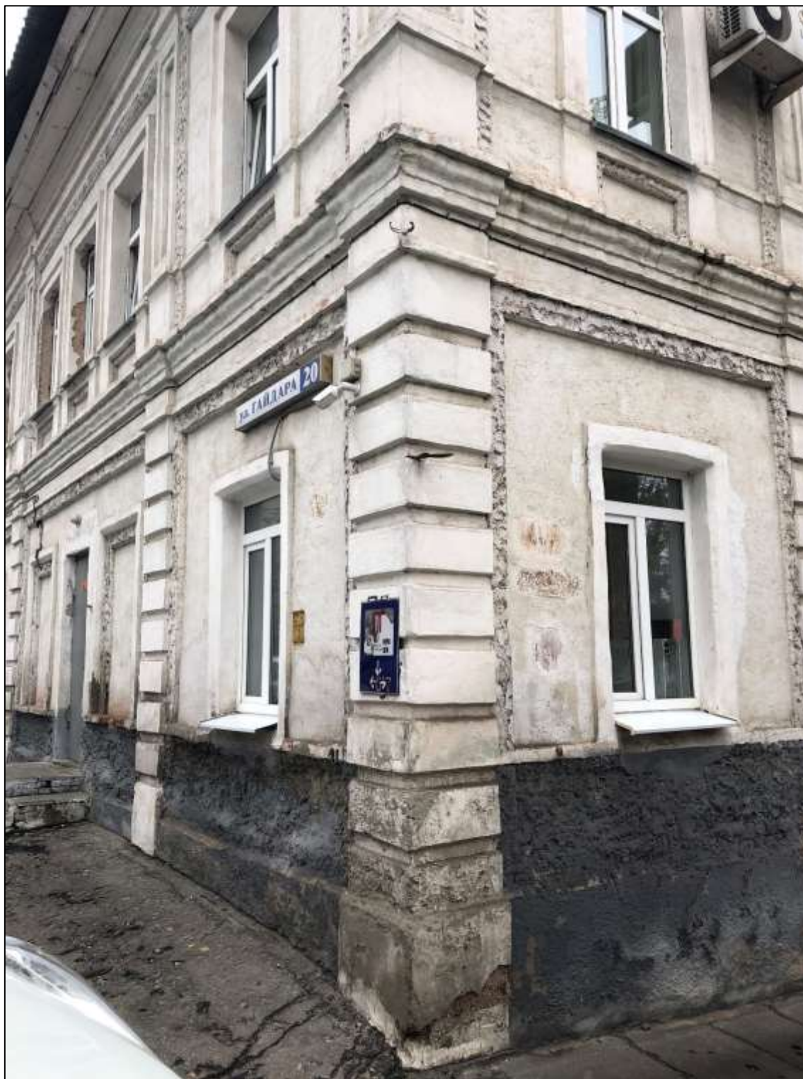
Вид с юго-запада по улице Гайдара на Объект. Западный и южный фасады
