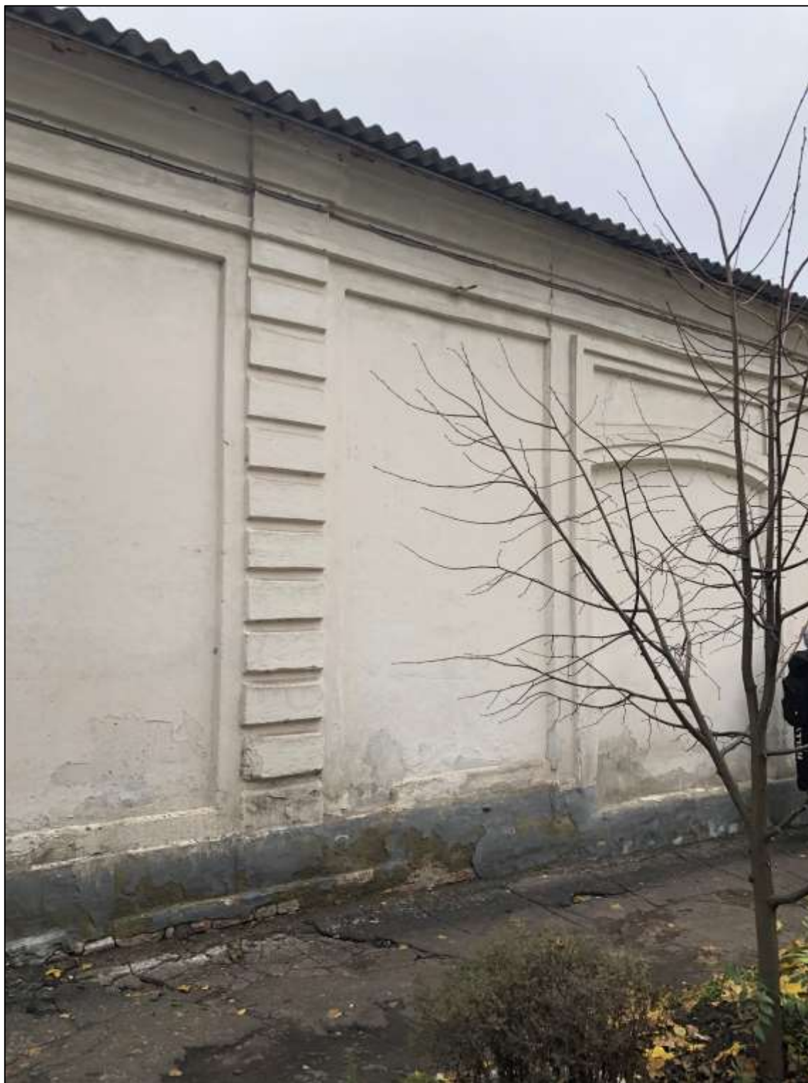
Вид с востока по улице Софьи Перовской на Объект
