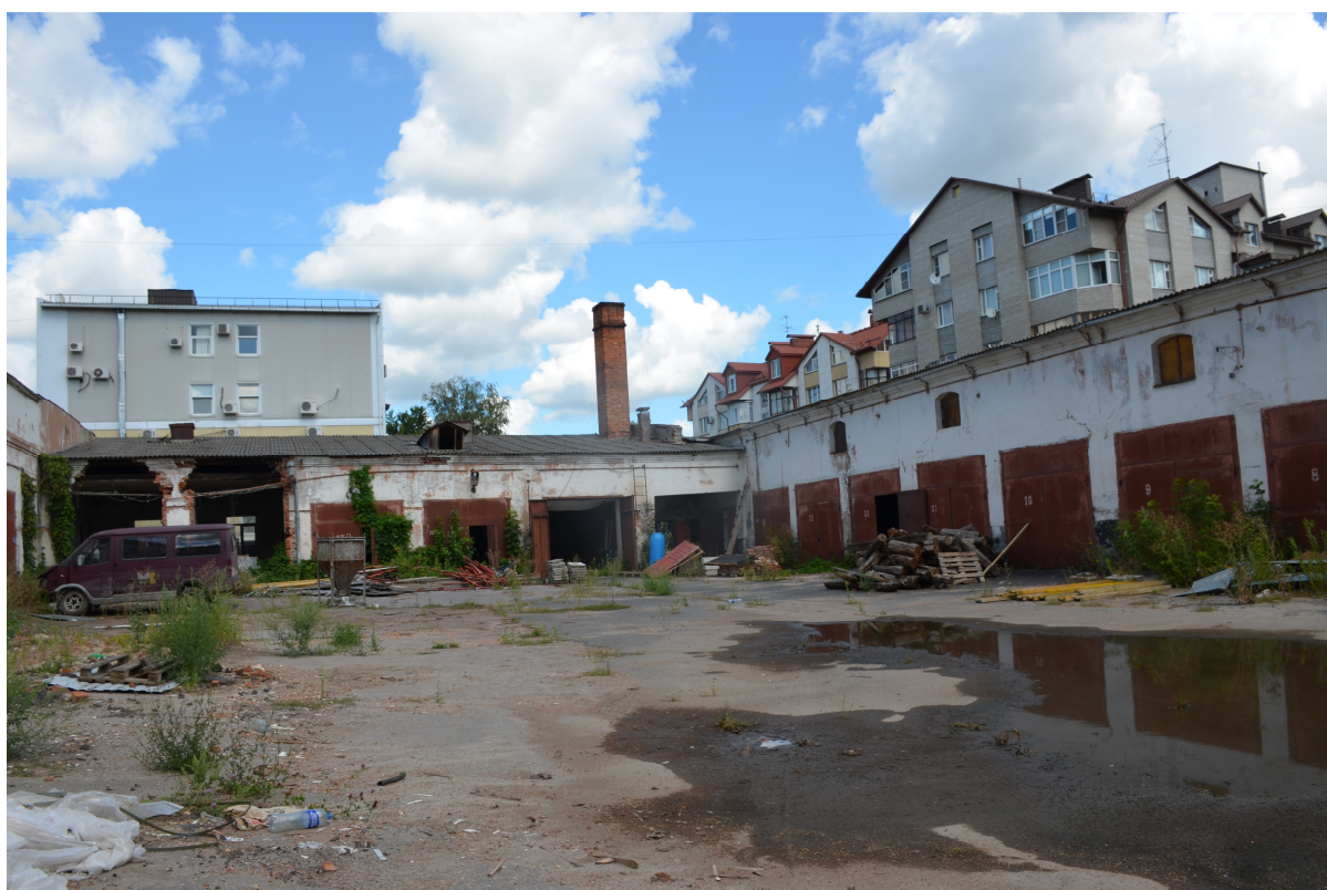
Общий вид периметральной застройки внутридворовой территории с юга
