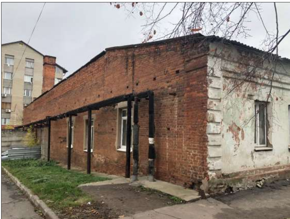
Вид с северо-запада по улице Гайдара на Объект. Северный фасад
