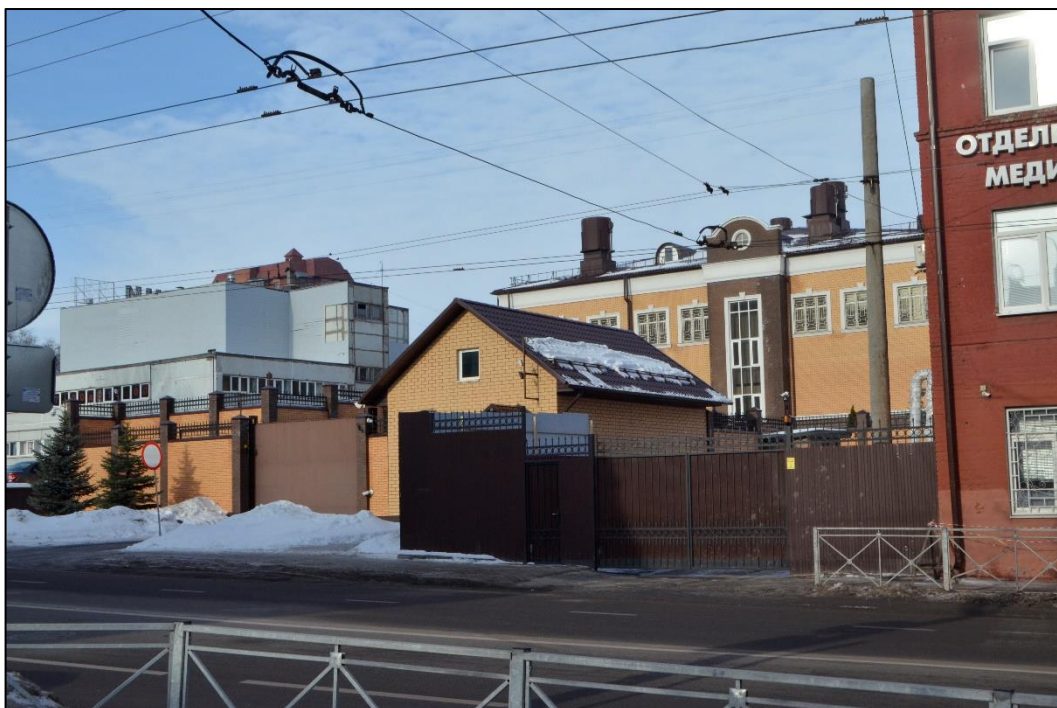
Т.ф.1. Вид на территорию расположения Объекта с юго-востока
