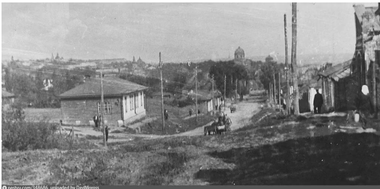
23. Вид на ул. Красной армии. Период создания: 1936 г. Фотограф: Л. Литошенко. Направление съемки: северо-восток.
