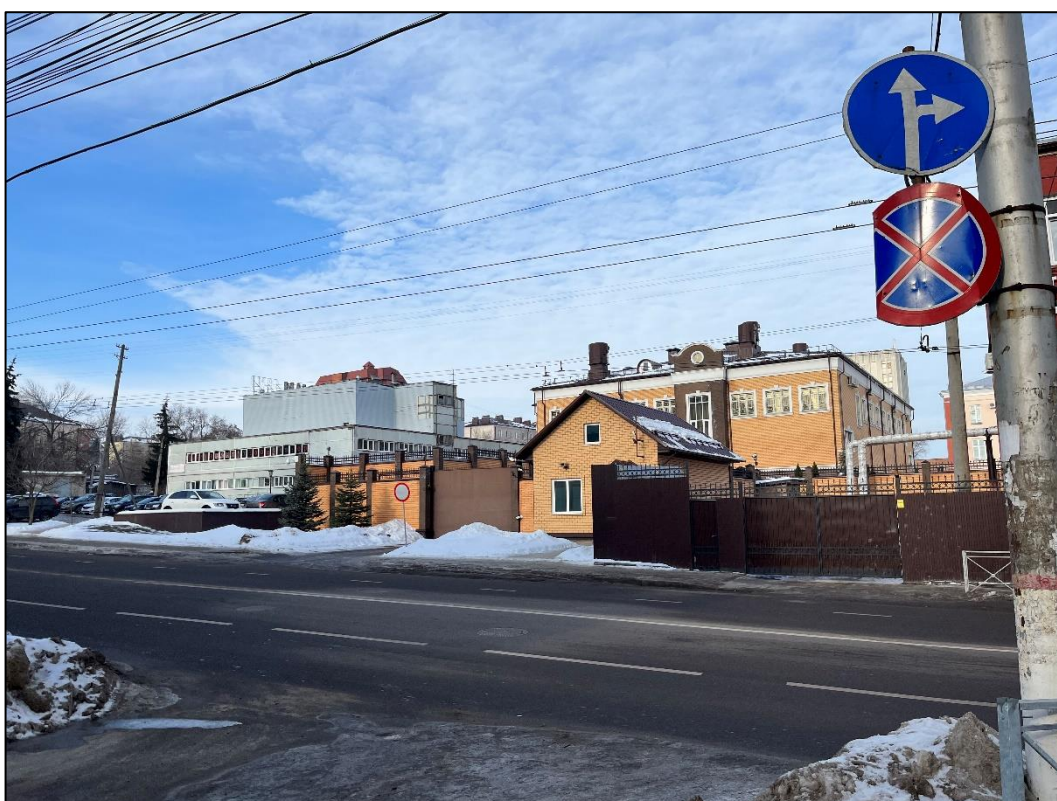
Т.ф.4. Вид на территорию расположения Объекта с юго-востока
