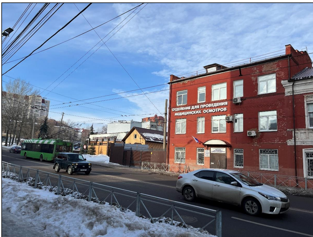
Т.ф.3. Вид на территорию расположения Объекта с востока
