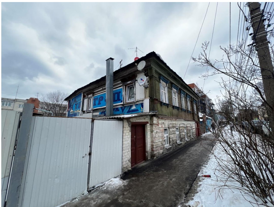
Фотография № 11. Вид с юго-запада на Объект.
