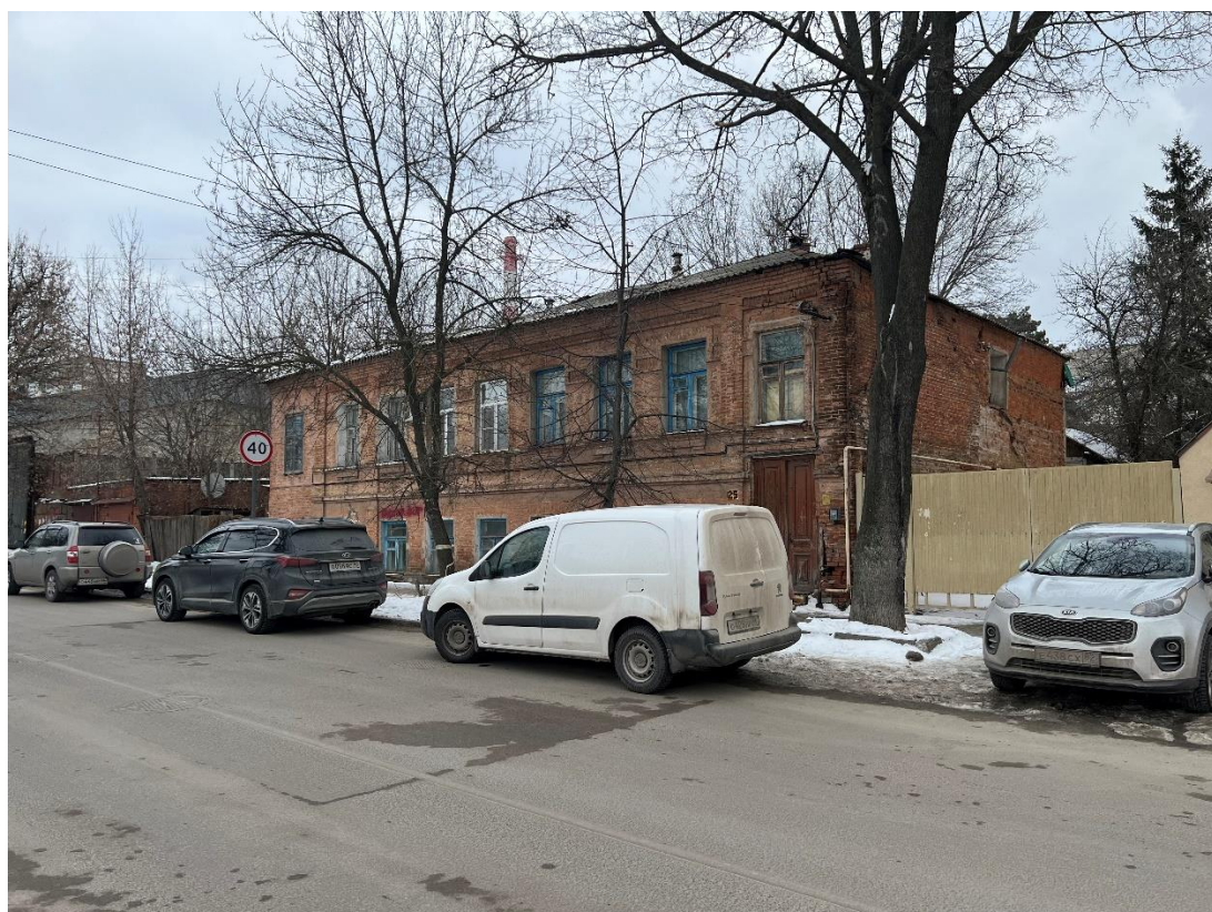
Фотография № 8. Вид с юго-запада на Объект.
