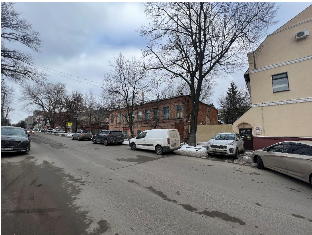
Фотография № 9. Вид с юго-запада на Объект.
