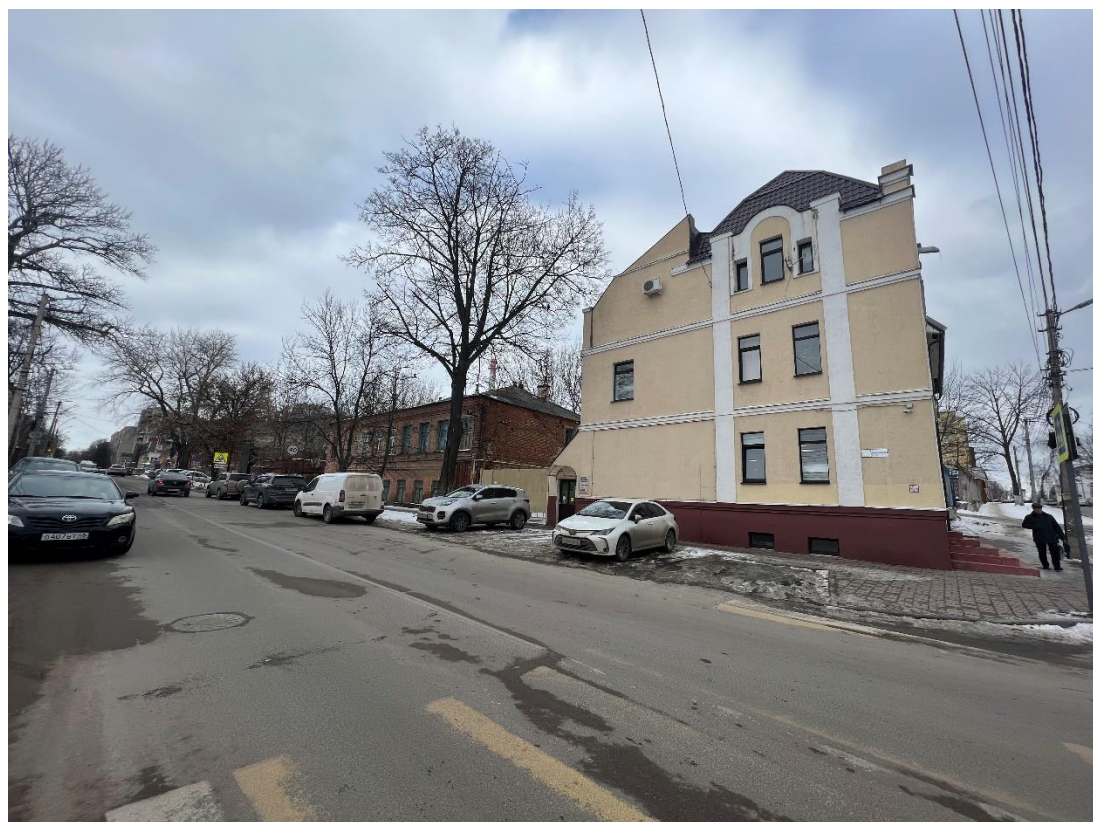
Фотография № 10. Вид с юго-запада на Объект.
