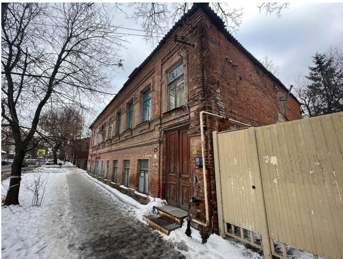
Фотография № 7. Вид с юго-запада на Объект.
