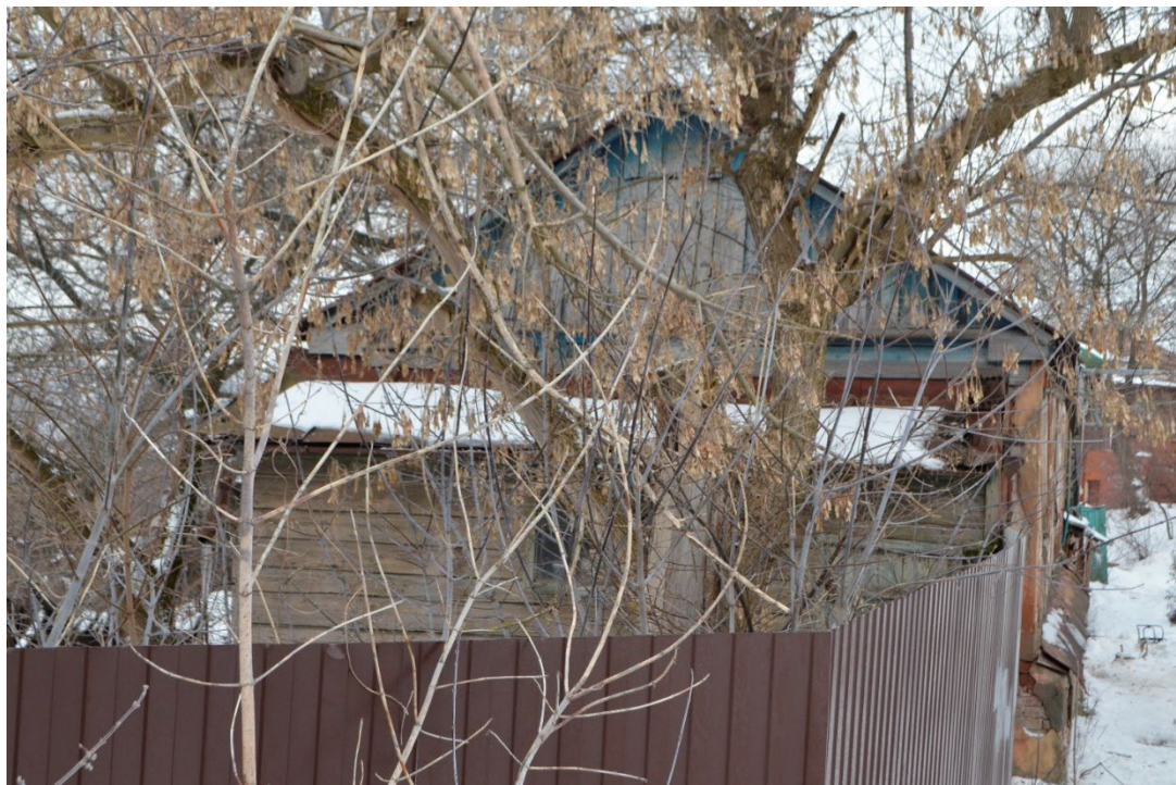
Т.ф. 5. Вид с юго-востока со стороны ул. Марата на боковой фасад Объекта
