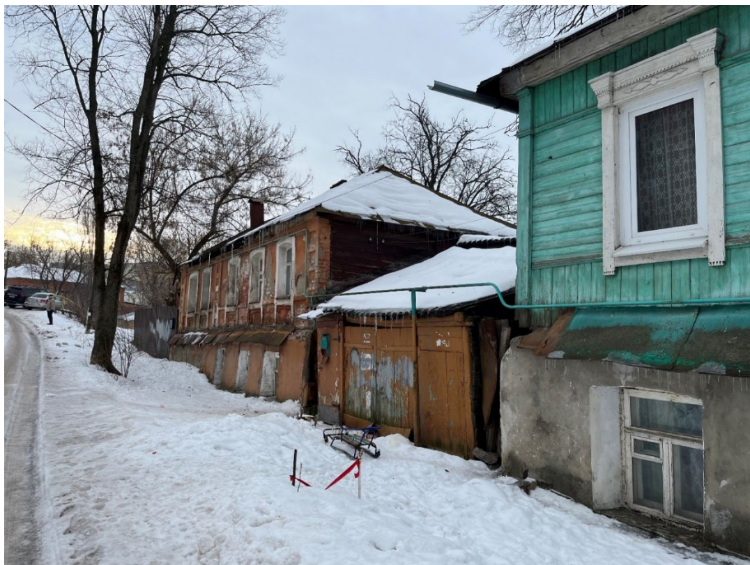
Т.ф. 16. Вид с севера со стороны ул. Марата на главный фасад Объекта в контексте окружающей застройки
