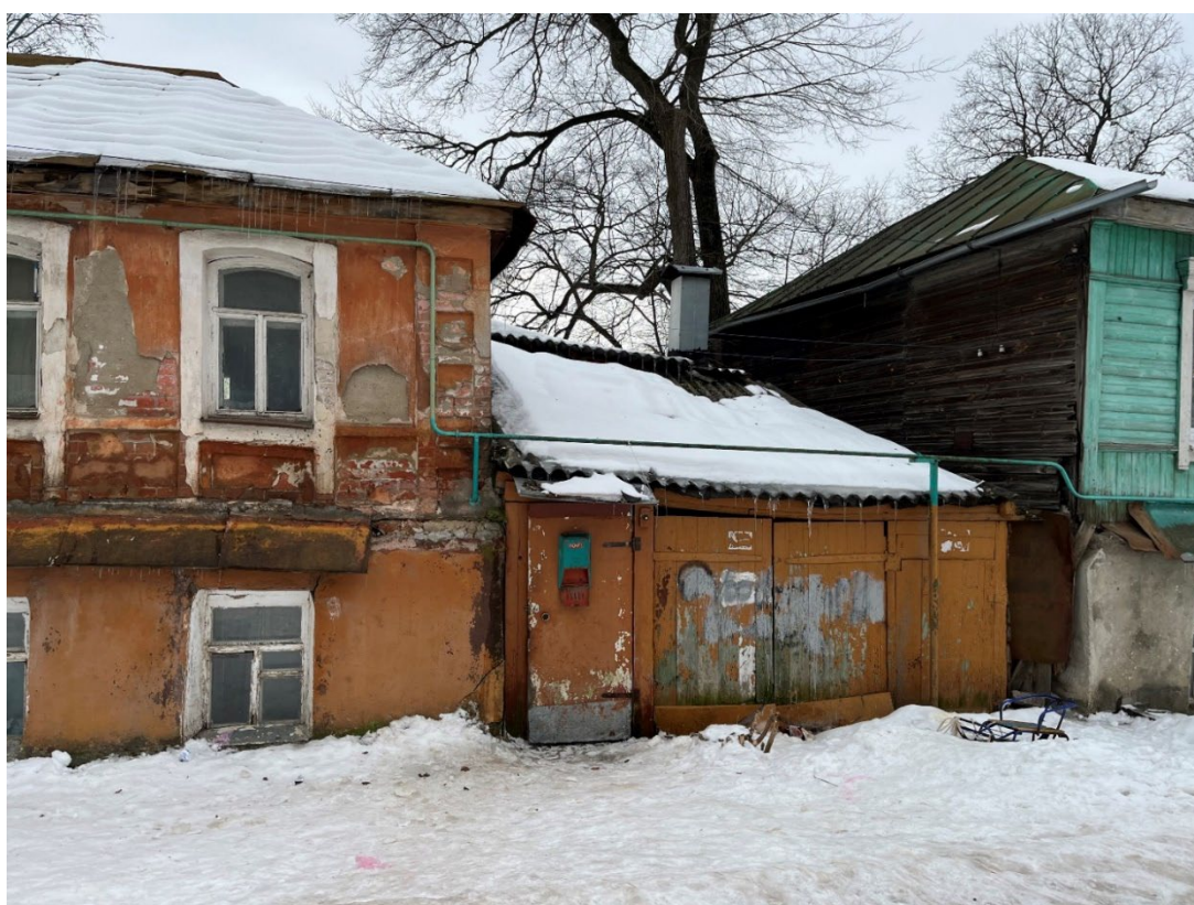
Т.ф. 18. Вид с северо-востока со стороны ул. Марата на главный фасад Объекта с поздней пристройкой
