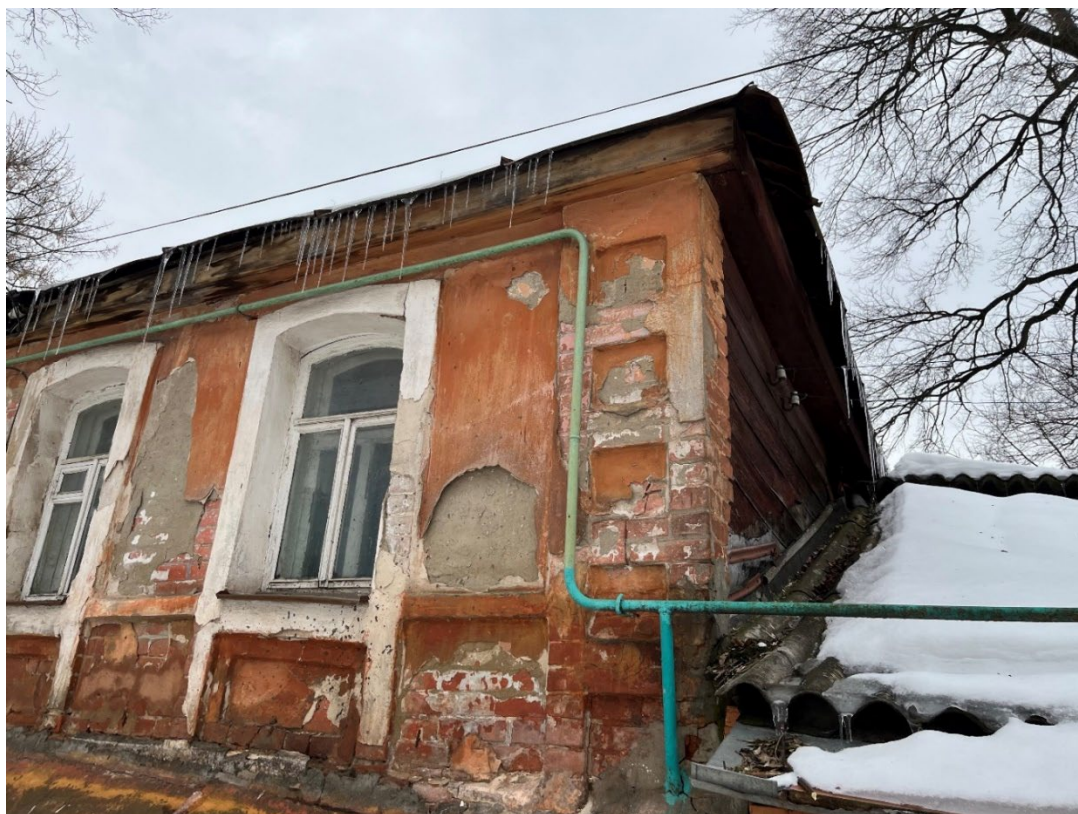
Т.ф. 13. Вид с севера со стороны ул. Марата на главный и боковой фасады Объекта
