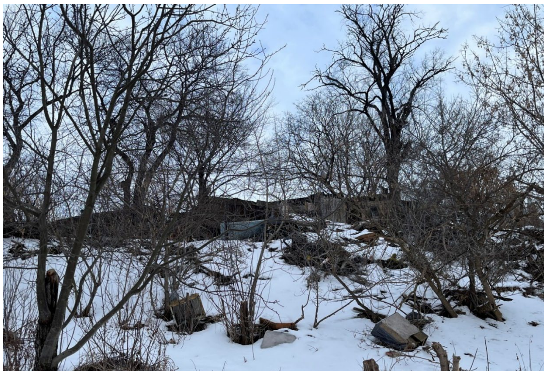
Т.ф. 10. Вид с юга на дворовый фасад Объекта
