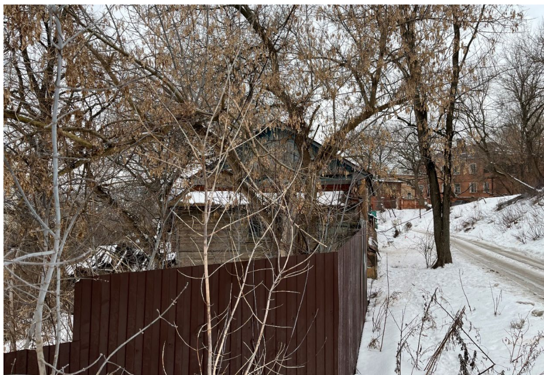
Т.ф. 4. Вид с юго-востока со стороны ул. Марата на боковой фасад Объекта
