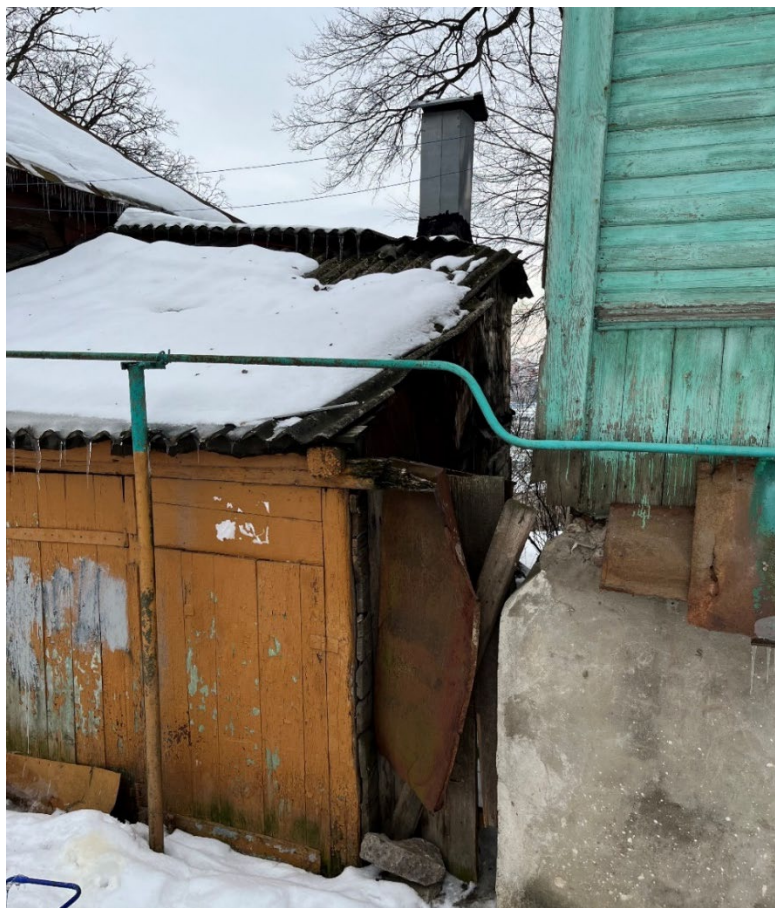
Т.ф. 15. Вид с севера на боковой фасад пристройки к Объекту
