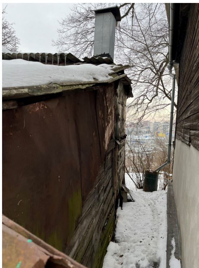
Т.ф. 14. Вид с севера со стороны ул. Марата на боковой фасад пристройки к Объекту
