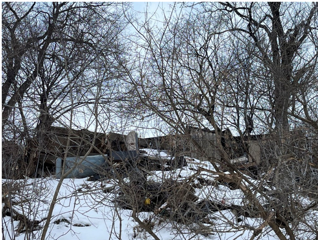
Т.ф. 9. Вид с юга на дворовый фасад Объекта
