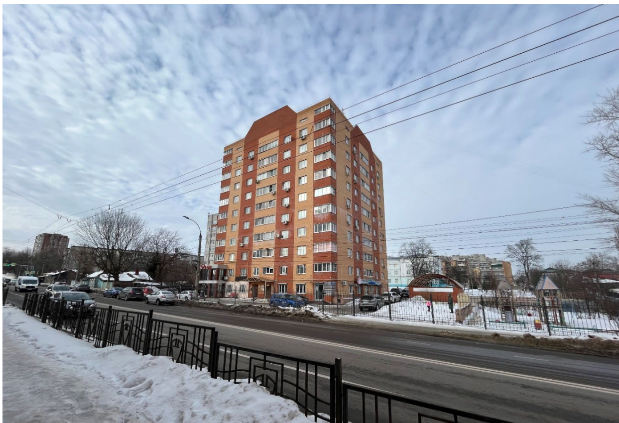
Т.ф. 8. Вид с востока со стороны ул. Красной Армии на территорию расположения Объекта
