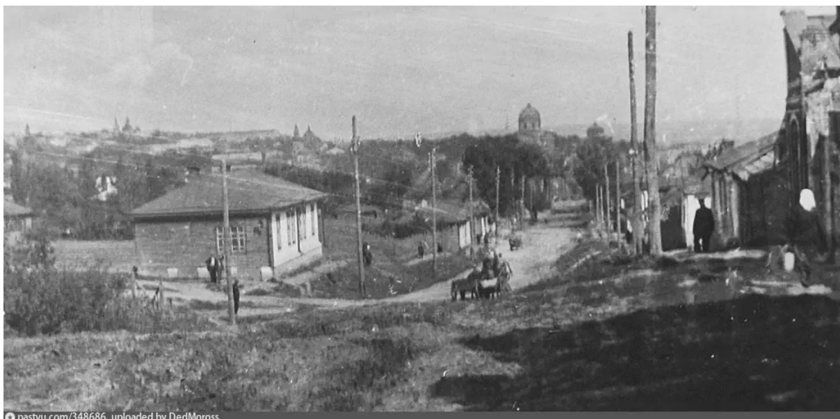
23. Вид на ул. Красной армии. 1936 г. На этой улице расположен рассматриваемый Объект. Автор: Л. Литошенко. Направление съемки: северо-восток.
