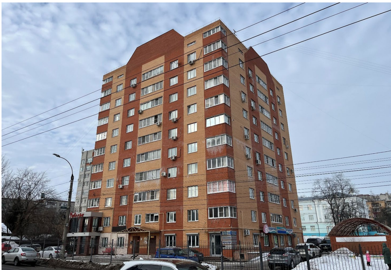
Т.ф. 9. Вид с востока со стороны ул. Красной Армии на территорию расположения Объекта
