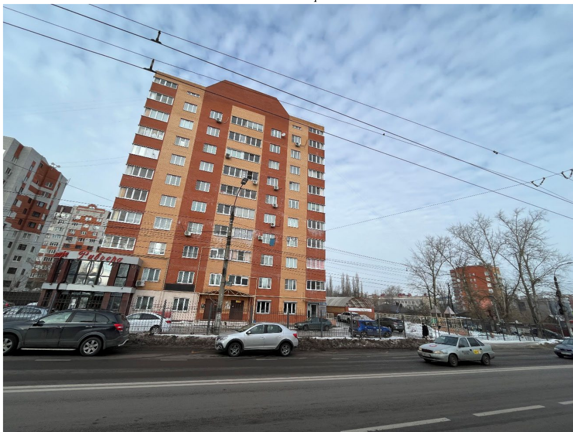
Фотография территории месторасположения Объекта Вид с юга. Февраль 2024 г.
