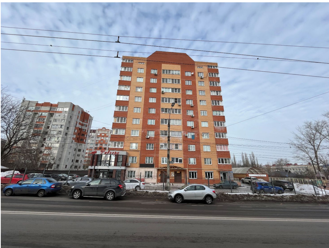
Т.ф. 6. Вид с юго-востока со стороны ул. Красной Армии на территорию расположения Объекта
