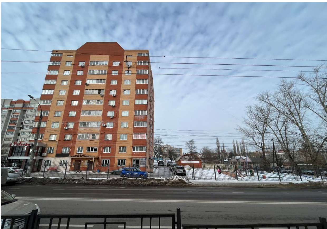
Т.ф. 7. Вид с юго-востока со стороны ул. Красной Армии на территорию расположения Объекта
