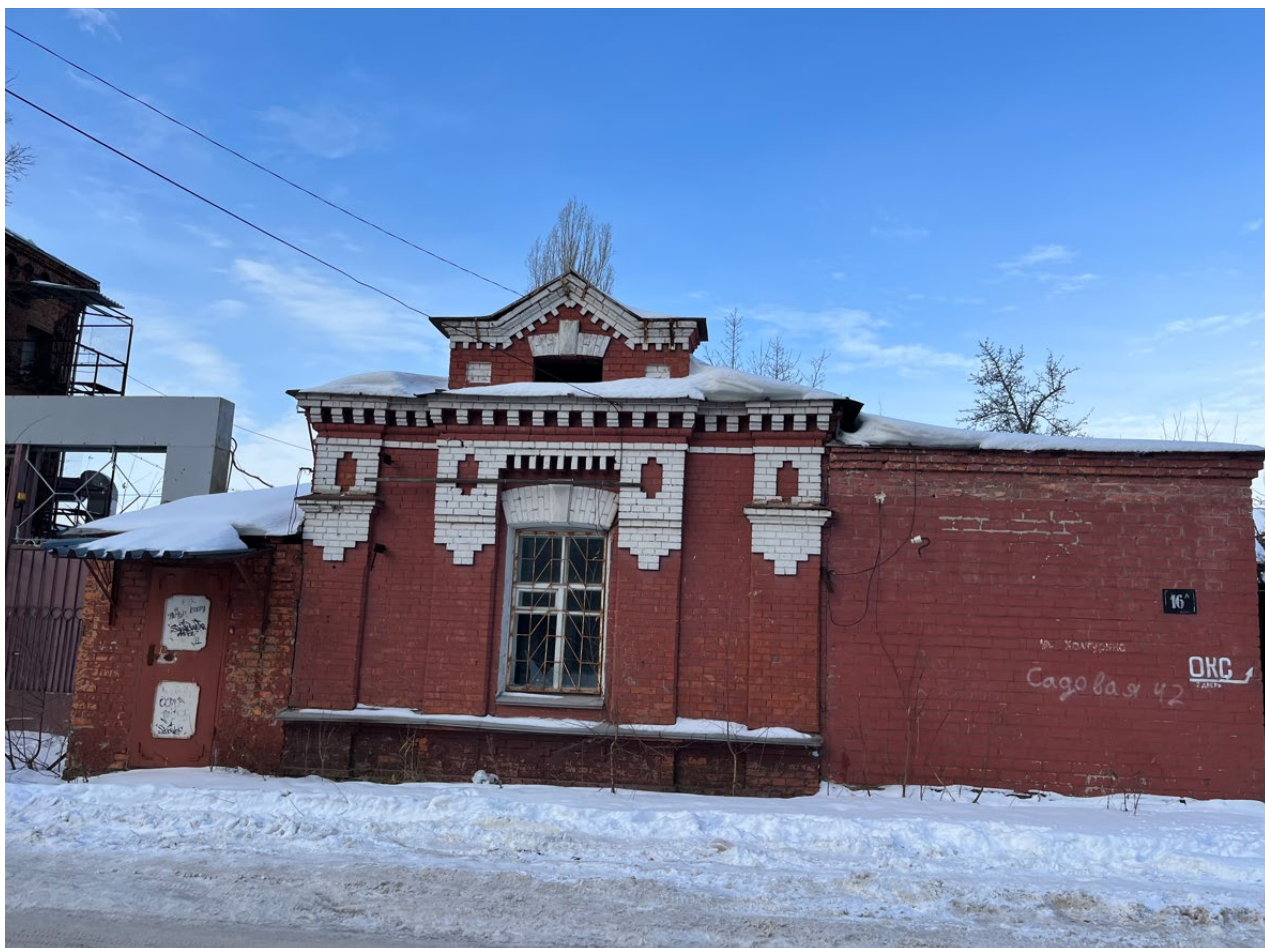
Выявленный объект культурного наследия «Проходная», 1904 г., расположенный по адресу: Курская область, г. Курск, ул. Халтурина, 16, входящий в состав выявленного объекта культурного наследия «Ансамбль спиртзавода Сперанского», 1904 г., расположенного по адресу: Курская область, г. Курск, ул. Халтурина, 16
