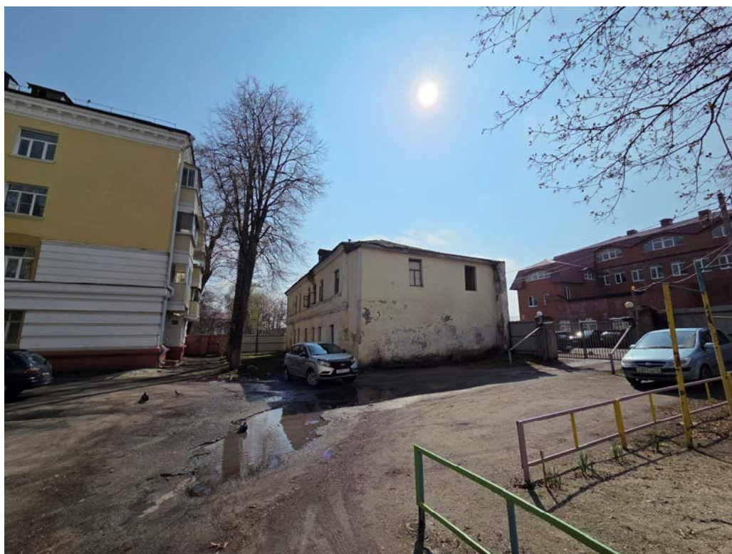
4. Вид с северо-запада.
