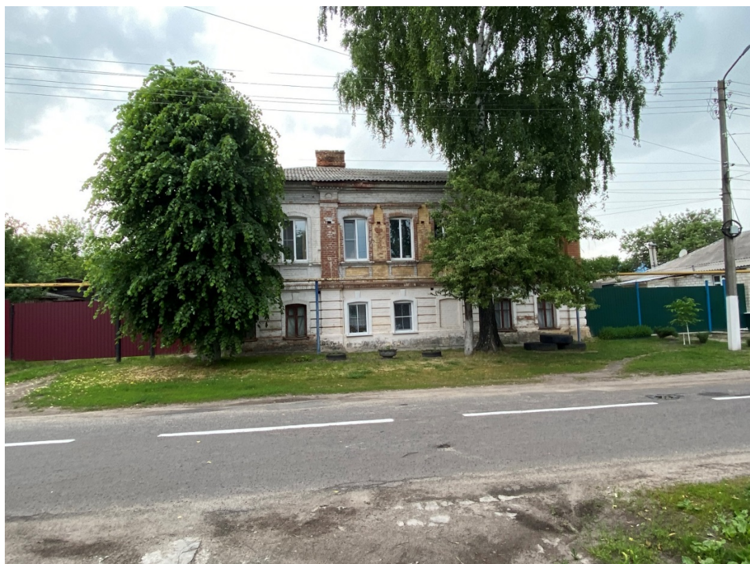
Фотография № 6. Вид с востока на Объект.
