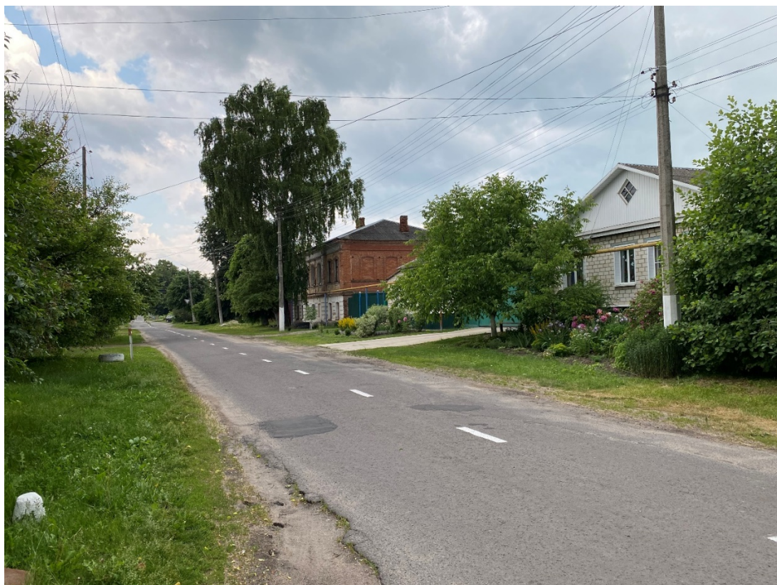
Фотография № 1. Вид с северо-востока на Объект.
