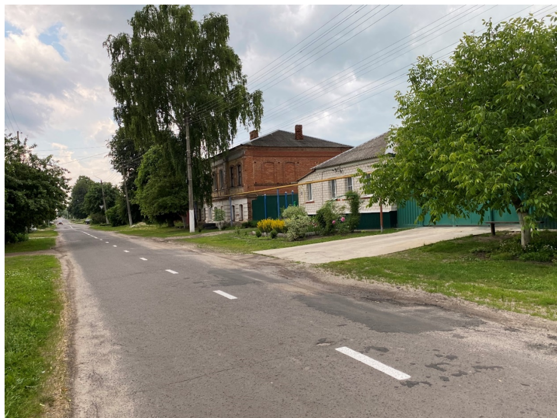
Фотография № 2. Вид с северо-востока на Объект.
