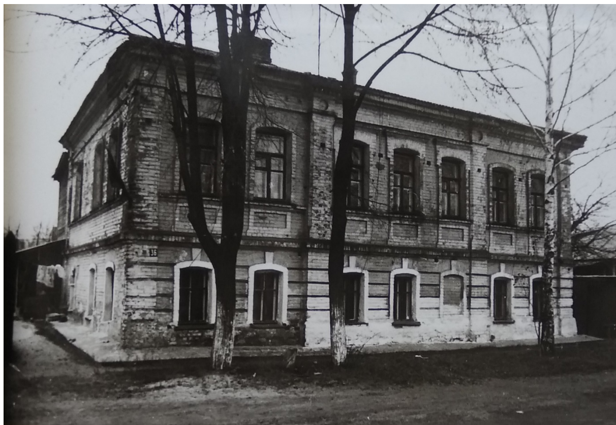
16. Дом по ул. Урицкого, 36. Здание Объекта на фотографии в «Проекте охранных зон г. Рыльска Курской обл.» 1990 года.
