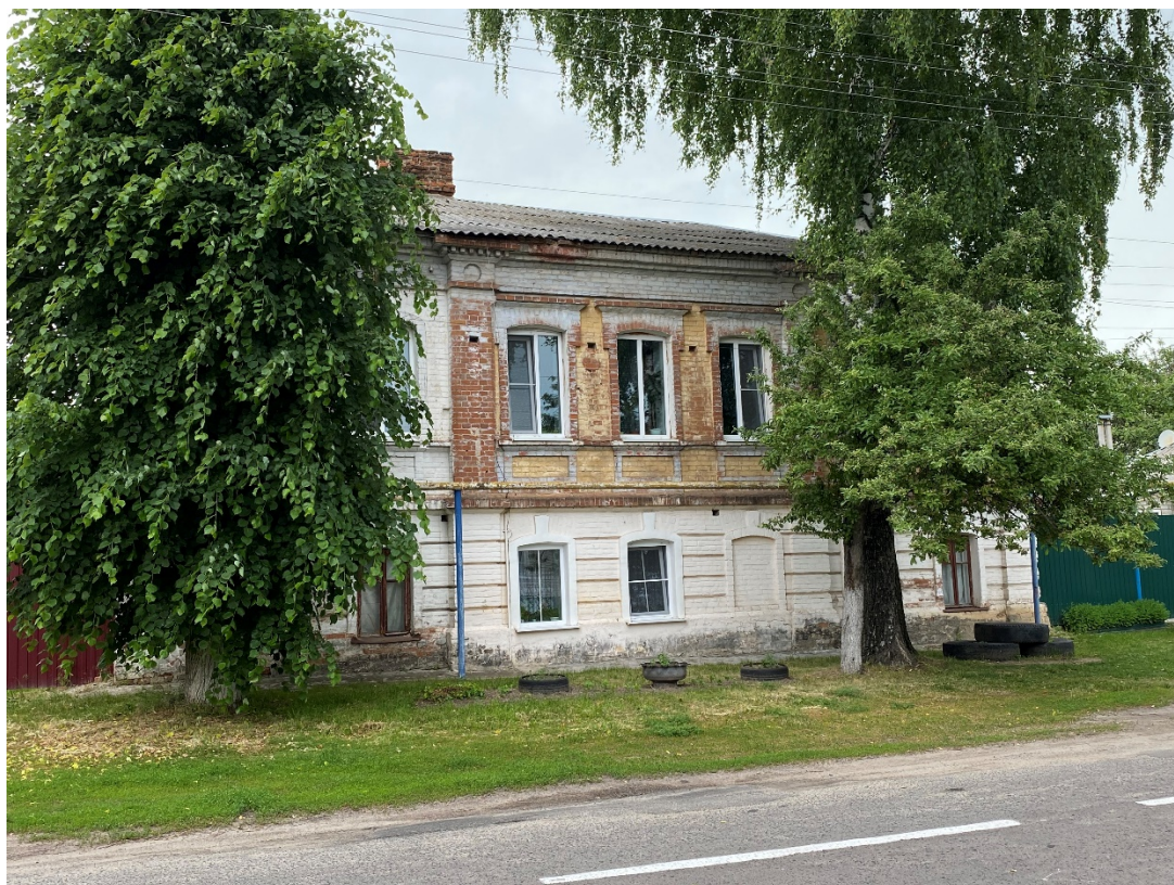
Фотография № 7. Вид с юго-востока на Объект.
