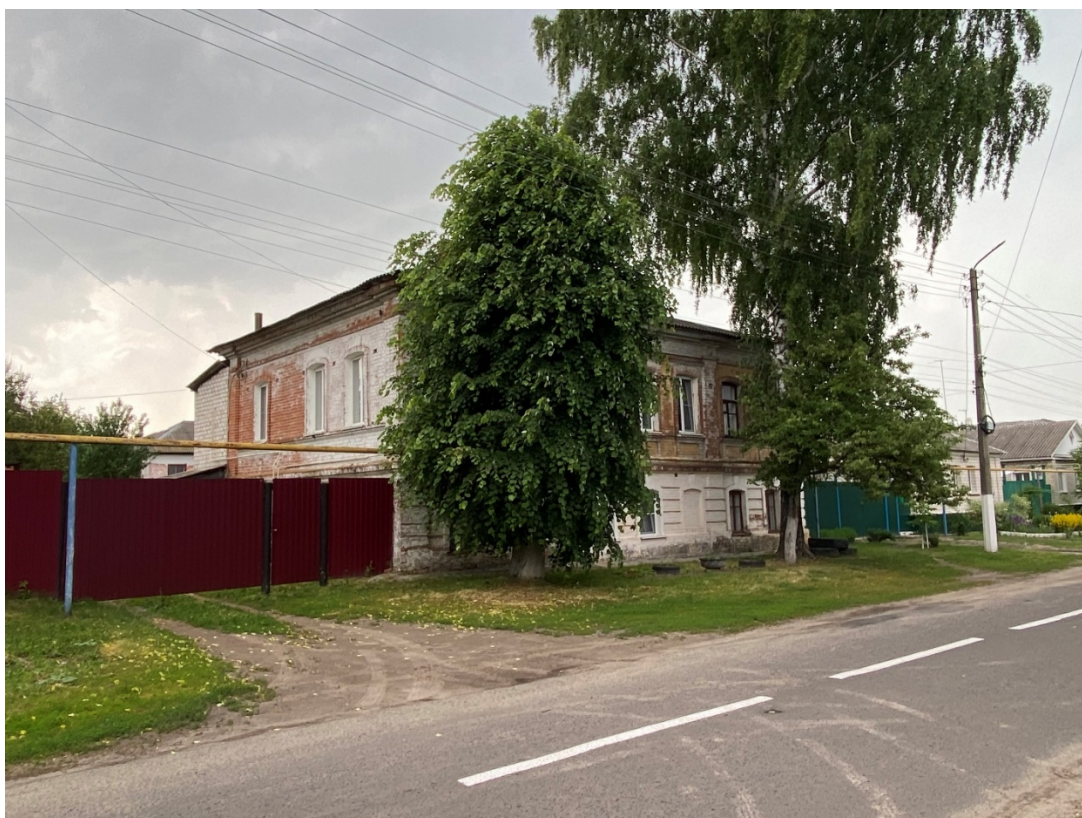
Фотография № 8. Вид с юго-востока на Объект.
