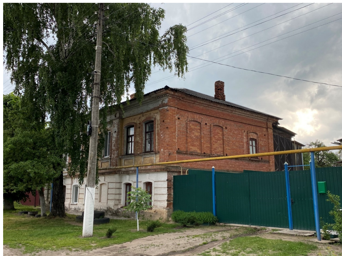
Фотография № 4. Вид с северо-востока на Объект.
