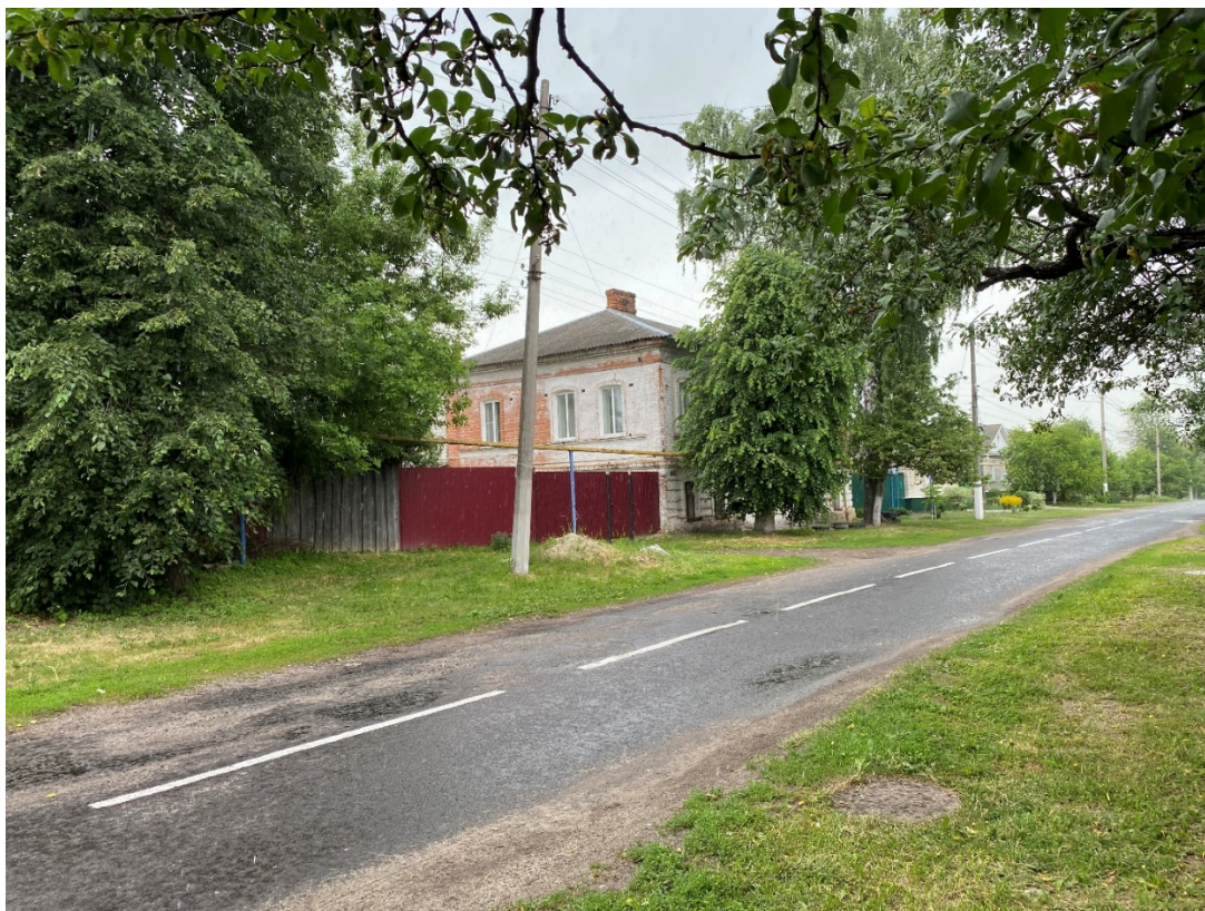
Фотография № 10. Вид с юго-востока на Объект.
