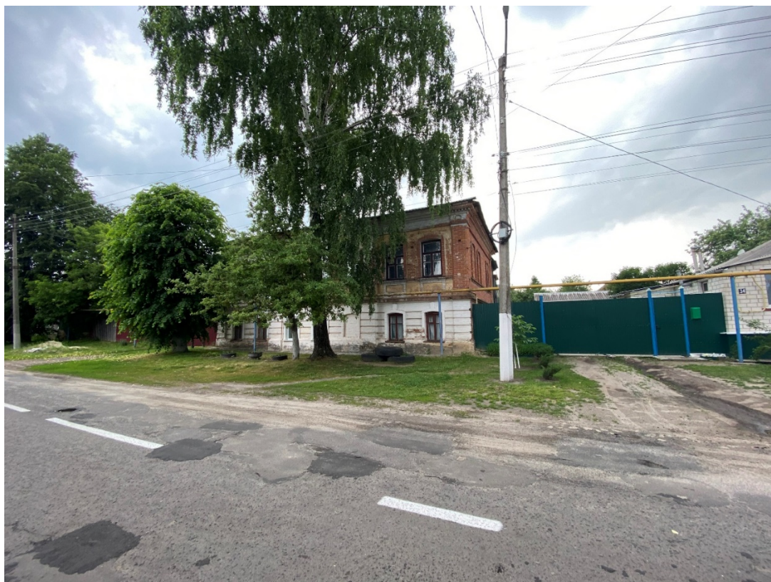
Фотография № 5. Вид с северо-востока на Объект.
