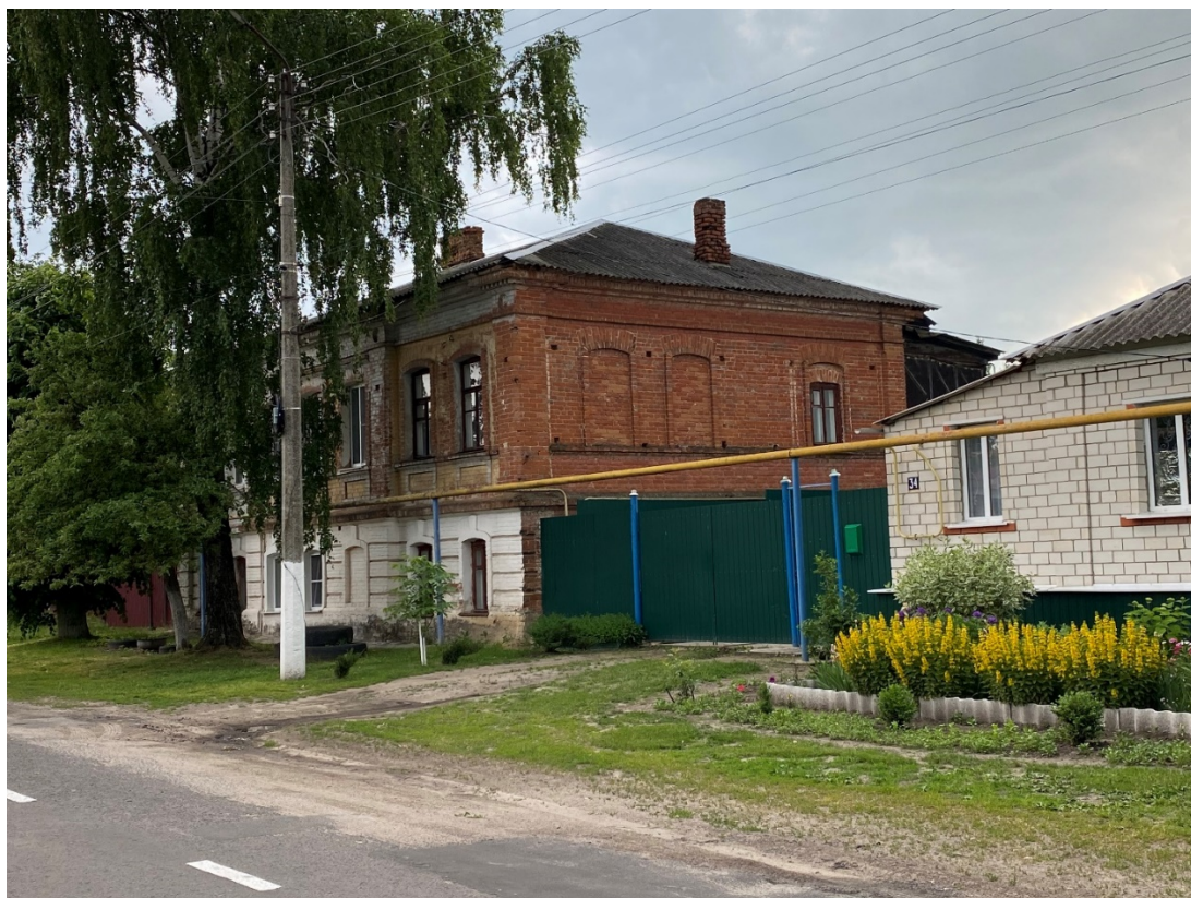
Фотография № 3. Вид с северо-востока на Объект.
