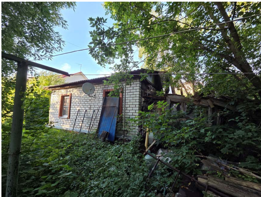
9. Вид с запада со двора. Северная и южная части дома.
