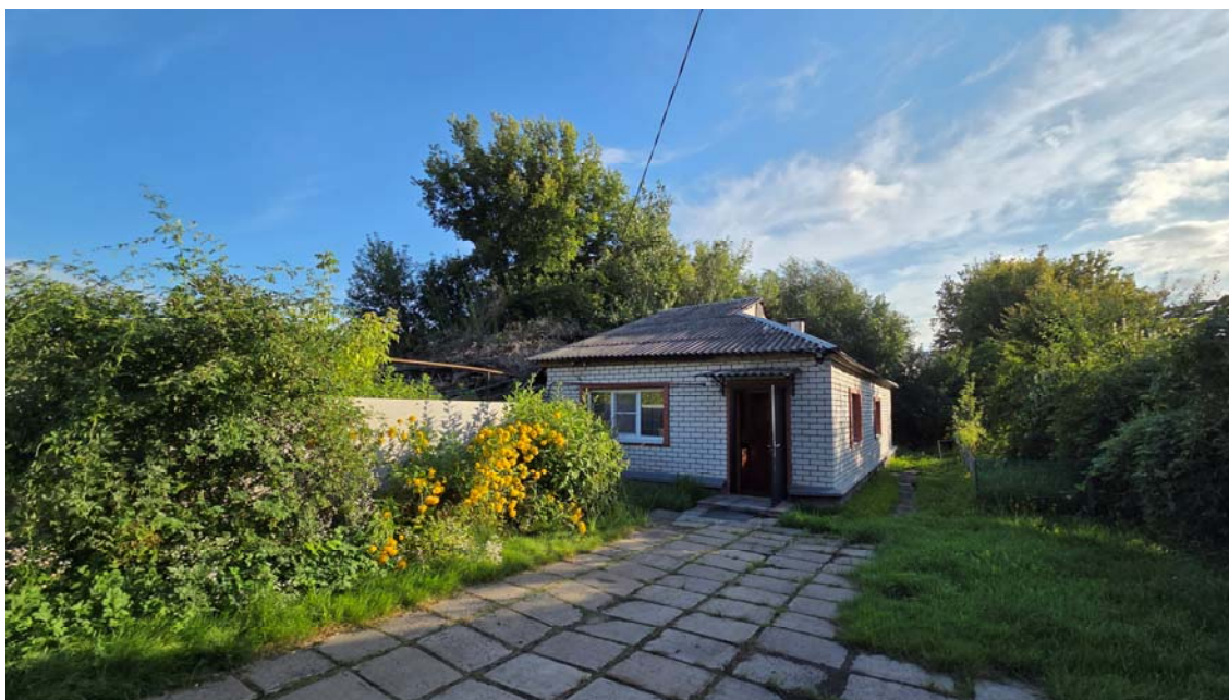
6. Вид с востока со двора. Северная часть дома.
