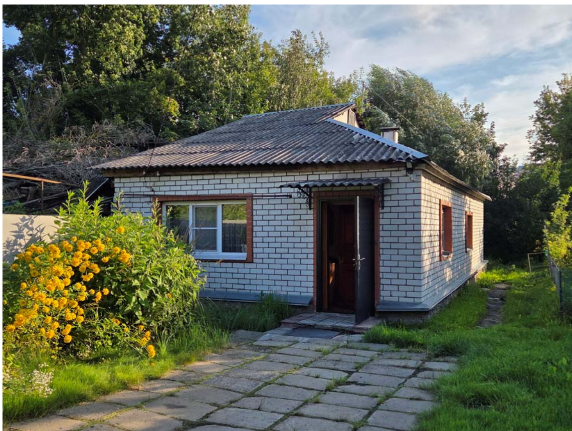
7. Вид с востока со двора. Северная часть дома.
