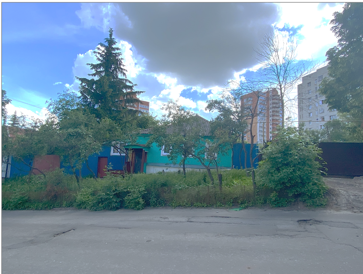
Фотография 1: Выявленный объект культурного наследия «Дом жилой», 1910 г. (Курская область, г. Курск, ул. Лысая гора, 5). Вид с ул. Лысая гора. Фотография выполнена в июле 2021 года. Автор А.Ф. Мартынов.
