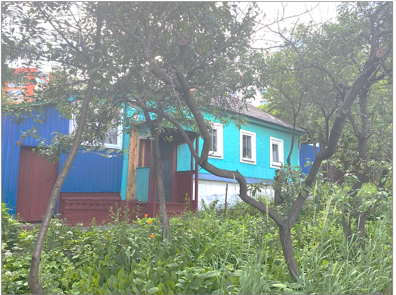
Фотография 2: Выявленный объект культурного наследия «Дом жилой», 1910 г. (Курская область, г. Курск, ул. Лысая гора, 5). Вид с ул. Лысая гора. Фотография выполнена в июле 2021 года. Автор А.Ф. Мартынов.
