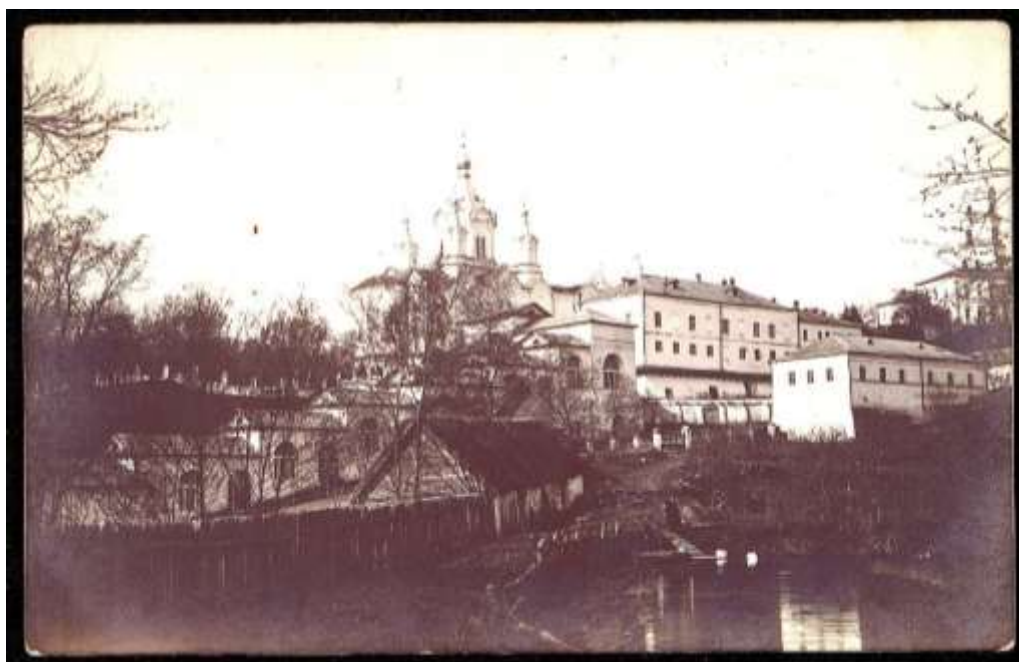
20. Коренная пустынь. Вид с северо-восточной стороны. На переднем плане часть монастырского пруда. Период создания: начало 1910-х гг.
