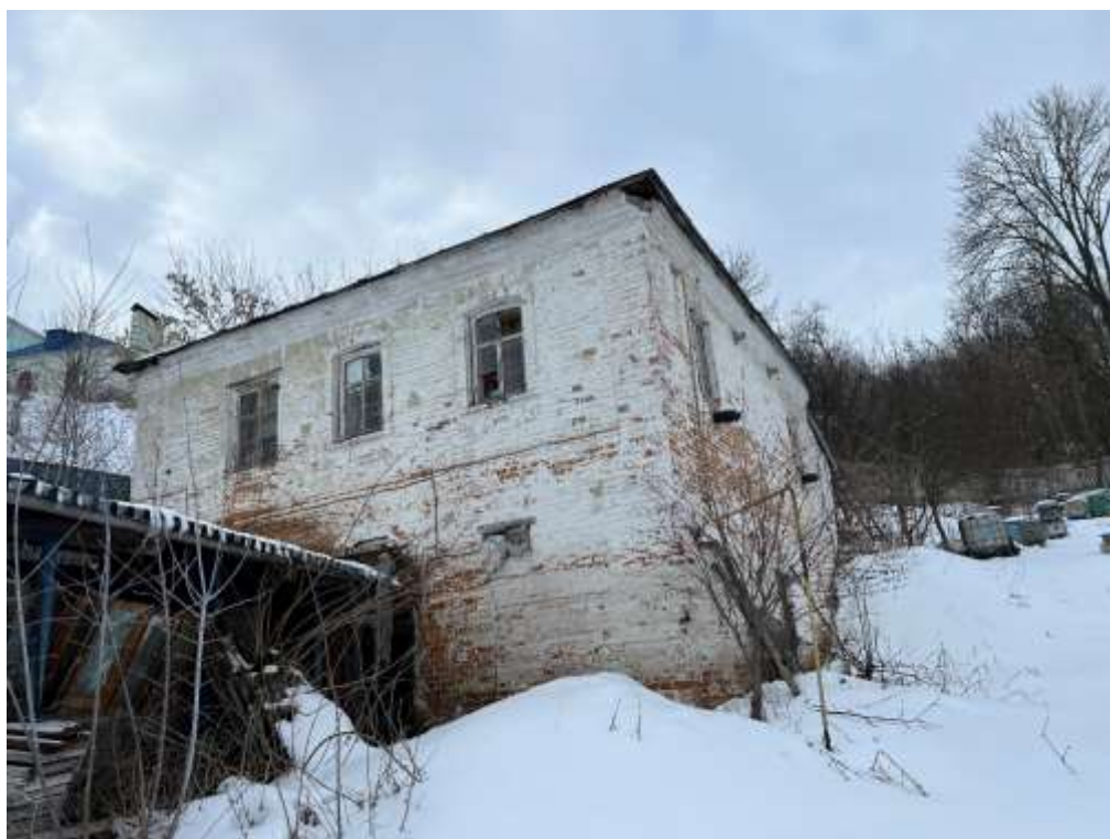
Т.ф. 2. Общий вид Объекта с северо-восточной стороны
