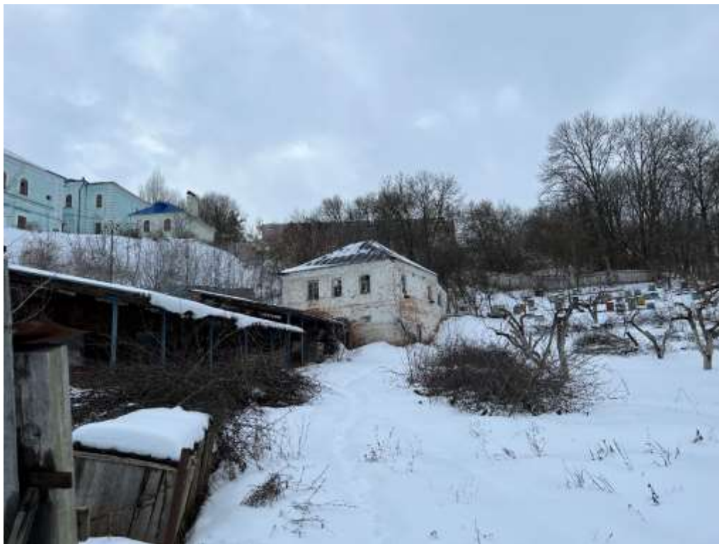
Т.ф. 1. Общий вид Объекта
