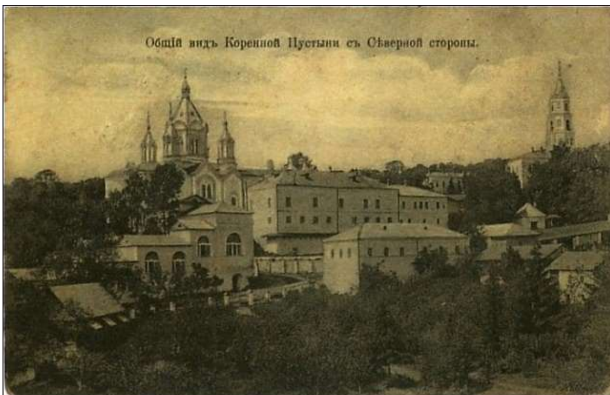
28. Общий вид Коренной Пустыни с Северной стороны.
