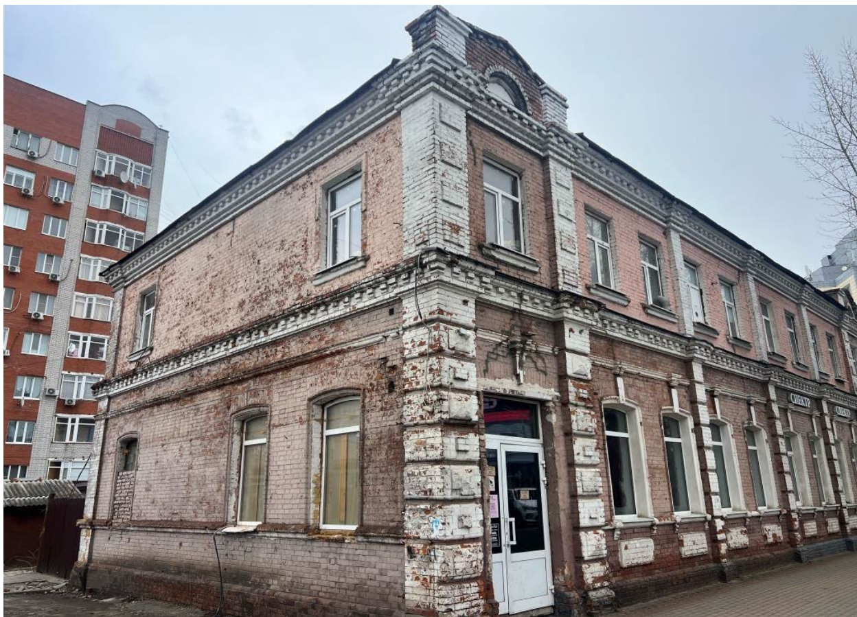
Фото 3. Общий вид юго-западного и северо-западного фасада Объекта.
