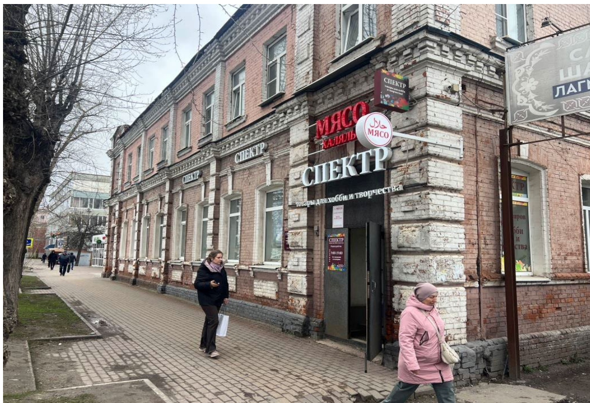
Фото 1. Общий вид Объекта со стороны главного (юго-западного) фасада.
