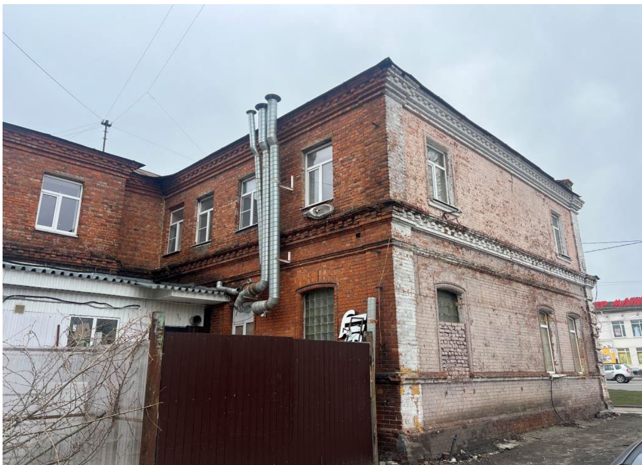
Фото 4. Общий вид Объекта со двора.
