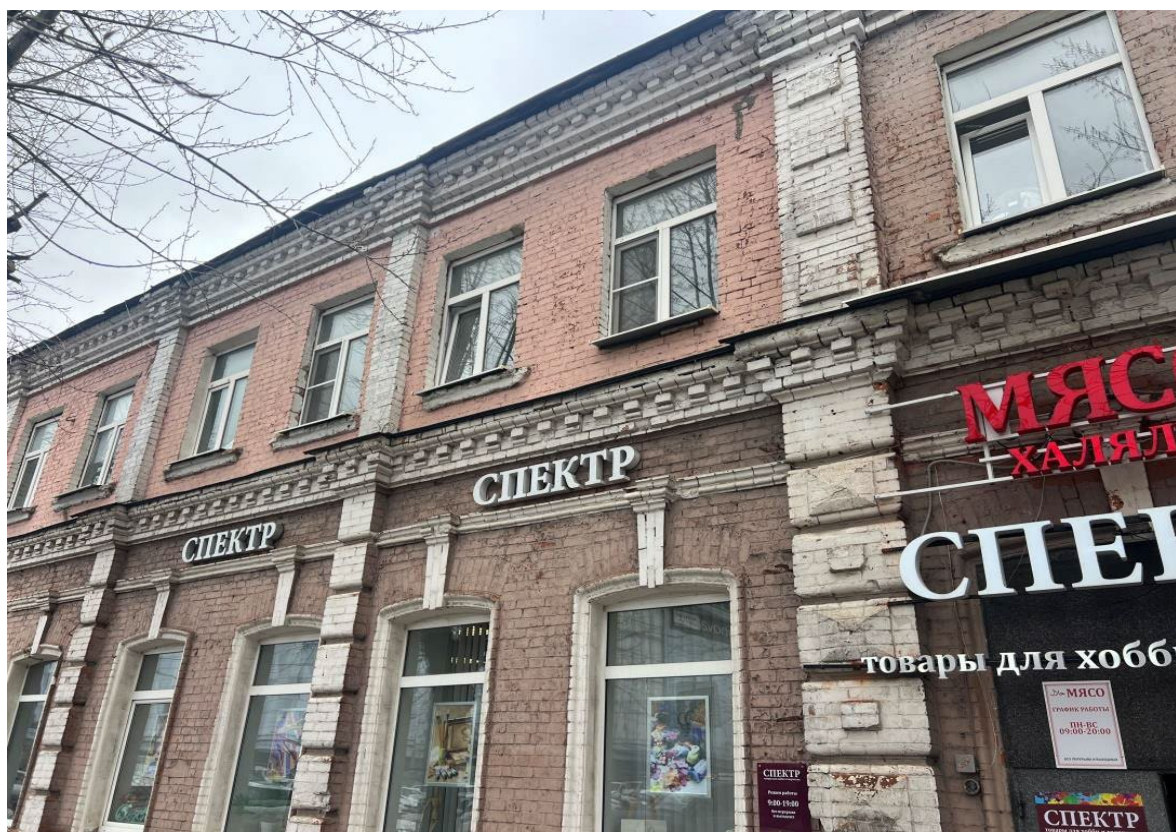
Фото 2. Фрагмент юго-западного фасада Объекта (центральная часть).
