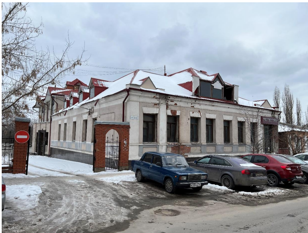
Фотография № 2. Вид с северо-запада на Объект.
