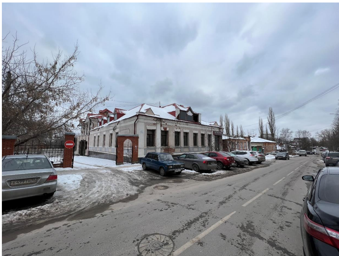
Фотография № 1. Вид с северо-запада на Объект.
