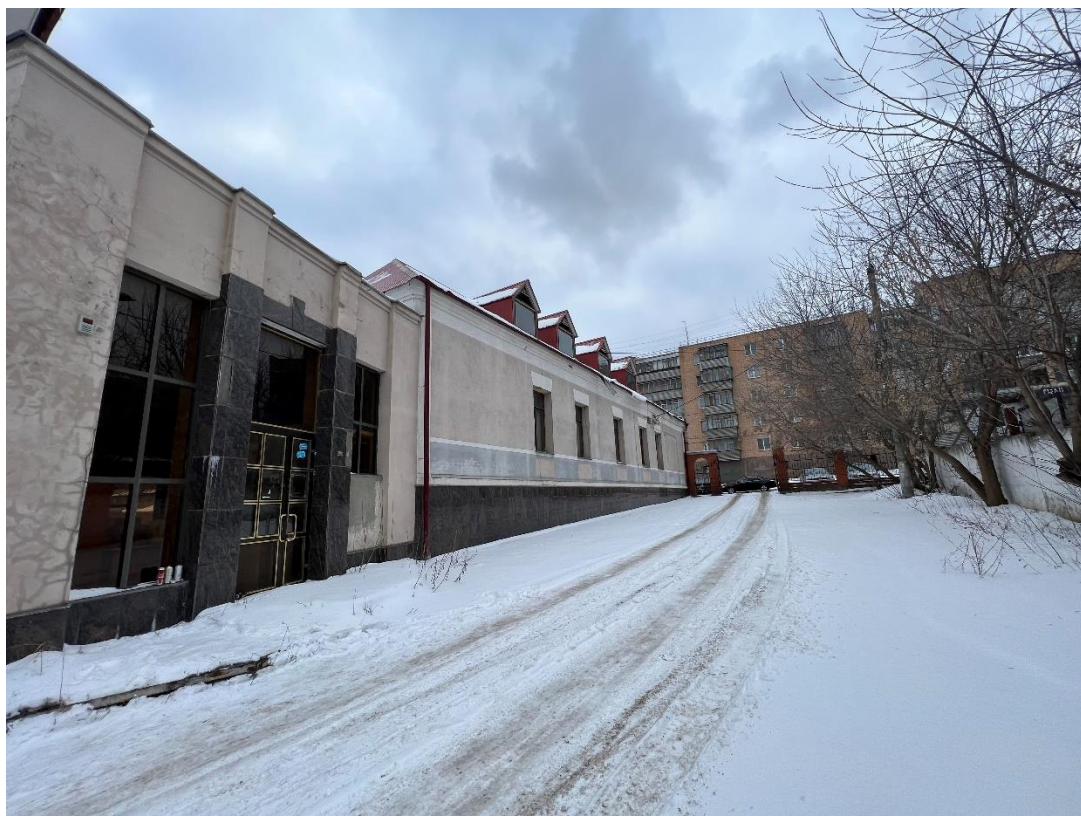
Фотография № 4. Вид с северо-востока на Объект.
