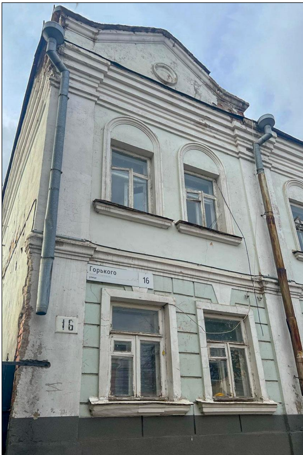
Т.ф.3. Вид на фрагмент восточного фасада Объекта с юго-востока
