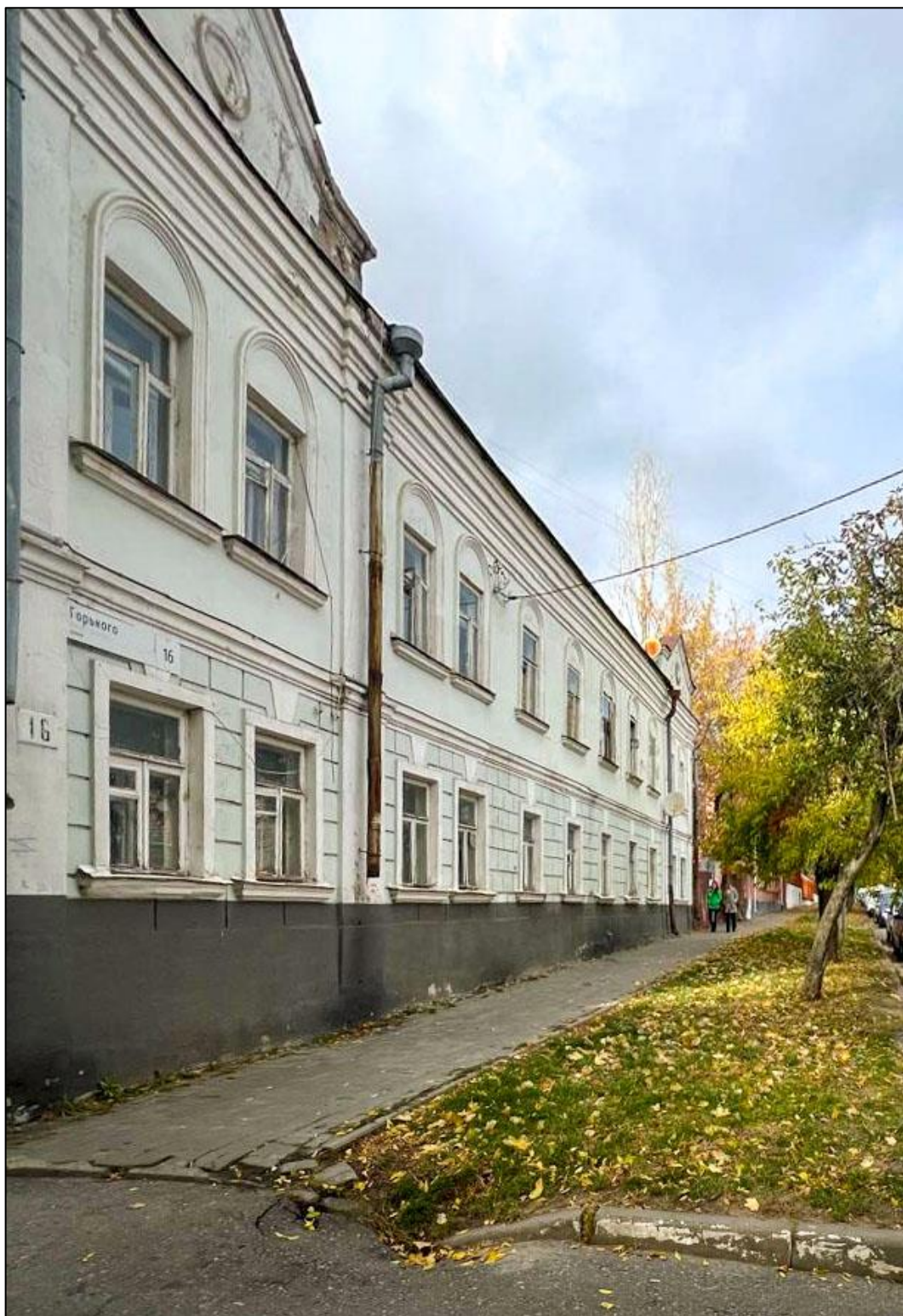
Т.ф.4. Вид на восточный фасад Объекта с юго-востока
