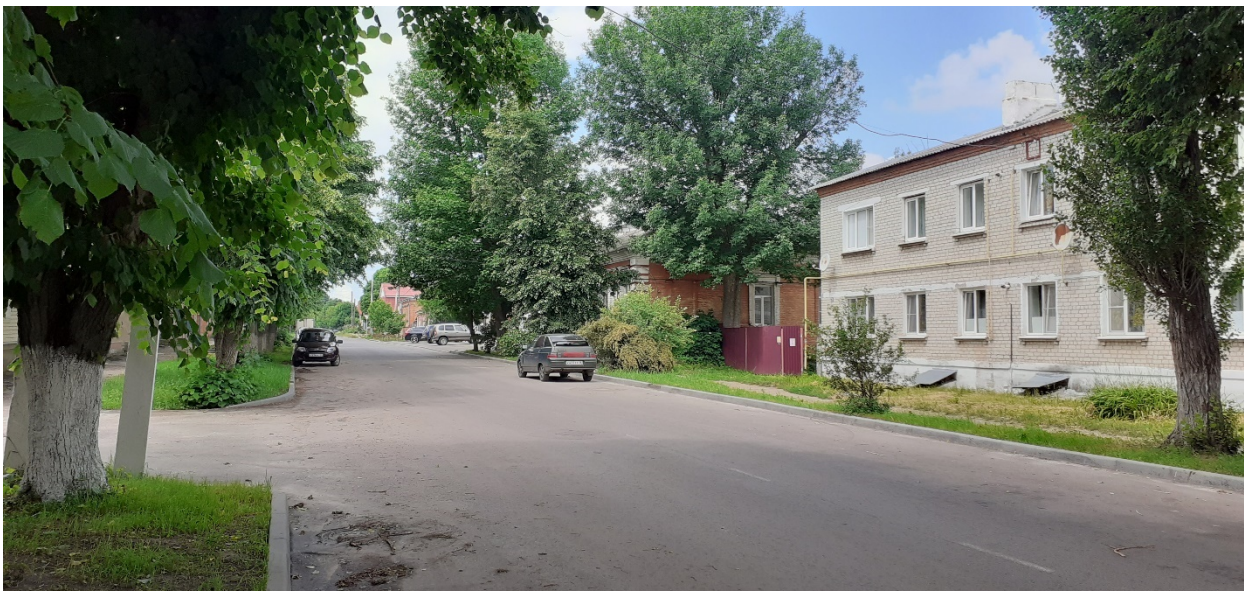
Фотография № 1. Вид с юго-востока на Объект.
