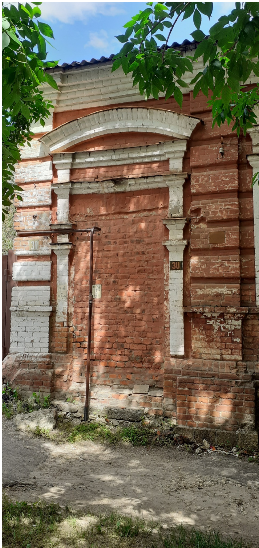
Фотография № 11. Вид с юго-запада на Объект.
