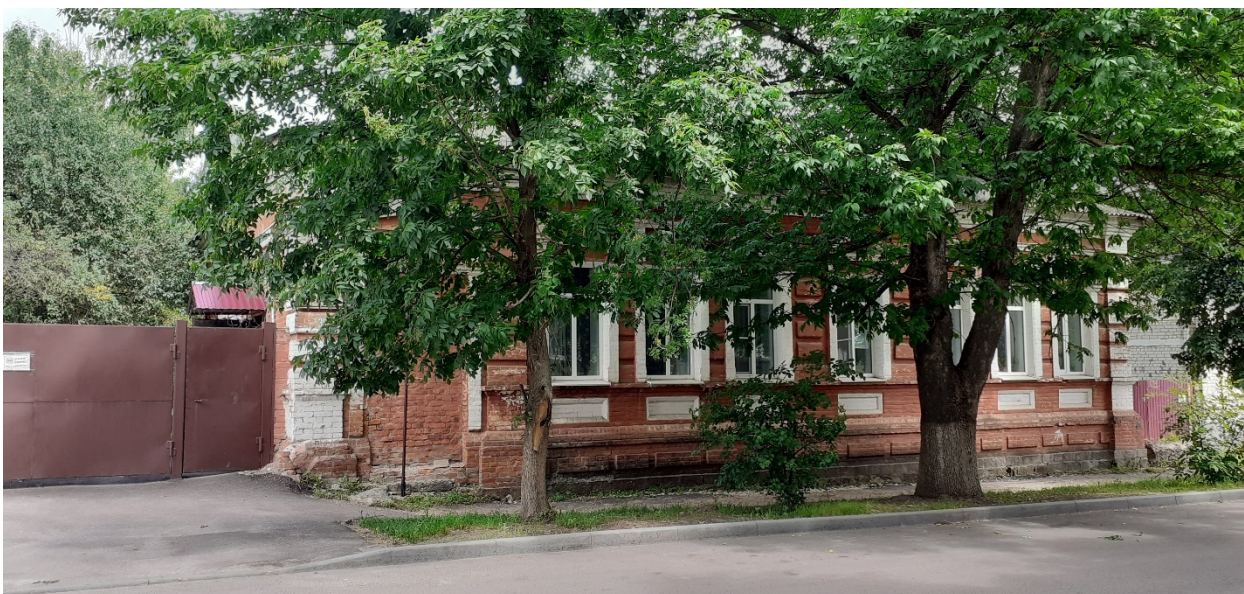
Фотография № 6. Вид с юго-запада на Объект.
