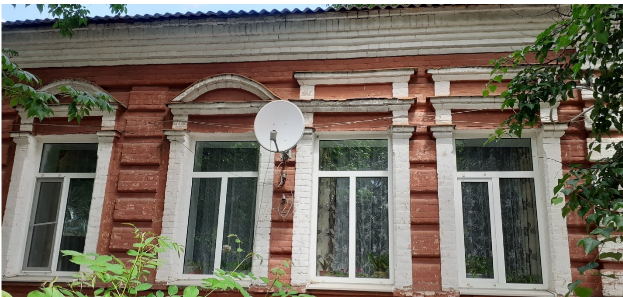
Фотография № 9. Вид с юго-запада на Объект.
