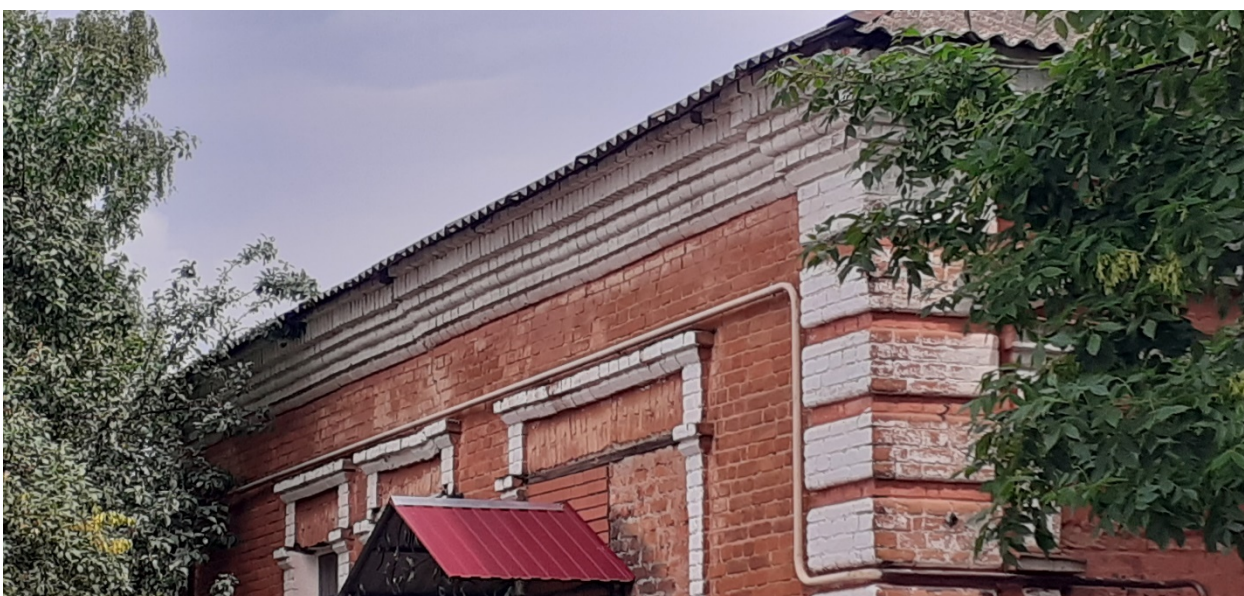
Фотография № 10. Вид с юго-запада на Объект.
