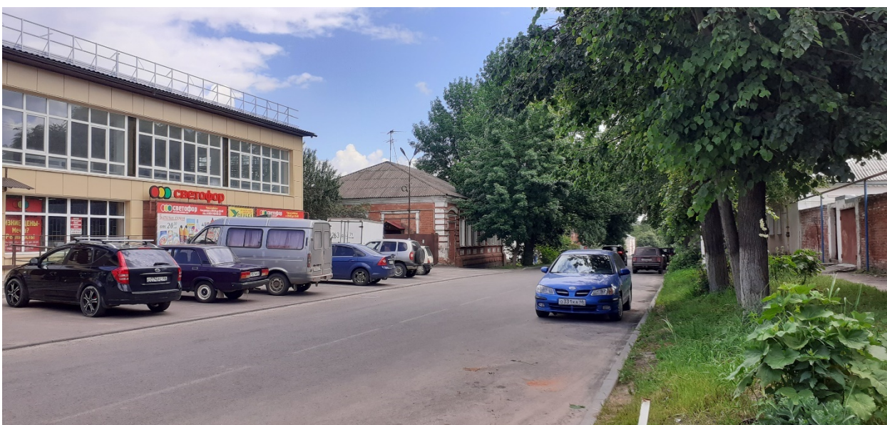
Фотография № 8. Вид с юго-запада на Объект.
