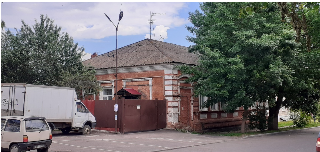
Фотография № 7. Вид с юго-запада на Объект.
