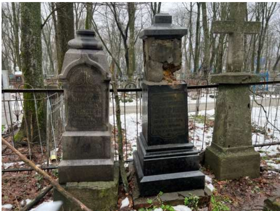
Фотография № 1. Вид с юго-запада на Объект.
