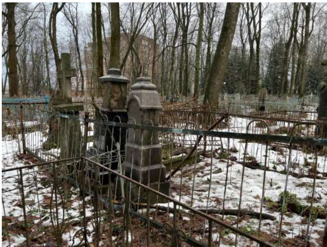
Фотография № 3. Вид с севера на Объект.
