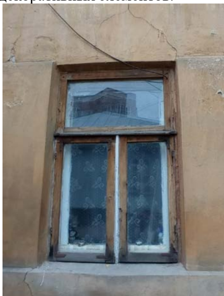
Южный фасад. Оконный проем первого этажа
