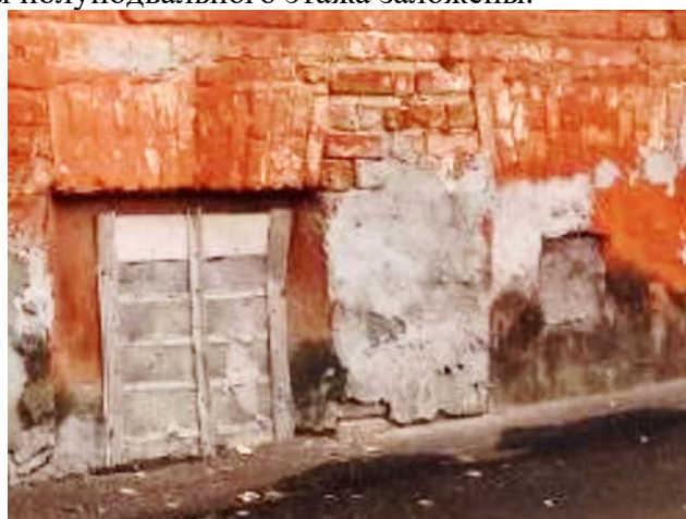
Восточный фасад. Оконные проемы
