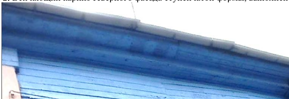
Северный фасад. Венчающий карниз
