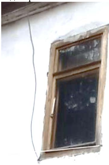
Восточный фасад. Оконный проем второго этажа
