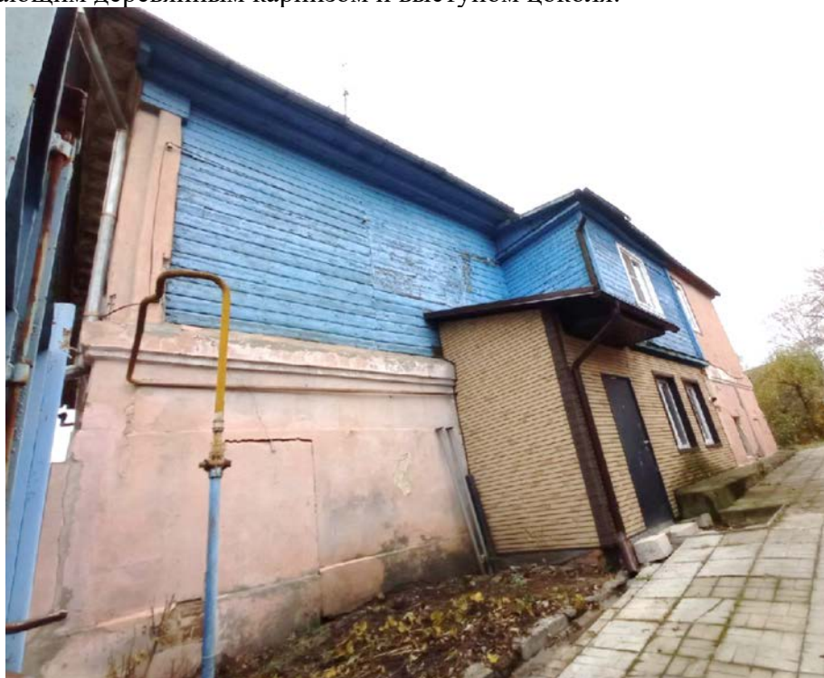
Северный фасад. Общий вид
