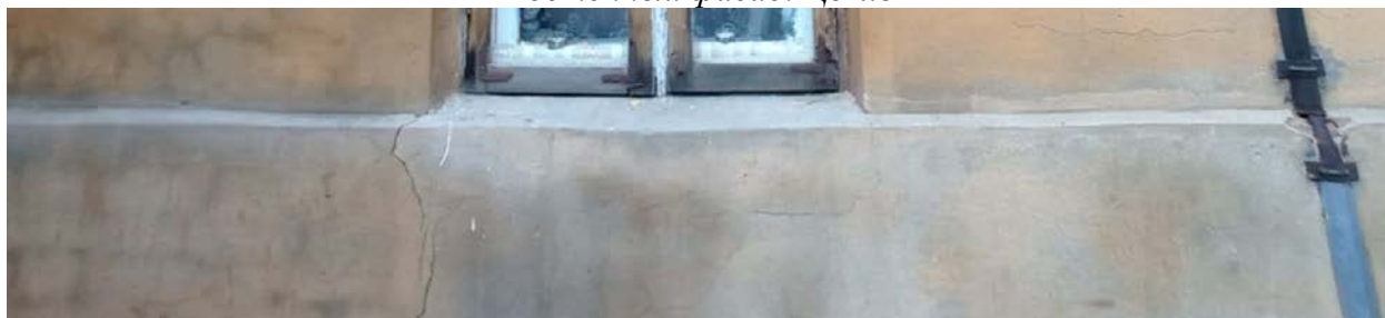
Восточный фасад. Цоколь
