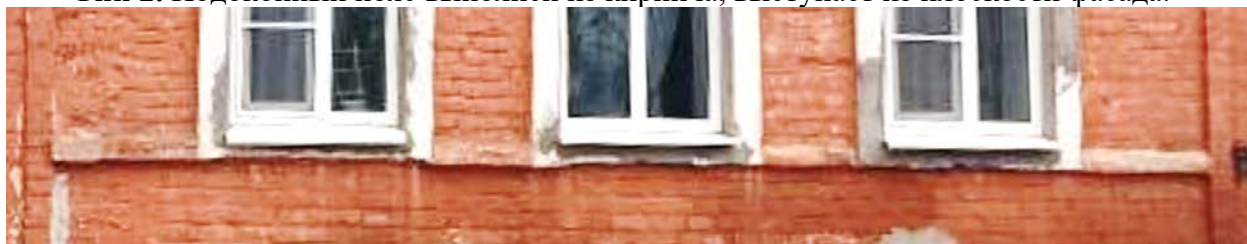
Восточный фасад. Подоконный пояс
