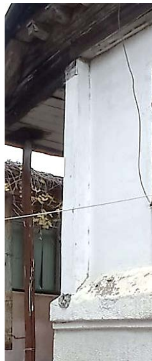
Западный фасад. Лопатка второго этажа
