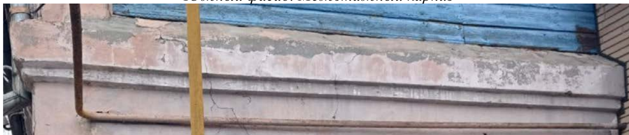
Северный фасад. Межэтажный карниз
