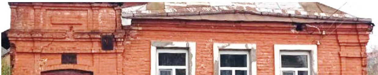
Восточный фасад. Венчающий карниз
