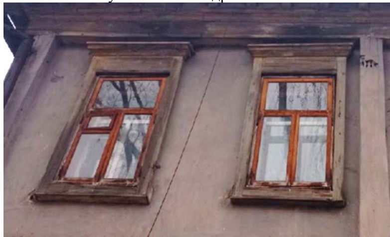
Восточный фасад. Оконные проемы второго этажа
