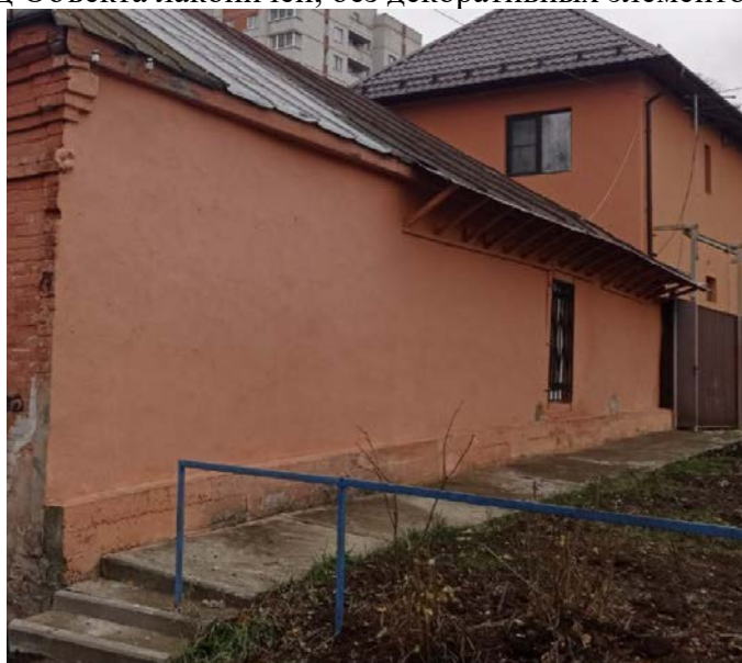
Северный фасад. Общий вид
