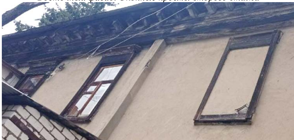
Южный фасад. Оконные проемы второго этажа
