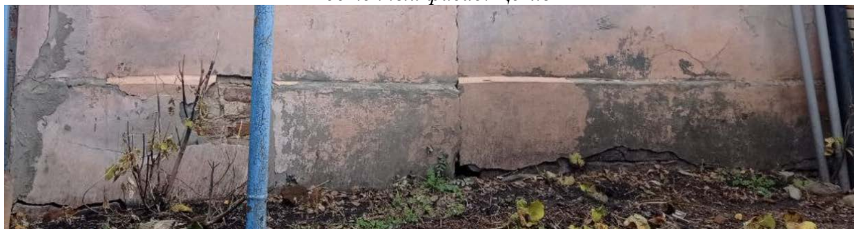
Северный фасад. Цоколь
