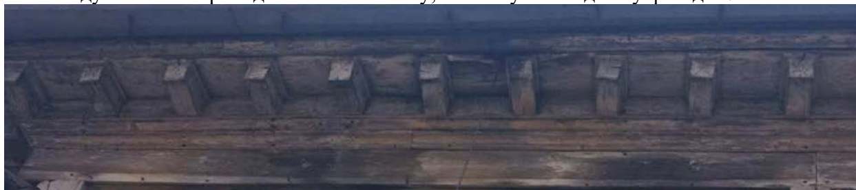
Восточный фасад. Венчающий карниз
