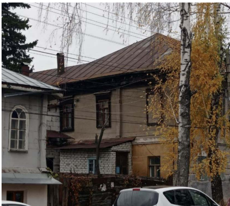
Фрагмент южного фасада. Общий вид
