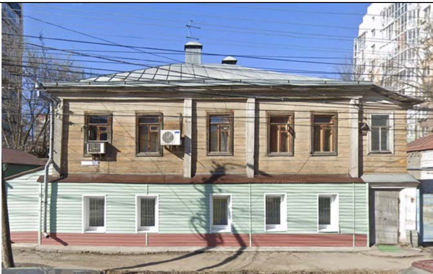
Жилой дом. Ул. Карла Либкнехта, 12
