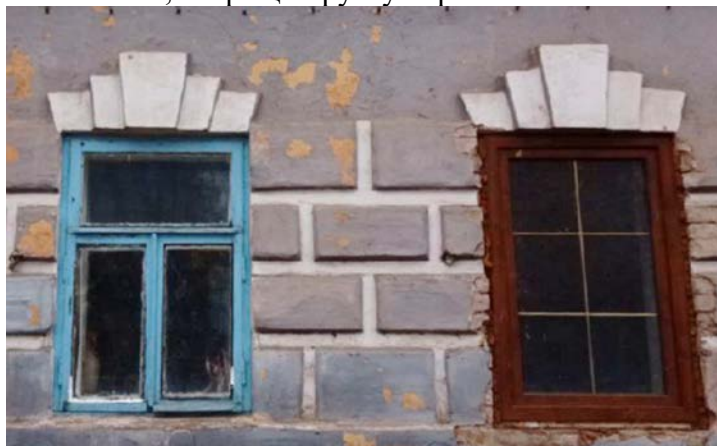
Дом № 30. Восточный фасад. Оконные проемы первого этажа
