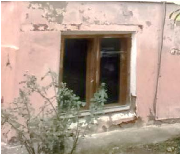
Западный фасад. Оконный проем первого этажа
