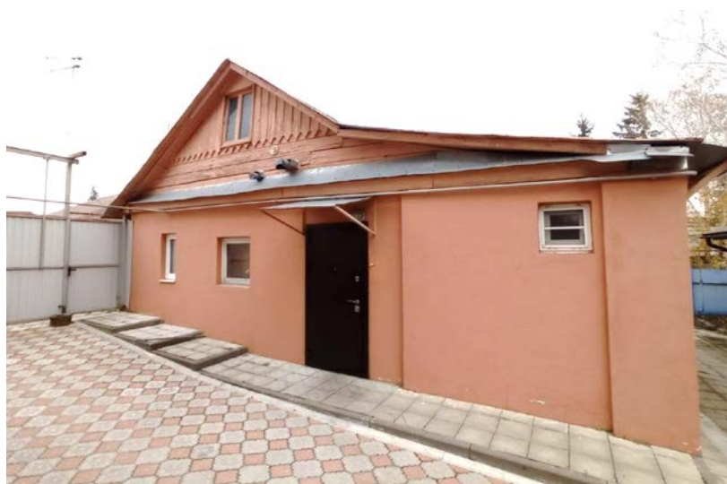
Западный фасад. Общий вид
