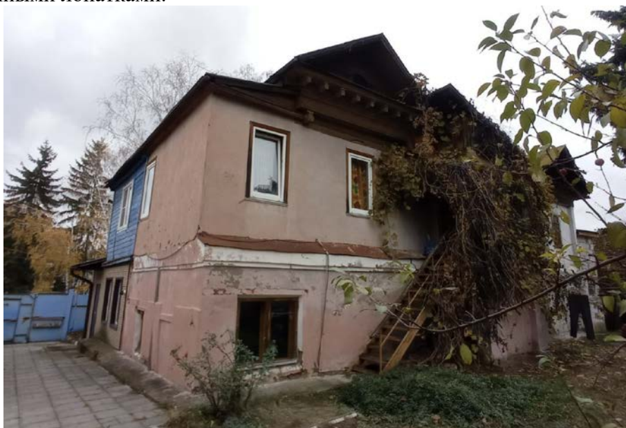
Фрагмент южного фасада. Общий вид
