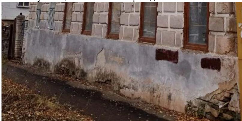
Восточный фасад. Цоколь
