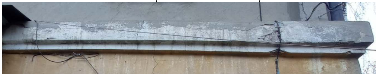
Южный фасад. Межэтажный карниз
