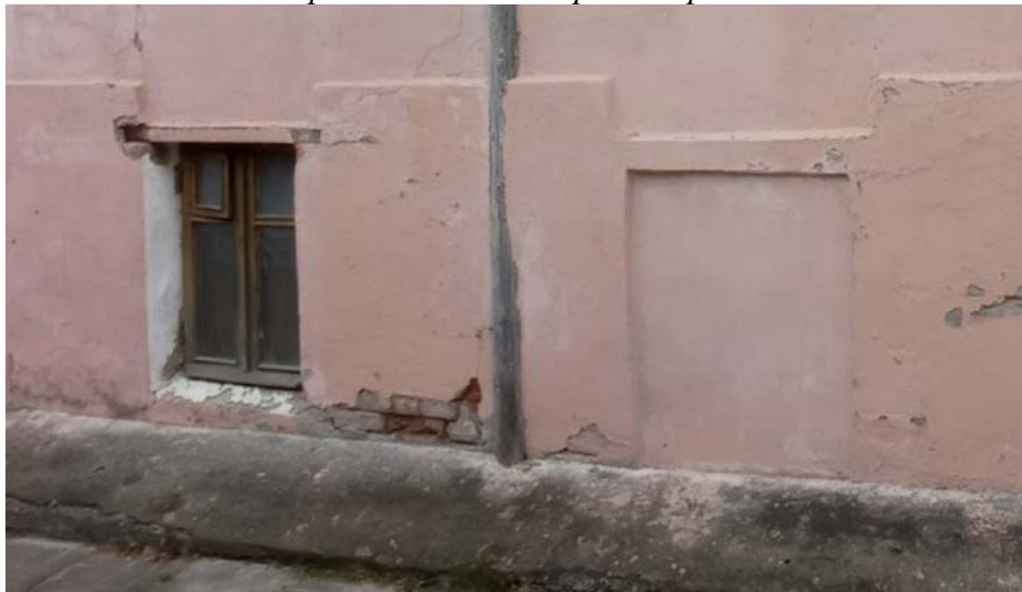
Северный фасад. Оконные проемы первого этажа
