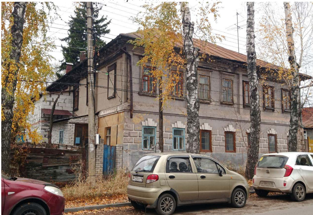
Фото 2. Выявленный объект культурного наследия «Главный дом», г. Курск, ул. Карла Либкнехта, 30, входящий в состав ансамбля «Городская усадьба М.В. Пузанова, конец XIX – нач. XX вв.: - Главный дом, - Флигель», г. Курск, ул. Карла Либкнехта, 30, 30а. Южный и восточный фасады. Фото Коротеевой Е.В. 11.11.2024 г.
