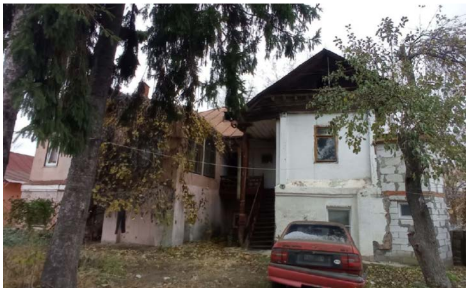
Южный фасад. Общий вид
