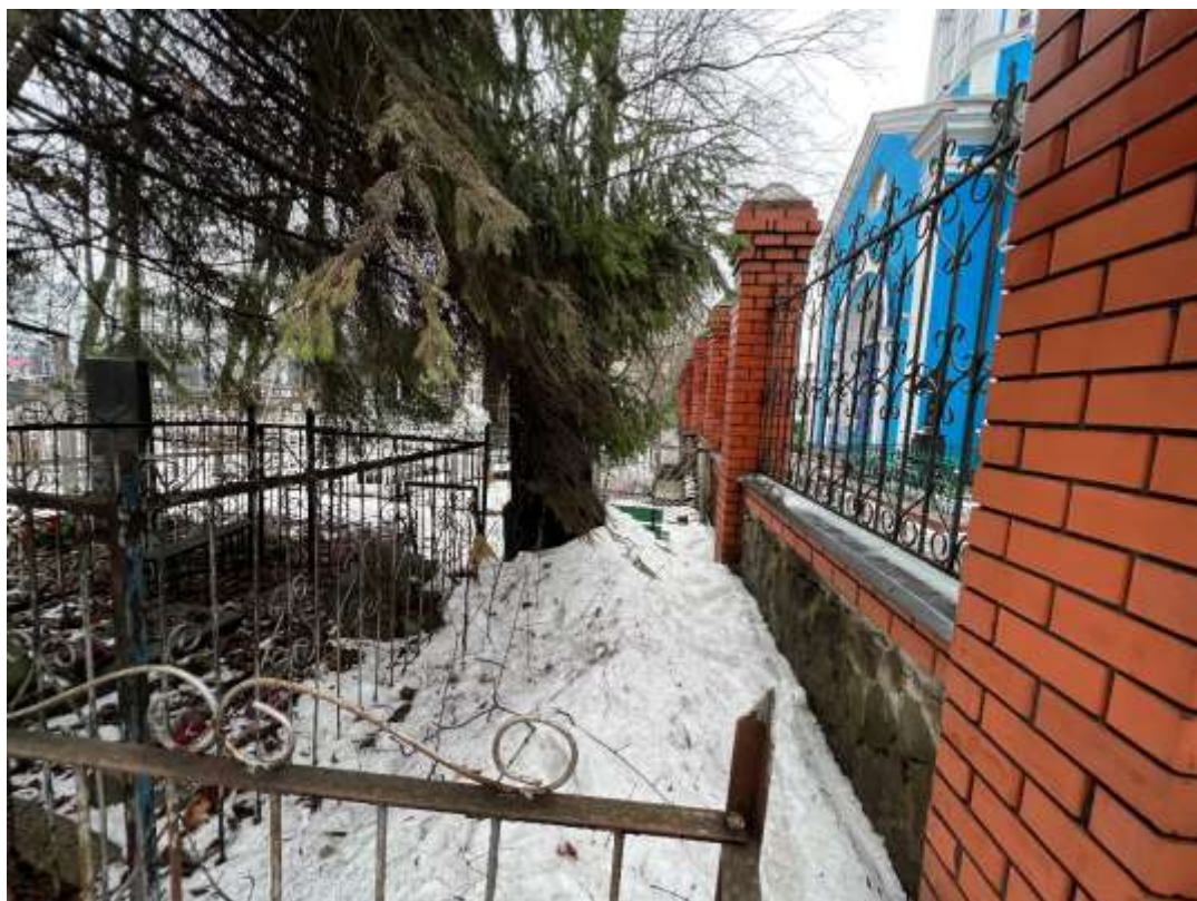
Фотография № 1. Вид с юго-запада на Объект.
