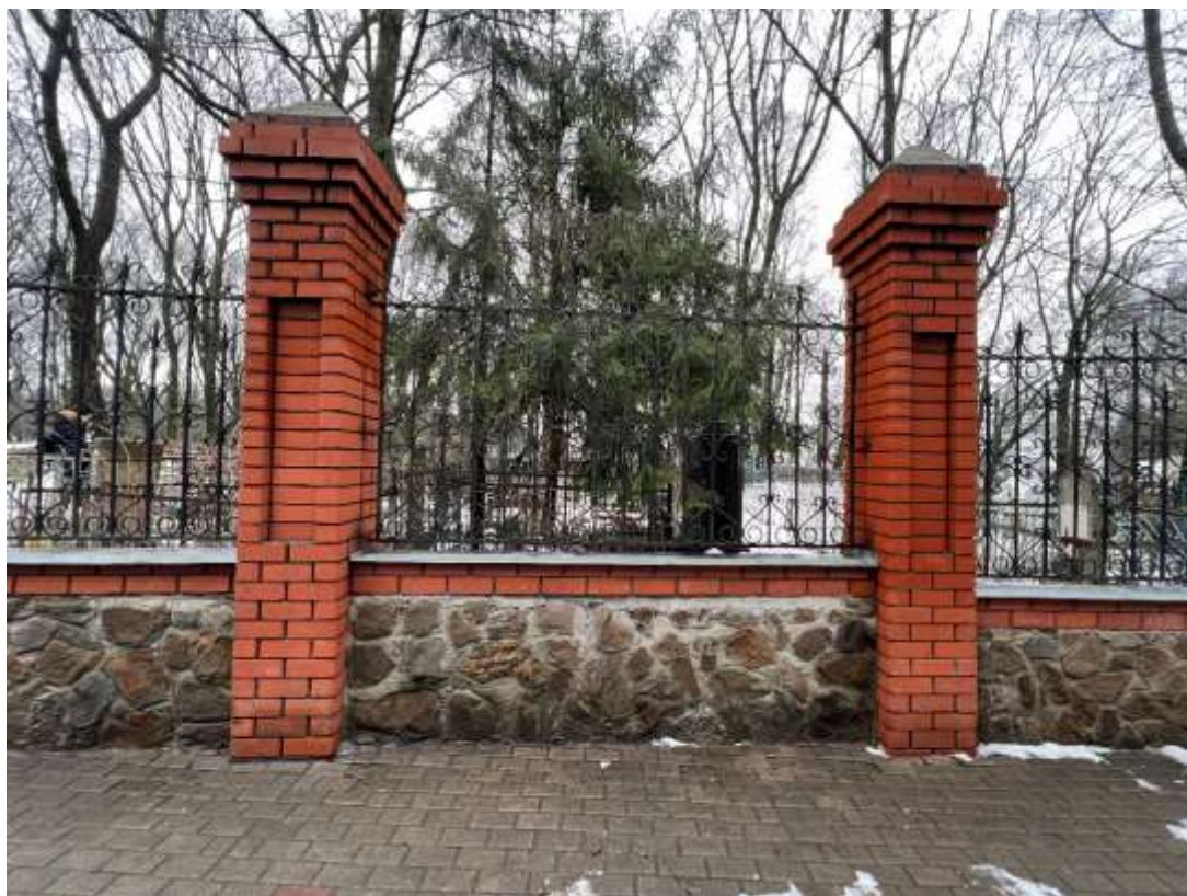
Фотография № 9. Вид с юго-востока на Объект.
