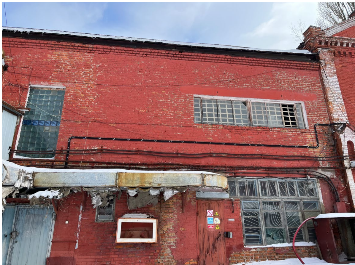
Выявленный объект культурного наследия «Производственный корпус-2», 1904 г., расположенный по адресу: Курская область, г. Курск, ул. Халтурина, 16, входящий в состав выявленного объекта культурного наследия «Ансамбль спиртзавода Сперанского», 1904 г., расположенного по адресу: Курская область, г. Курск, ул. Халтурина, 16
