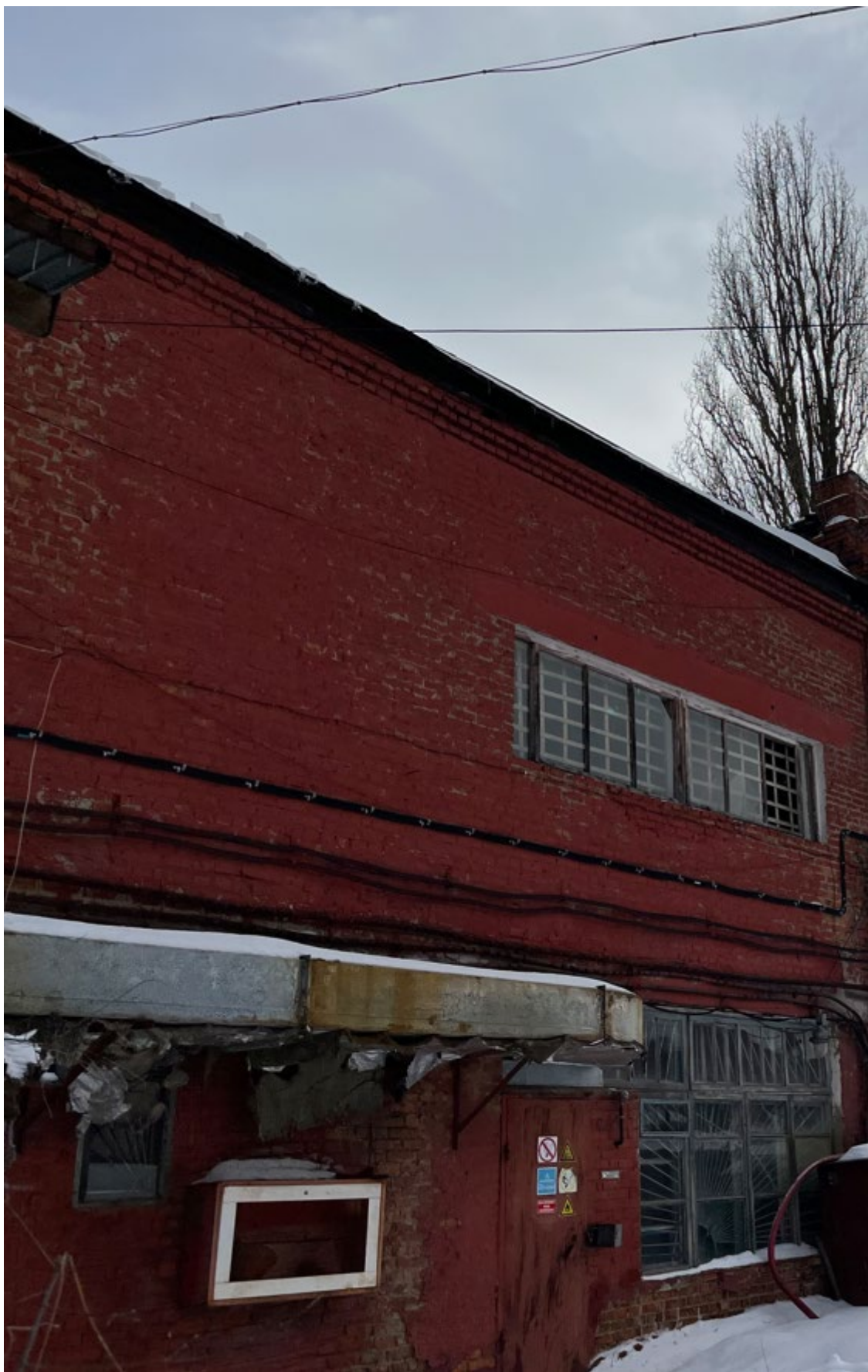
Т.ф. 3. Общий вид на Объект
